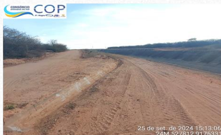
Segmento de Canal( WBS 1231)
