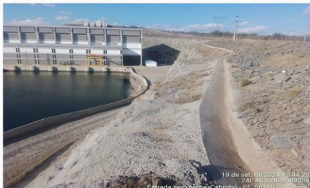
Estação de bombeamento EBI-2( WBS 1620)
