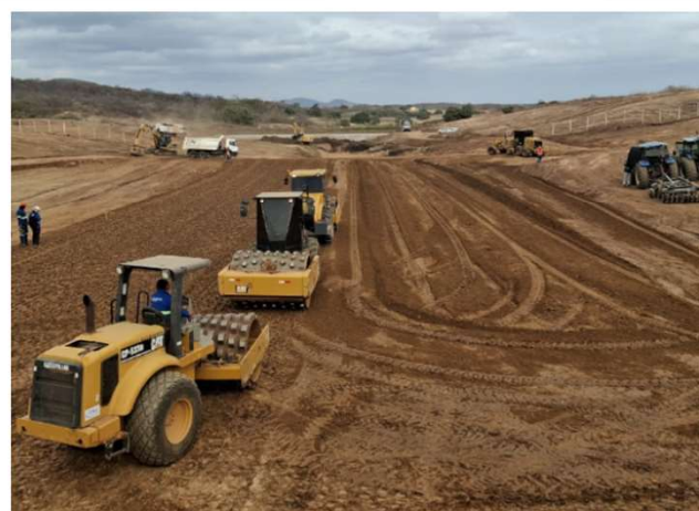
FOTO 08 - FRENTE DE SERVIÇO - WBS 3205
