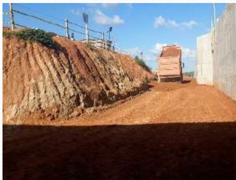
Execução do aterro compactado
