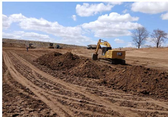
FOTO 05 - FRENTE DE SERVIÇO - WBS 3205
