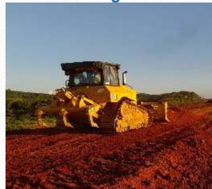
Execução de aterro compactado
