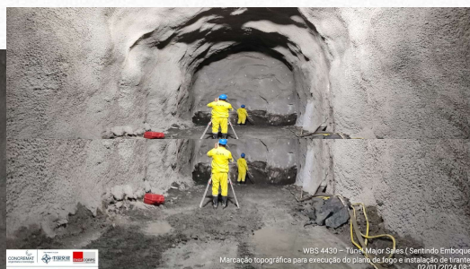
Marcação topográfica e execução de bate choco;
