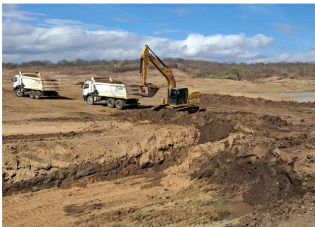
FOTO 07 - FRENTE DE SERVIÇO - WBS 3205
