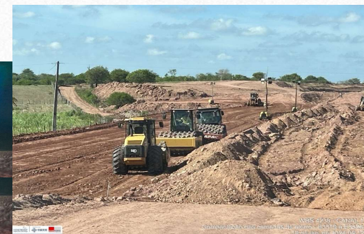
Execução de aterro compactado (diurno e noturno).
