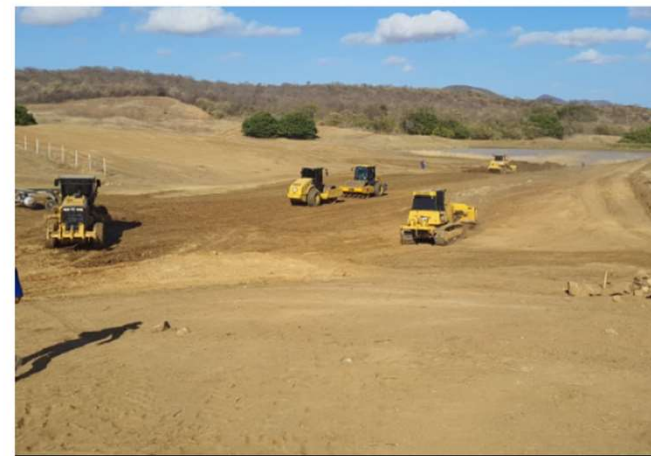
FOTO 06 - FRENTE DE SERVIÇO - WBS 3205
