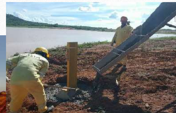
Instalação da régua linimétrica
