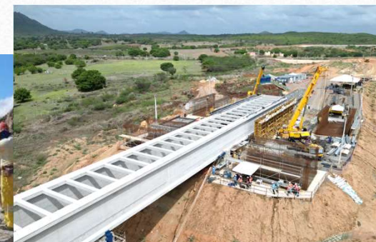
Empurramento do Módulo 6 - Superestrutura
