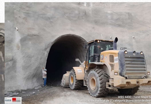
WBS 4430 - Túnel Major Sales Emboque Perfuração com Jumbo 6.491837588,375349W +44.82m 19/01/2024 15:52 Altitude: 24.72m Velocidade: 0.00m/h WBS 4430 - Túnel Major Sales Remoção de material de 3ª categoria proveniente de desmo 22/01/2024 12:48 Perfuração com Jumbo e remoção de material de 3ª categoria;
