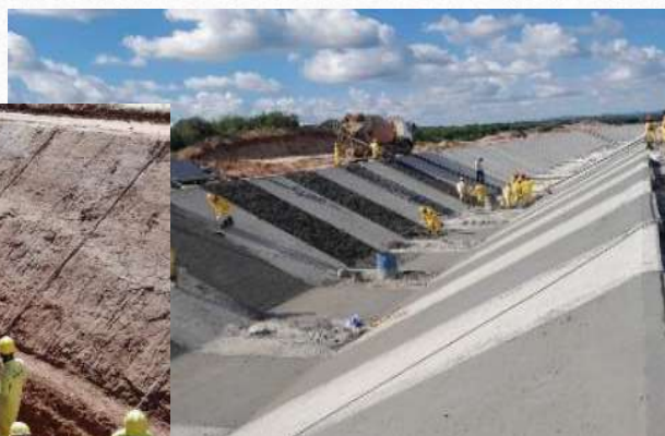
Execução das placas de proteção.
