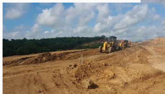
Execução do aterro compactado
