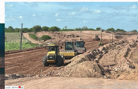
Execução de aterro compactado (diurno e noturno).
