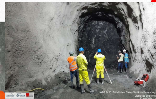
WBS 4430 - Túnel Major Sales (Sentindo Desemboque) Liberação do primitivo. 22/01/2024 12:48 WBS 4430 - Túnel Major Sales (Sentindo Desemboque) Ponto de convergência/linha de referência da 600 (Túnel) 17-1ME 23/01/2024 14:21 Leitura diária da topografia;
