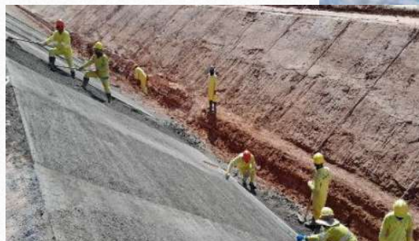
Regularização do talude interno
