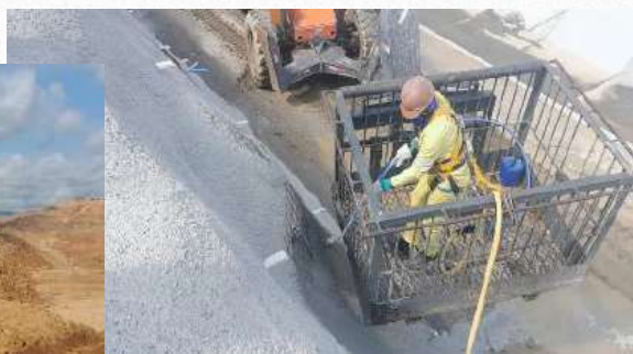
Execução do concreto projetado
