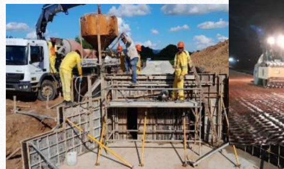
Concretagem da ala montante no Bueiro 13.
