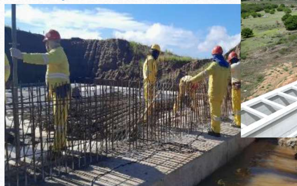
Aqueduto Pedra Preta
