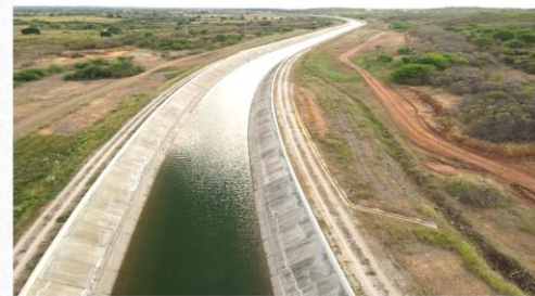
Segmento de Canal CN17 ( WBS 1224)
