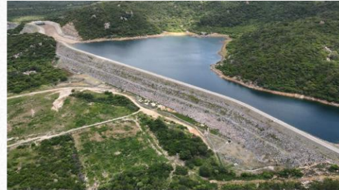
Reservatório Negreiros ( WBS 1109)
