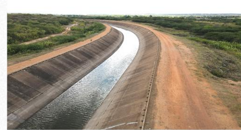
Segmento de Canal ( WBS 1229)
