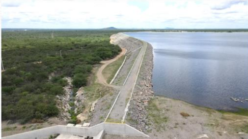
Reservatório Tucutu ( WBS 1105)
