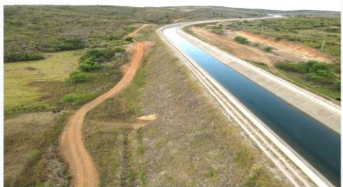
Segmento de Canal CN17 ( WBS 1224)
