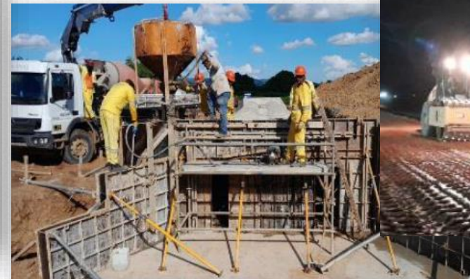
Concretagem da ala montante no Bueiro 13.
