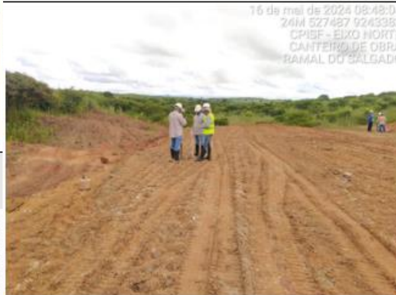
Foto 48: Canteiro de obras do Consórcio ENGIBRAS/SMF. Conferência de cota pela equipe de topografia.
