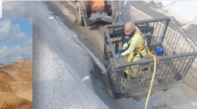
Execução do concreto projetado
