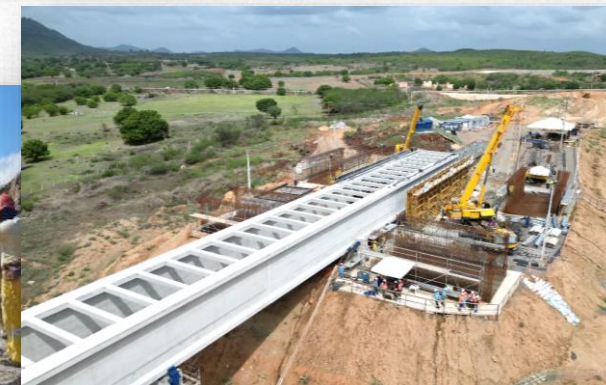
Empurramento do Módulo 6 - Superestrutura
