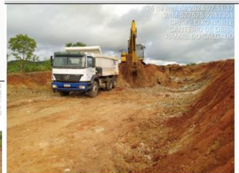
Foto 44: Canteiro de obras do Consórcio ENGIBRAS/SMF. Compactação de solo.
