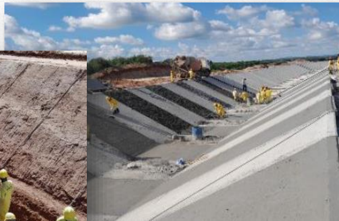
Execução das placas de proteção.
