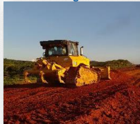
Execução de aterro compactado
