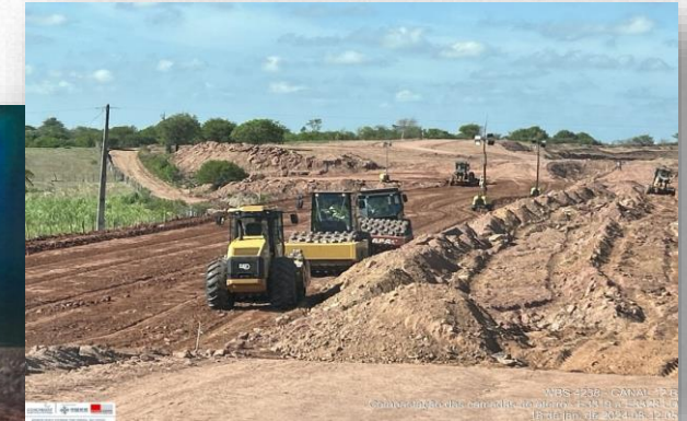
Execução de aterro compactado (diurno e noturno).
