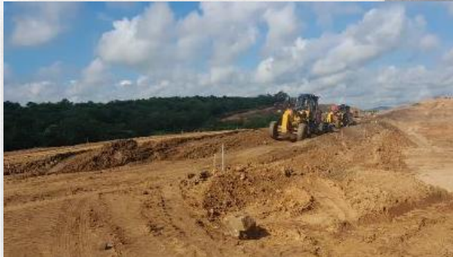
Execução do aterro compactado
