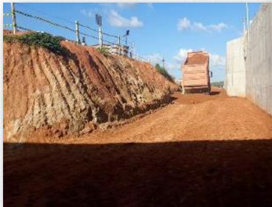
Execução do aterro compactado
