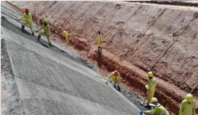
Regularização do talude interno
