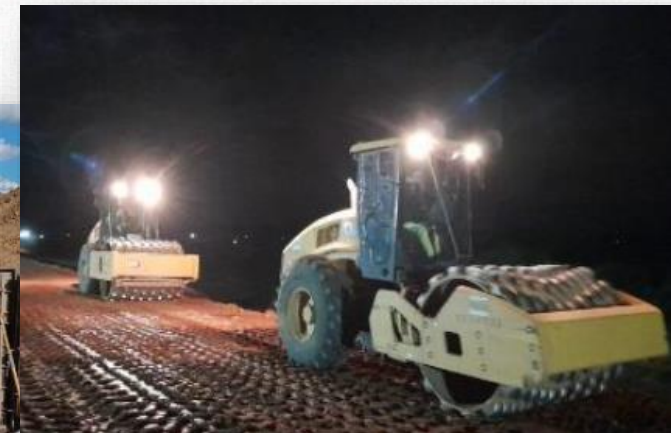
Execução de aterro compactado.
