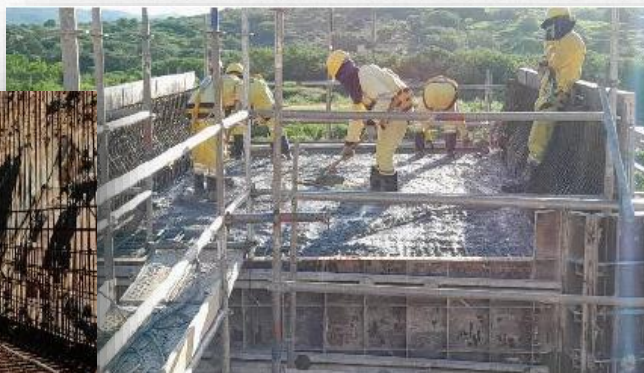
Concretagem Laje superior
