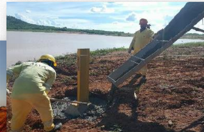
Instalação da régua linimétrica
