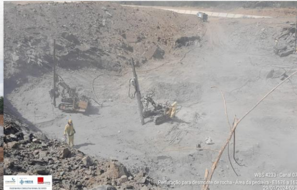
Enrocamento compactado; Perfuração para desmorte de rocha.
