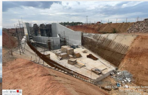
Vista jusante da estrutura de controle em execução
