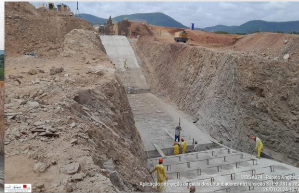
Instalação da estrutura metálica e aplicação de chumbadores
