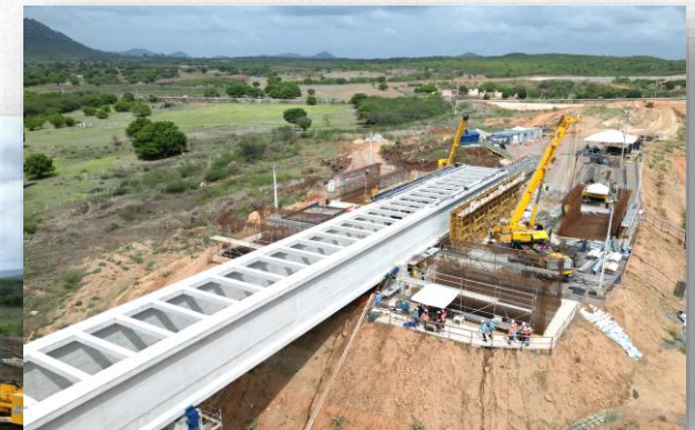
Empurramento do Módulo 6 - Superestrutura
