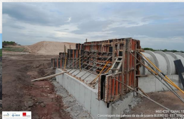
Perfuração para desmorte de rocha; Aplicação de concreto da ala do BU.
