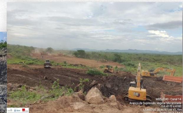
Perfuração para desmorte de rocha; Supressão vegetal;
