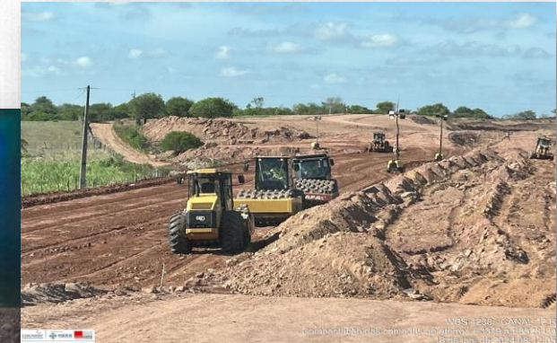
Execução de aterro compactado (diurno e noturno).
