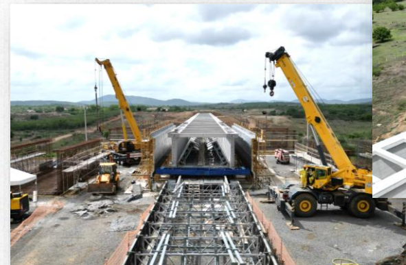
Aqueduto Pedra Preta
