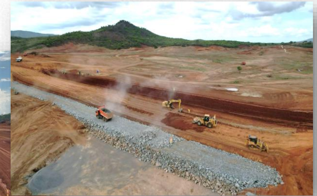
Execução de terraplanagem da barragem principal
