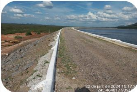
Reservatório Serra do Liramento ( NPS 1107)
