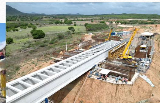
Empurramento do Módulo 6 - Superestrutura
