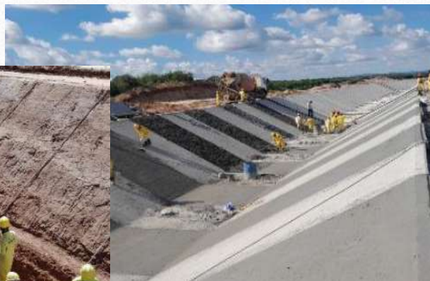
Execução das placas de proteção.
