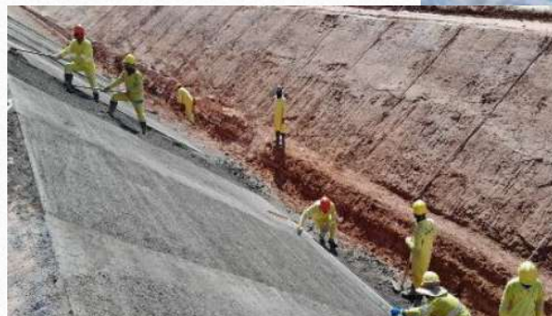
Regularização do talude interno
