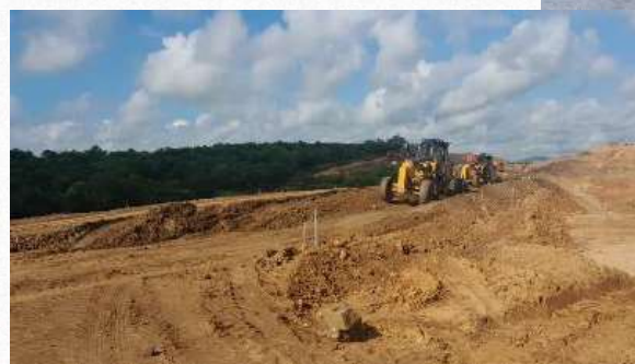
Execução do aterro compactado
