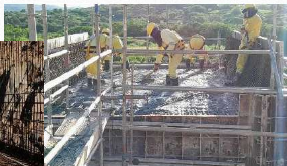
Concretagem Laje superior
