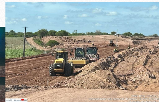
Execução de aterro compactado (diurno e noturno).
