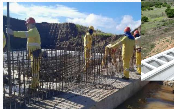
Aqueduto Pedra Preta
