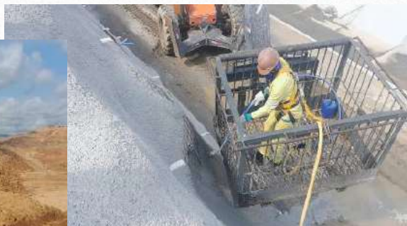
Execução do concreto projetado
