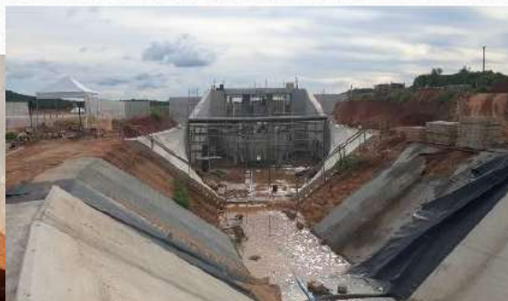
Vista jusante da estrutura de controle em execução
