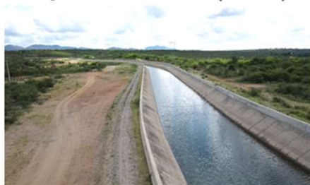
Segmento de Canal CN11 LE ( WPS 1215)
