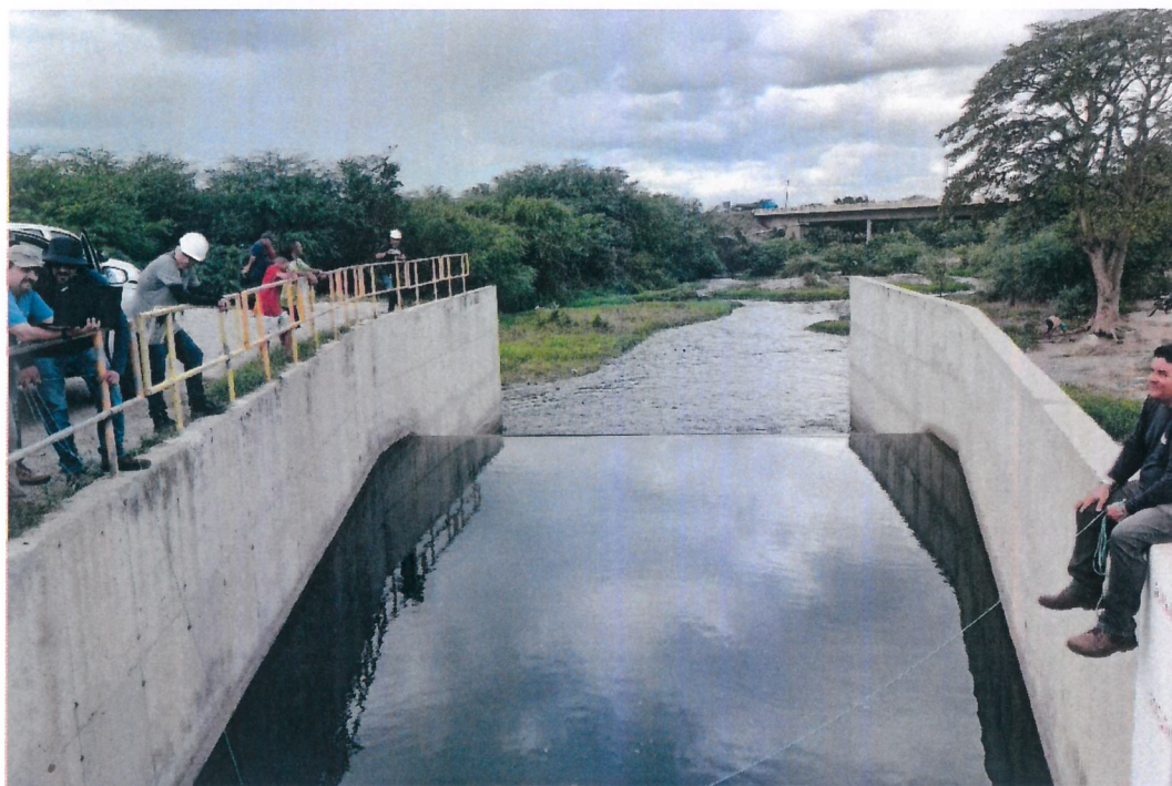
Figura 4 – Desnível da saída da Galeria de Monteiro para o riacho Mulungu, que deságua no rio Paraíba.
