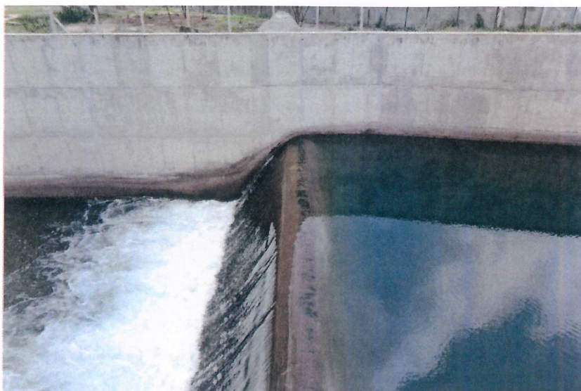
Figura 5 – Desnível da saída da Galeria de Monteiro: vertedouro delgado de soleira livre.
