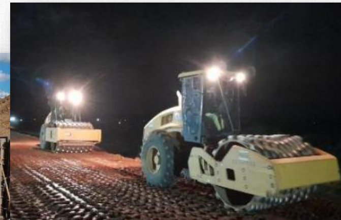
Execução de aterro compactado.
