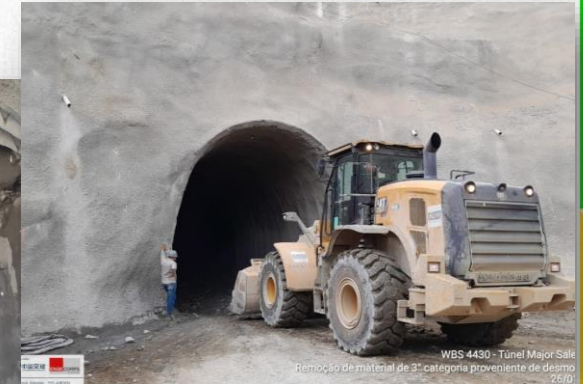
Perfuração com Jumbo e remoção de material de 3ª categoria;
