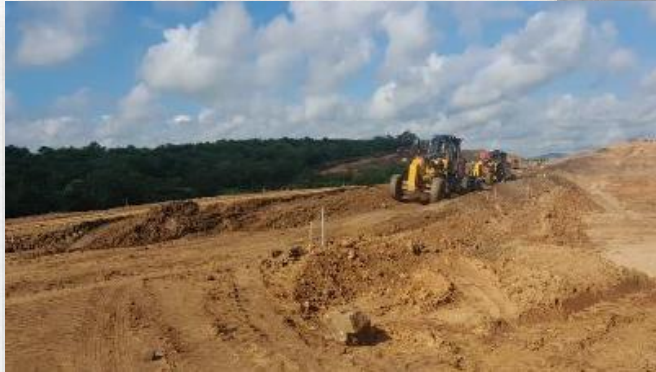
Execução do aterro compactado
