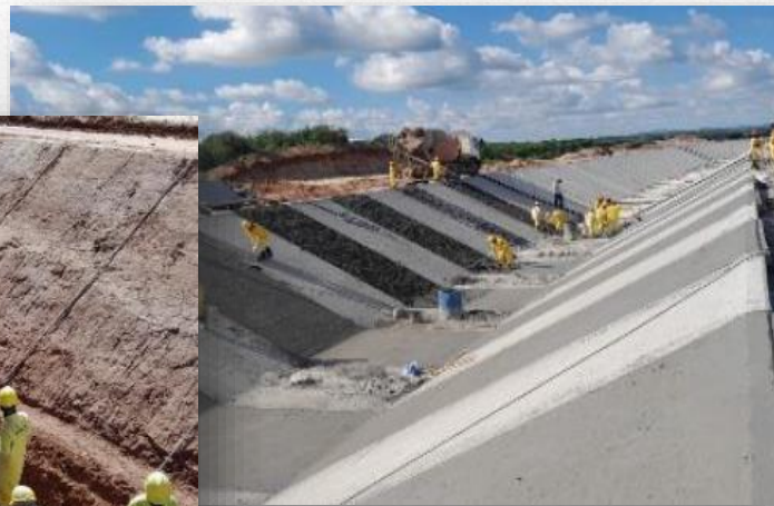
Execução das placas de proteção.
