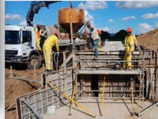
Concretagem da ala montante no Bueiro 13.
