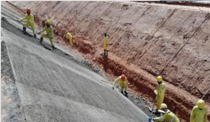
Regularização do talude interno
