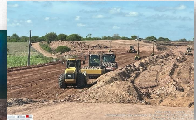
Execução de aterro compactado (diurno e noturno).
