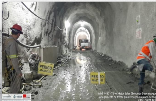
Execução de bate choco e execução do plano de fogo;
