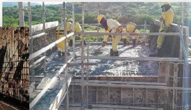
Concretagem Laje superior
