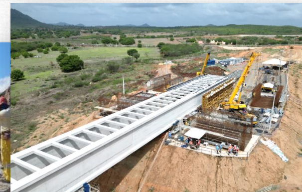
Empurramento do Módulo 6 - Superestrutura
