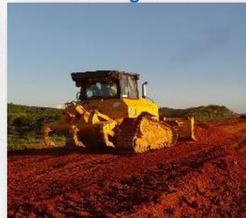
Execução de aterro compactado
