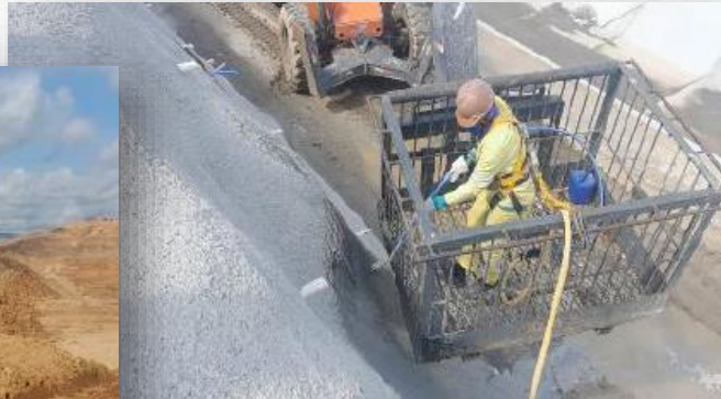
Execução do concreto projetado
