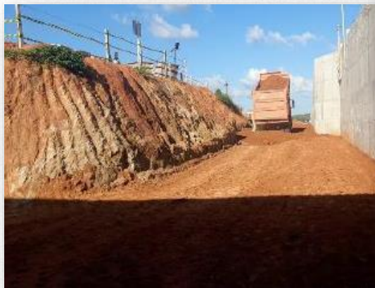
Execução do aterro compactado
