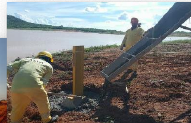
Instalação da régua linimétrica
