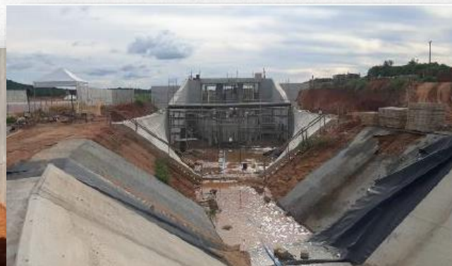
Vista jusante da estrutura de controle em execução
