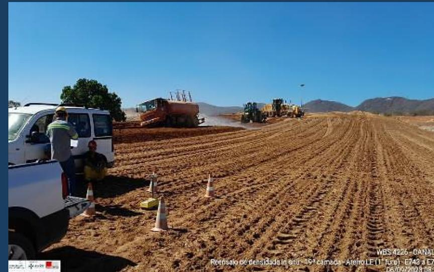
Canal C4: Execução de ensaio da camada de aterro compactado
