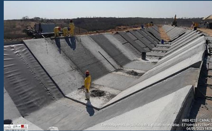
Canal C9: Revestimento de proteção mecânica
