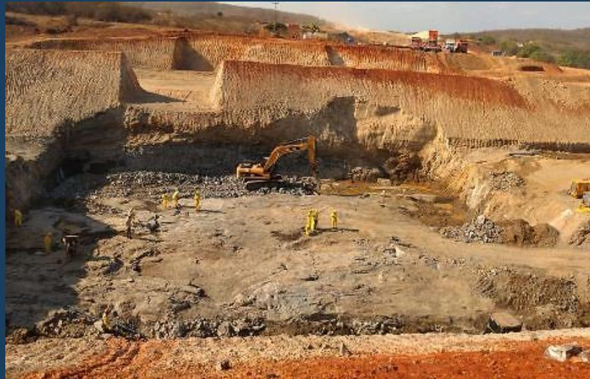
Barragem Tambor: Execução de limpeza do vertedouro
