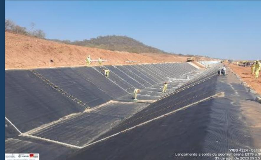
Canal C2: Lançamento e solda da geomembrana
