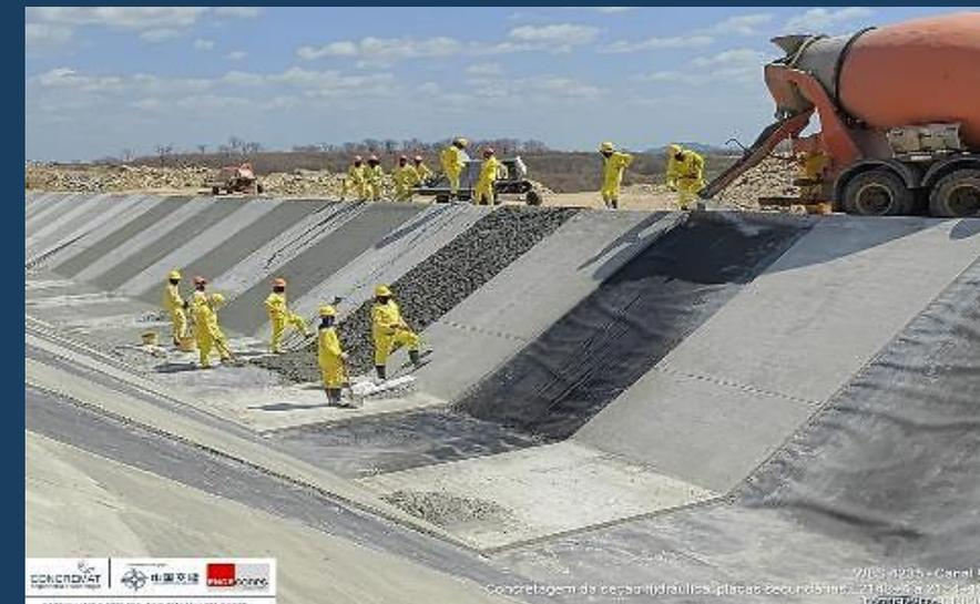
Canal C2: Revestimento de proteção mecânica
