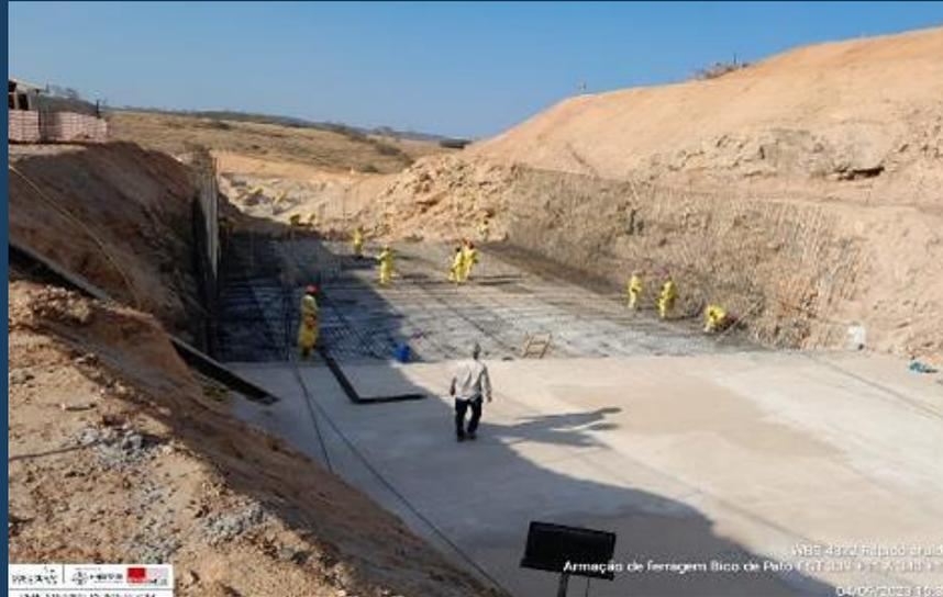
Rápido Arruído: Execução da armação do bico de pato
