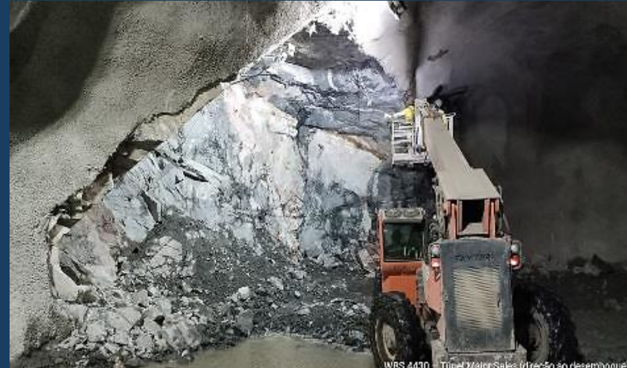
Túnel Major Sales: Execução da escavação (bata choco)
