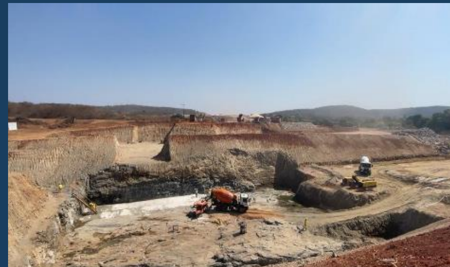
Regularização do Muro Lateral do Vertedouro
