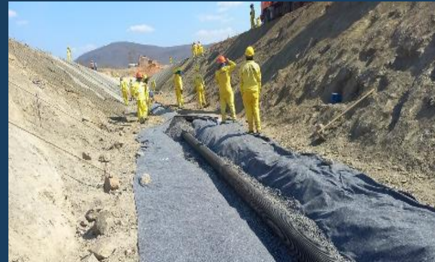
Canal C3: Execução de dreno de fundo
