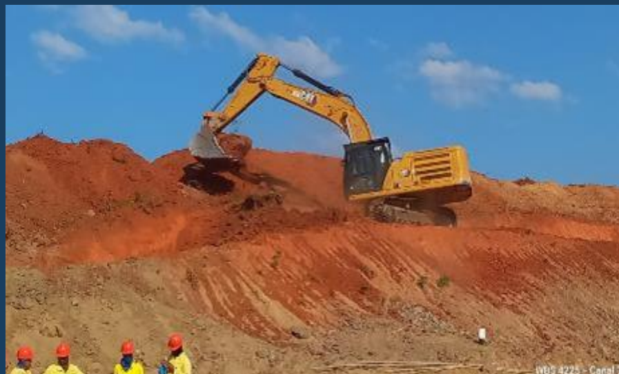
Canal C3: Tratamento do Talude Externo
