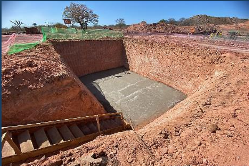
Aq. Lagoa Vermelha: Regularização para implantação da sapata do Eixo 04
