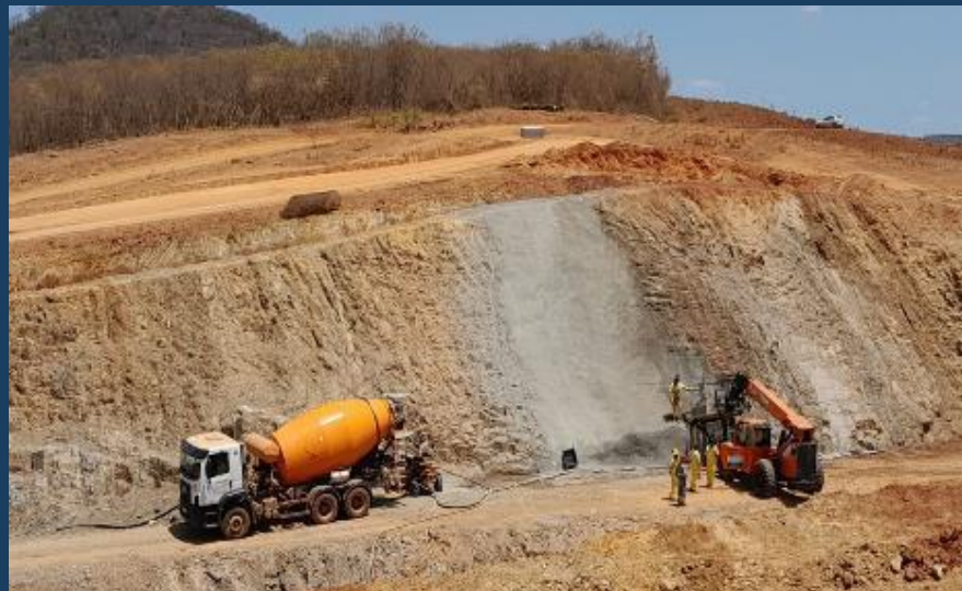
Canal C2: Tratamento de Talude externo com concreto projetado
