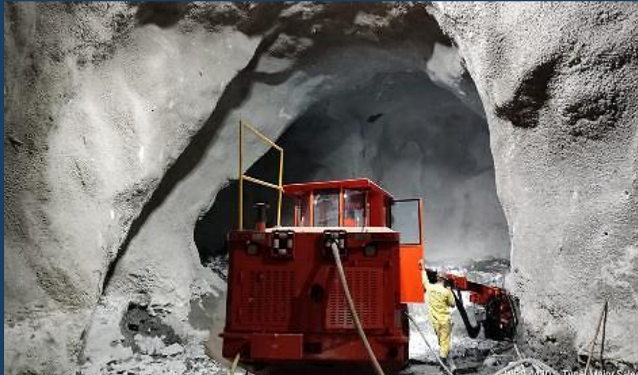
Túnel Major Sales: Execução da escavação
