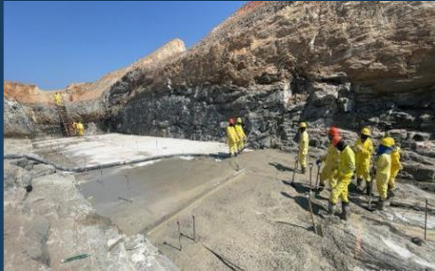
Barragem Tambor: Regularização na fundação do Vertedouro
