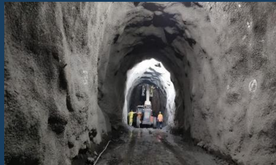
Túnel Major Sales: Instalação de tirantes
