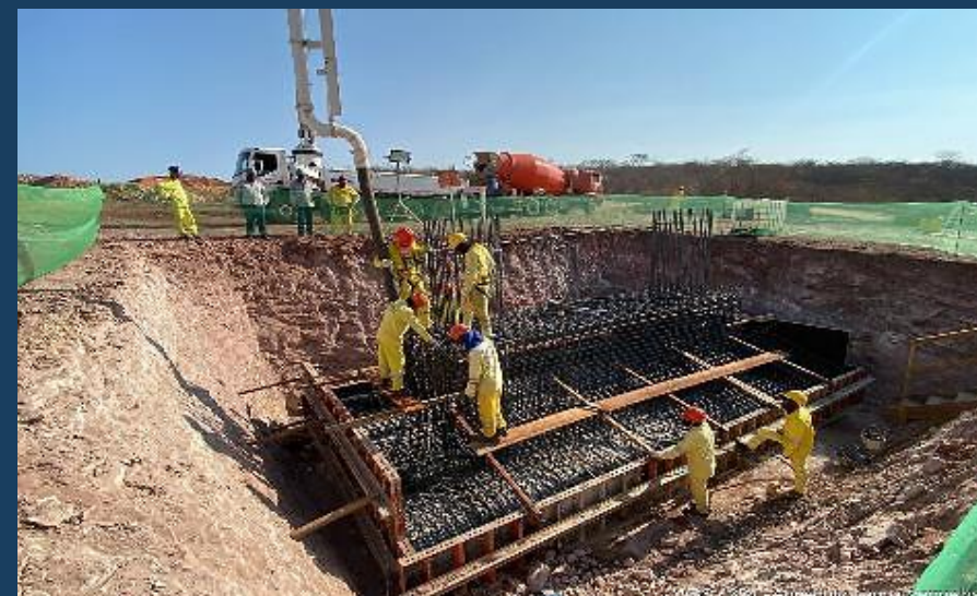
Aq. Lagoa Vermelha: Regularização para implantação da sapata do Eixo 01
