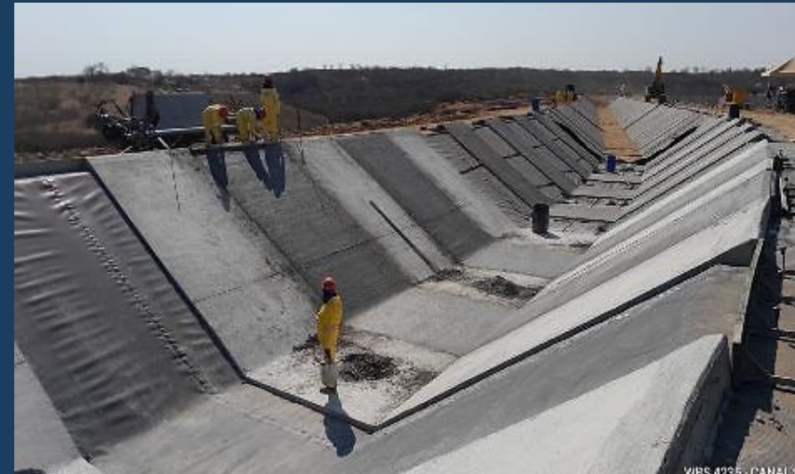
Canal C9: Revestimento de proteção mecânica
