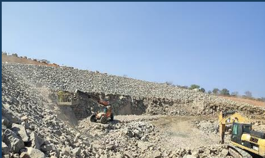
Túnel Major Sales: Execução da escavação no emboque do túnel
