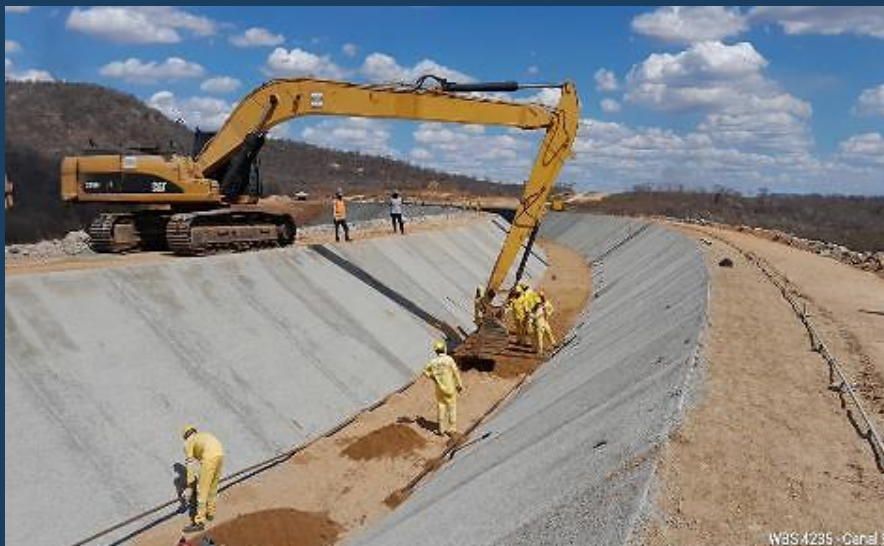
Canal C9: Execução de colchão drenante
