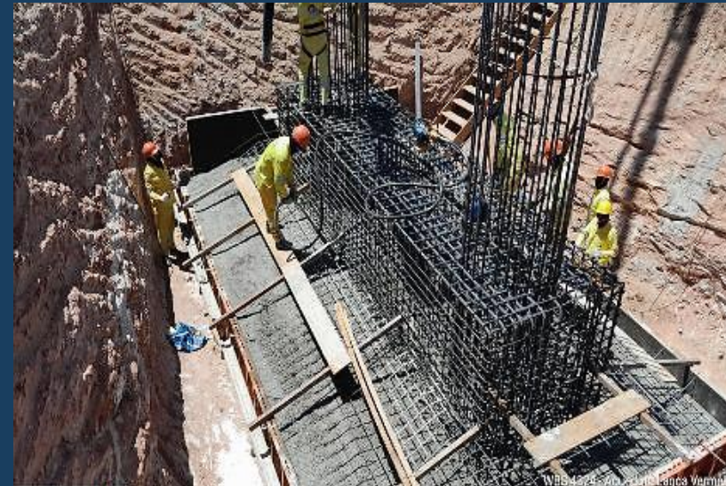
Aq. Lagoa Vermelha: Concretagem da 1ª etapa da sapata do Eixo 05
