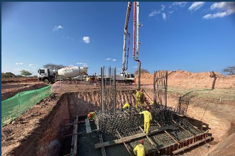
Aq. Lagoa Vermelha: Concretagem da 1ª etapa da sapata do Eixo 06
