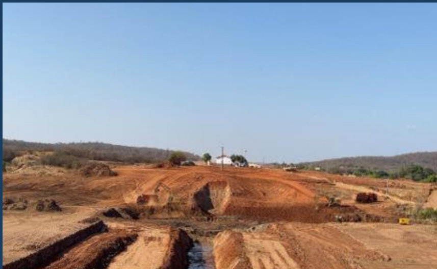
Escavação da Barragem Principal
