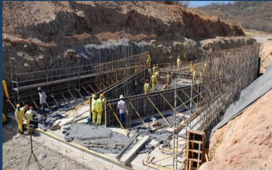
Rápido Arruído: Montagem da forma para concretagem do 1ª Etapa das redes do Bico de Pato
