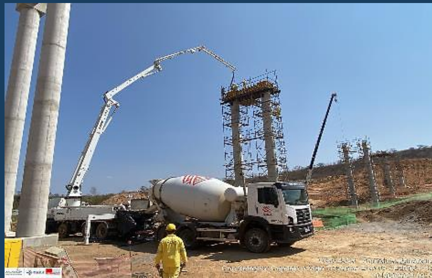
Aqueduto Bananeira: Concretagem dos capitéis e viga travessa do Eixo 05
