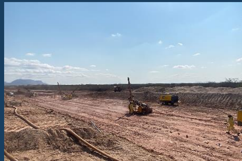
Canal C12: Escavação (desmonte de rocha)
