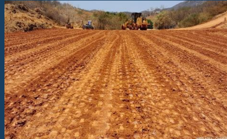
Canal C2: Execução de Aterro Compactado
