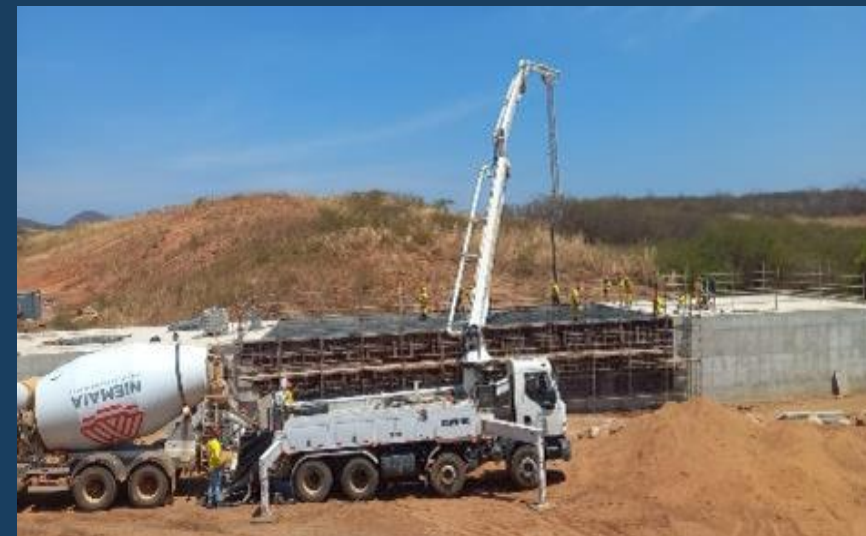
Bueiro 01 - Concretagem das Paredes e Laje superior do módulo 4
