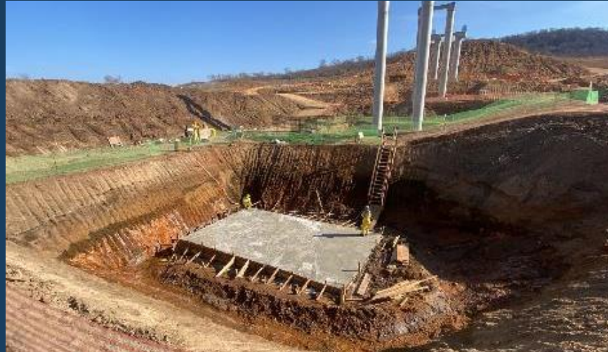
Aqueduto Bananeira: Regularização para locação da sapata do Eixo 04
