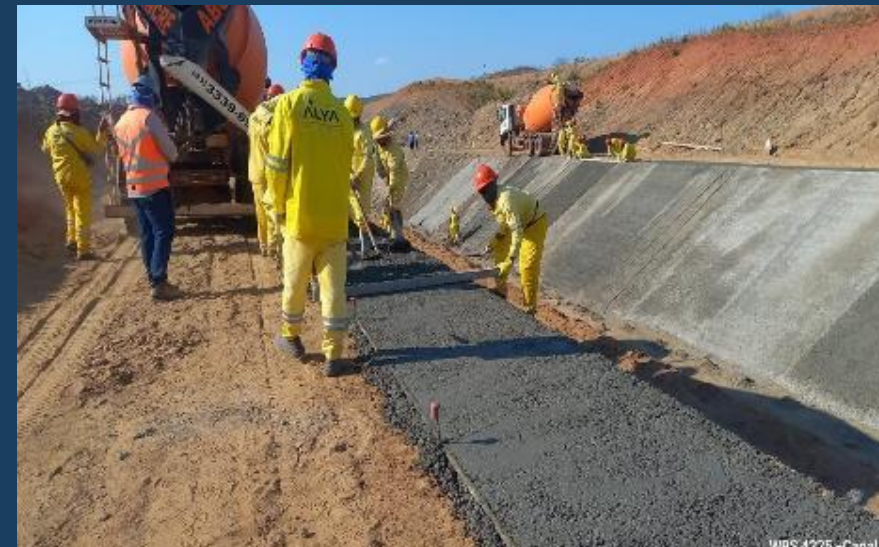
Execução da Geomembrana
