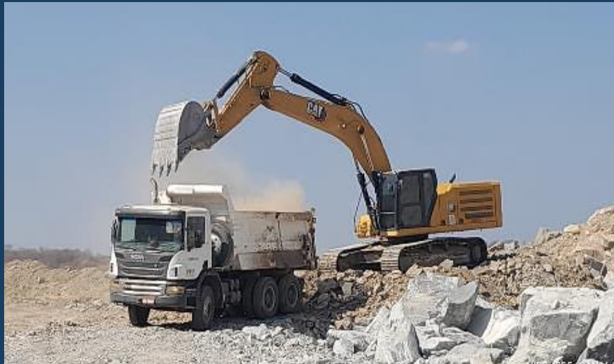
Canal C9: Execução de escavação
