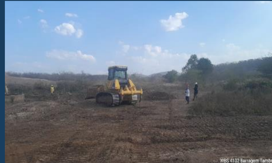
Canal C5: Execução da Supressão Vegetal
