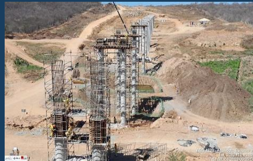
Aqueduto Bananeira: Vista do aqueduto
