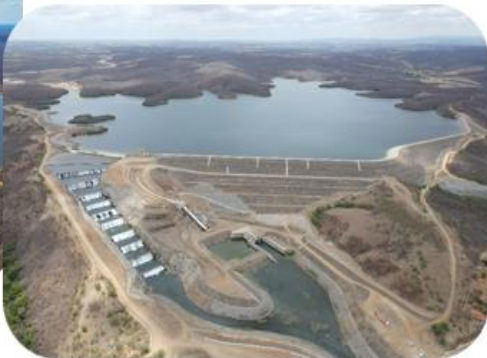
Reservatório Jati (WBS 1111) Roço - 220.133,85m 2
