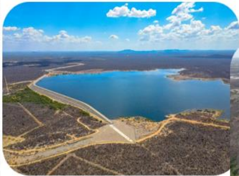
Reservatório Tucutú (WBS 1105) Roço - 84.828,07m 2
