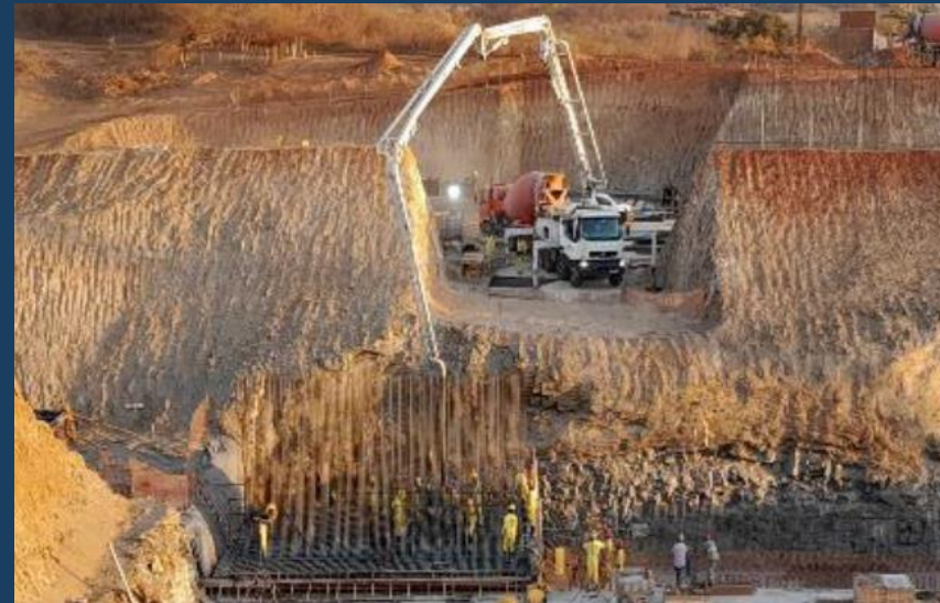
Concretagem do Muro Lateral esquerdo do Vertedouro
