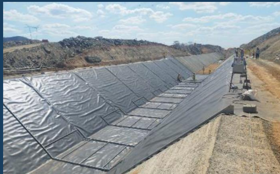
Execução da Geomembrana
