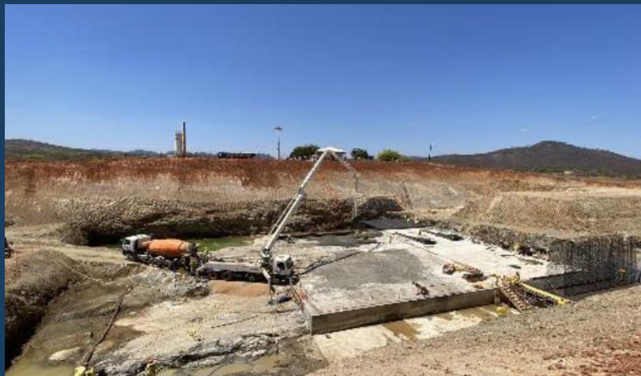
Barragem Tambor: Regularização na fundação do Vertedouro
