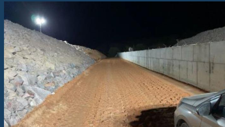
Execução do Bueiro 02
