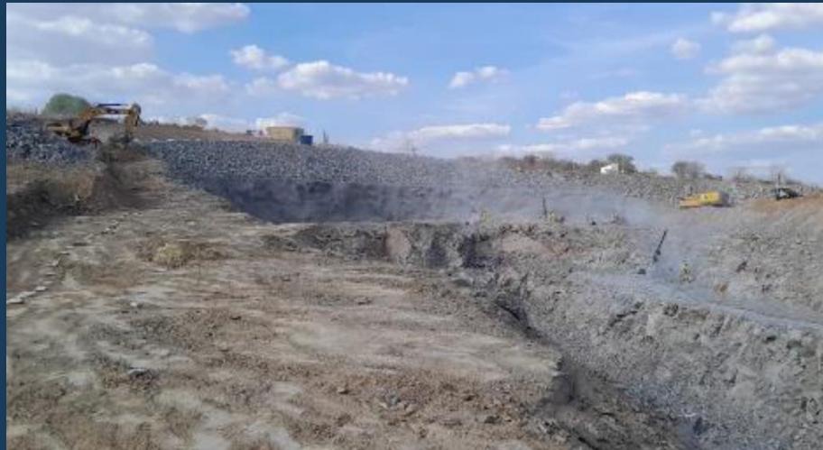
Execução da escavação no Emboque do Túnel
