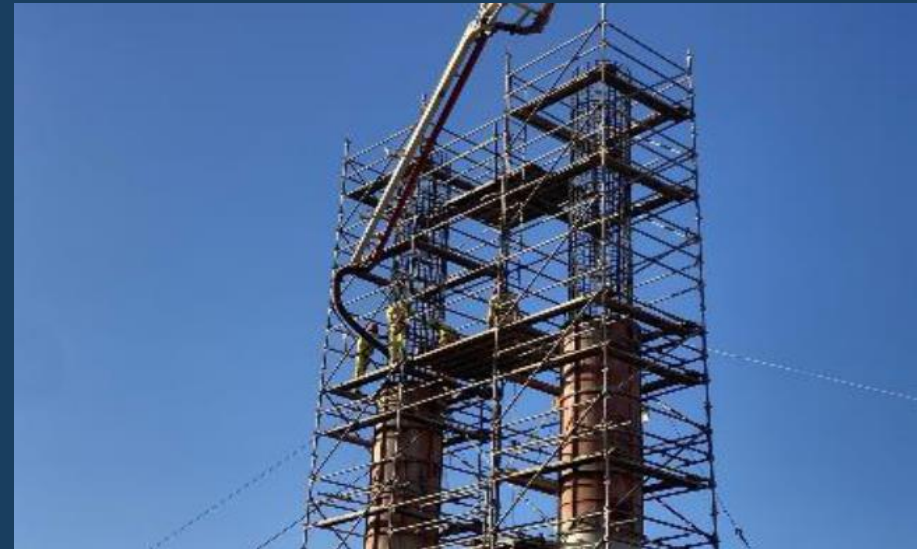
Aqueduto Bananeira: Concretagem da 4ª Etapa dos pilares
