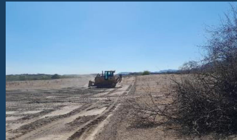
Execução de Supressão Vegetal
