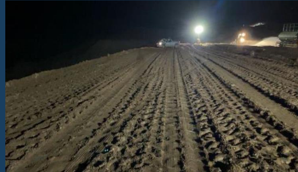
Canal C2: Execução de Aterro Compactado
