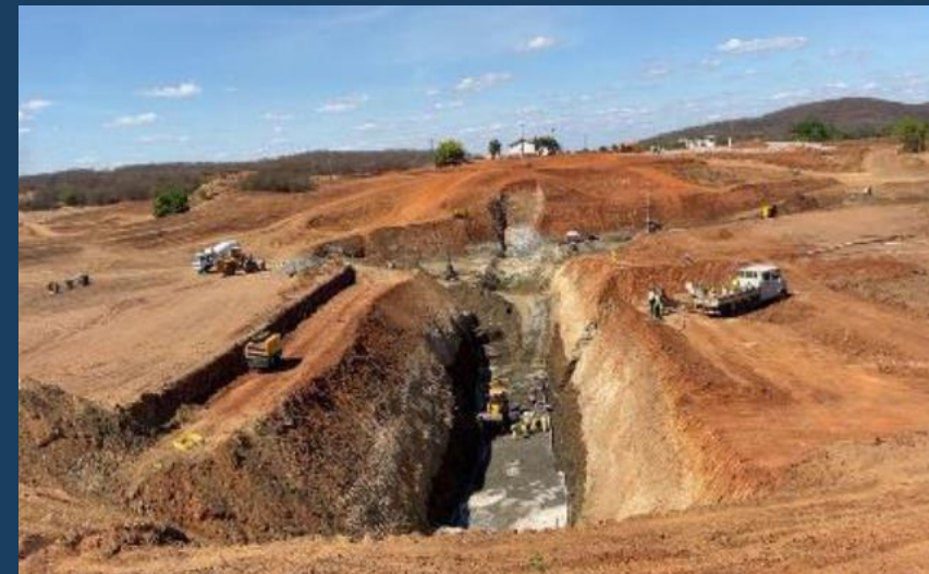
Regularização do Muro Lateral do Vertedouro
