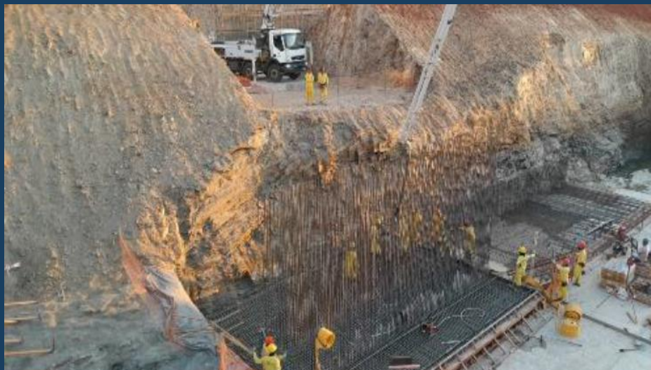
Escavação da Barragem Principal
