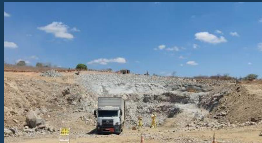
Desmonte de Rocha no Emboque do Túnel
