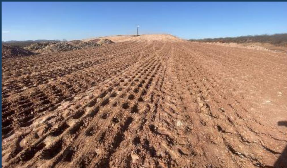
Execução de Aterro Compactado
