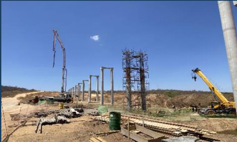
Aqueduto Bananeira: 4ª Etapa dos pilares
