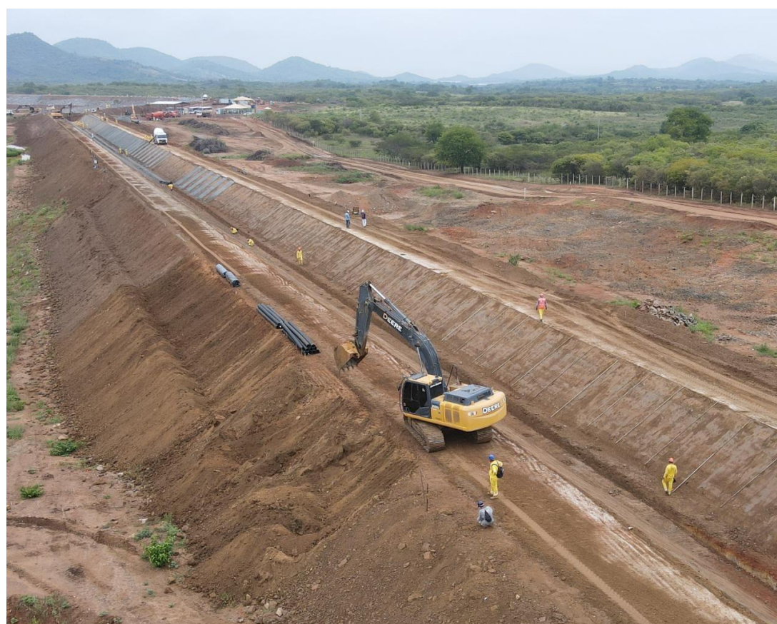
Execução de Canal
