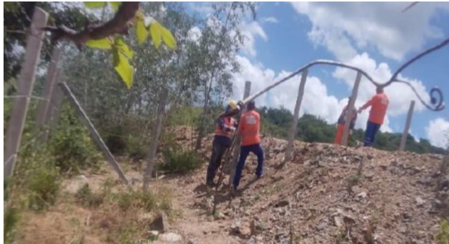
EBVII-1: Cercamento do canteiro avançado
