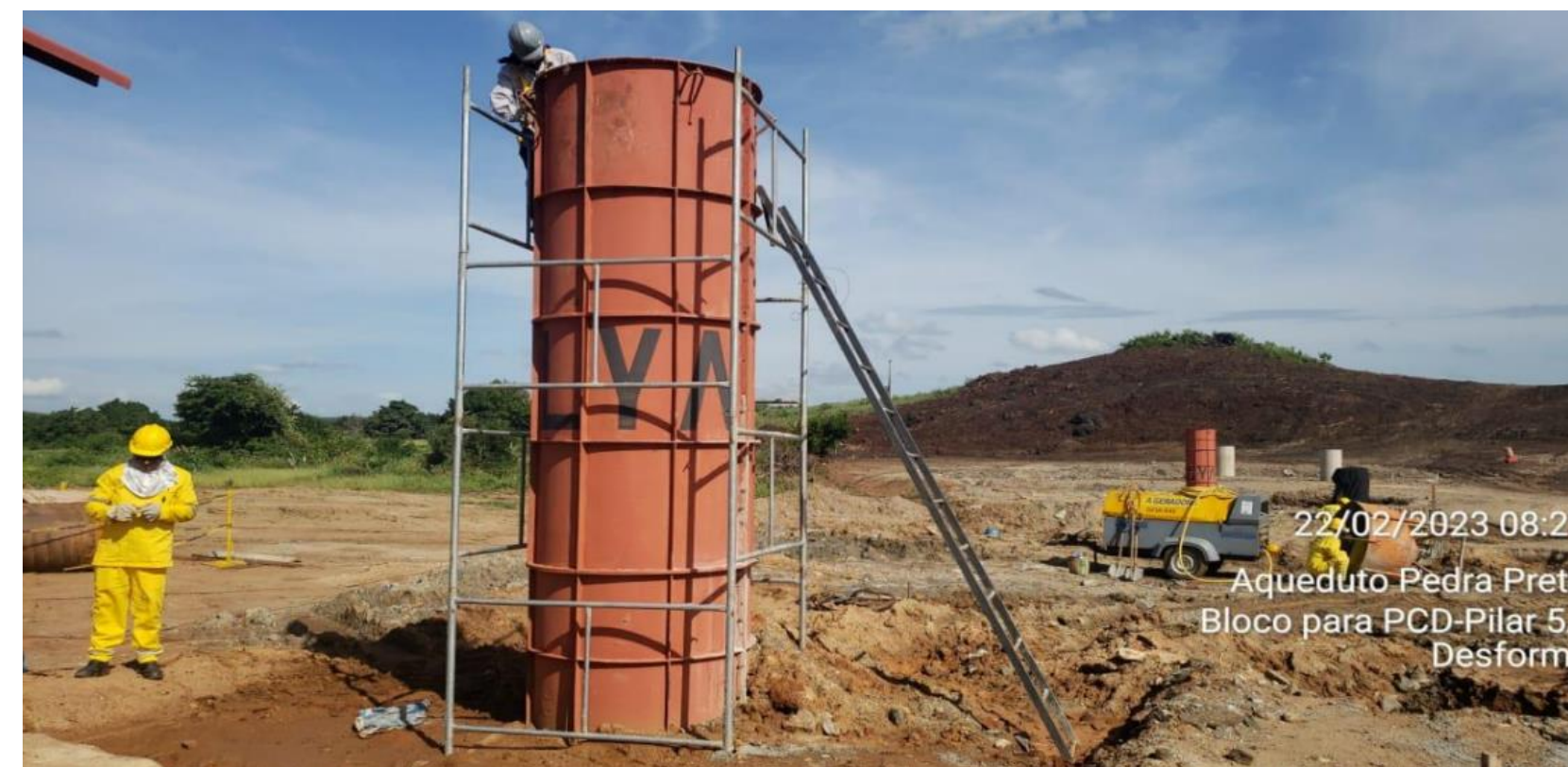
Aqueduto Pedra Preta: Concretagem do bloco P5A
