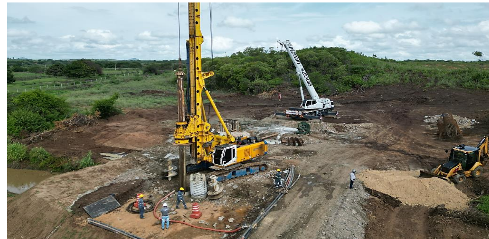
Aqueduto Pedra Preta: Execução da perfuração das estacas
