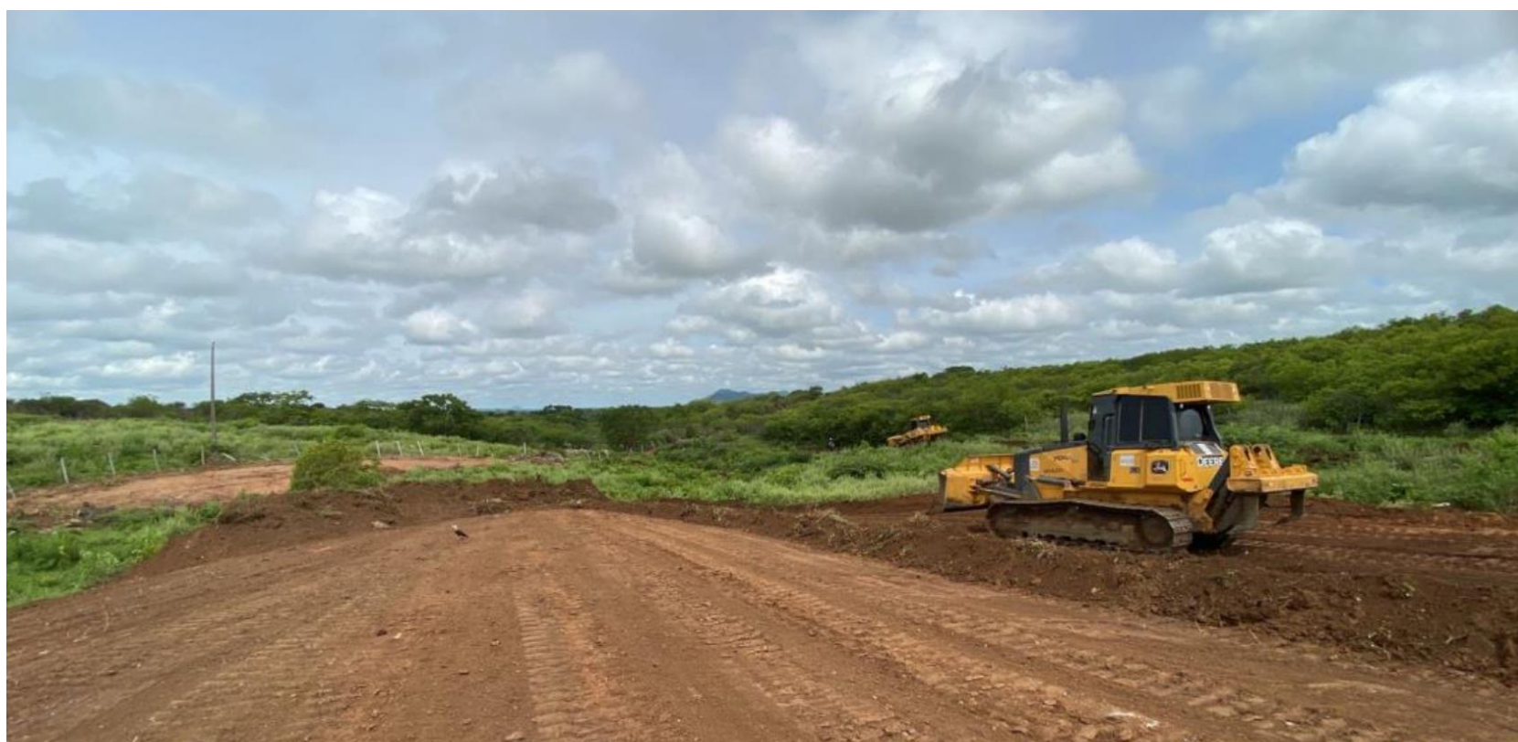
Canal C-9: Execução da supressão vegetal
