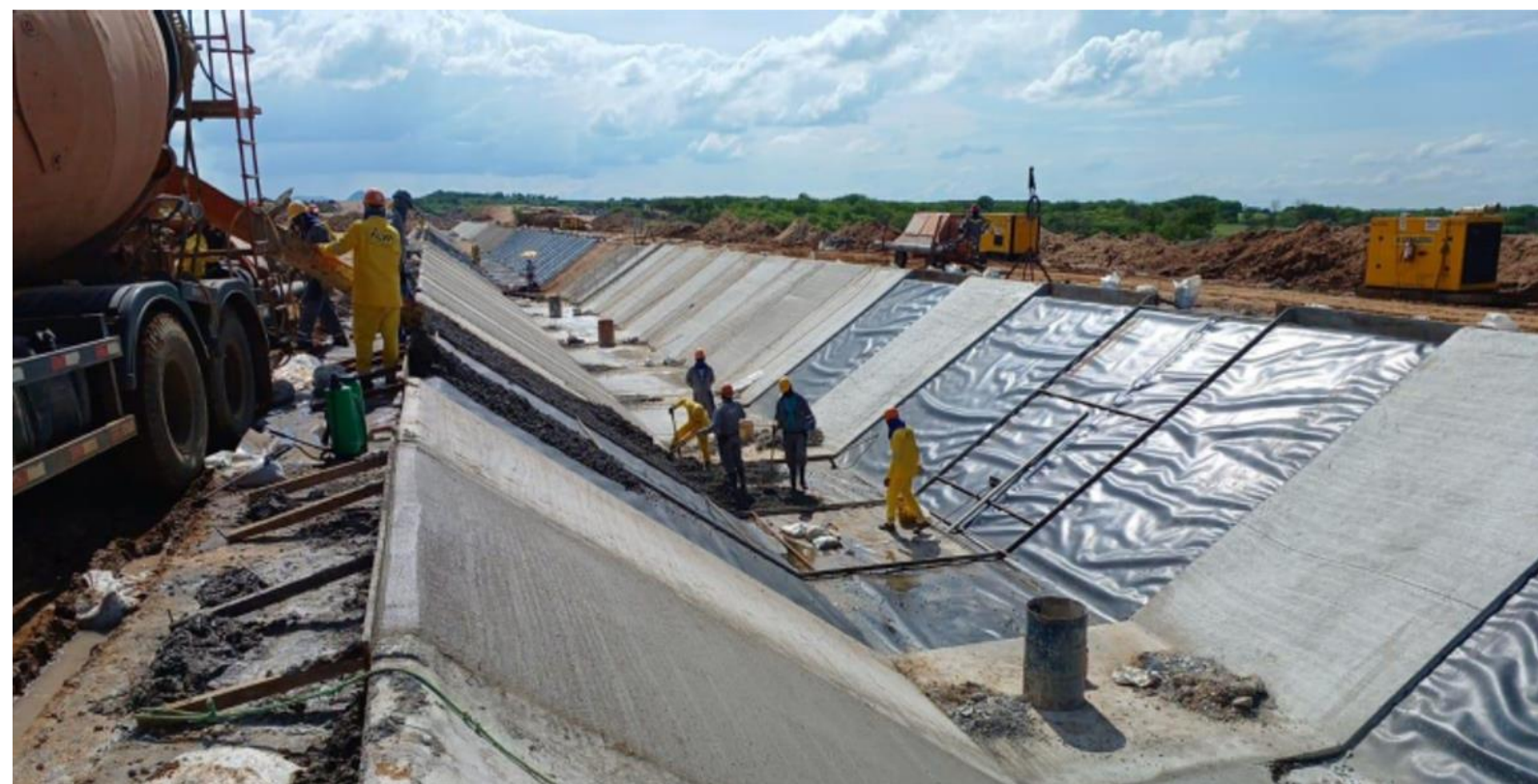
Canal C-7: Execução da drenagem interna
