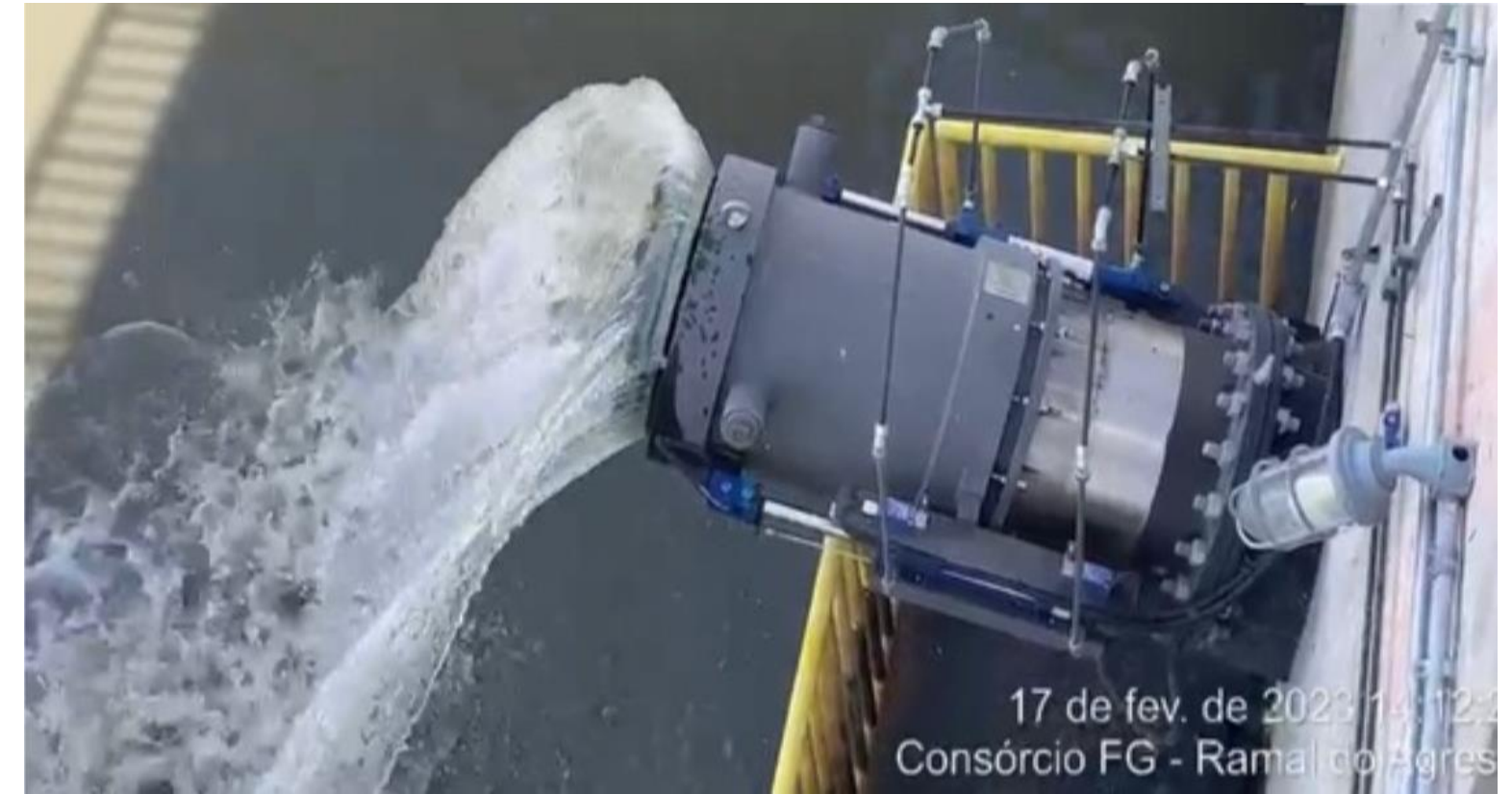
Reservatório Ipojuca: Teste de válvula da Barragem
