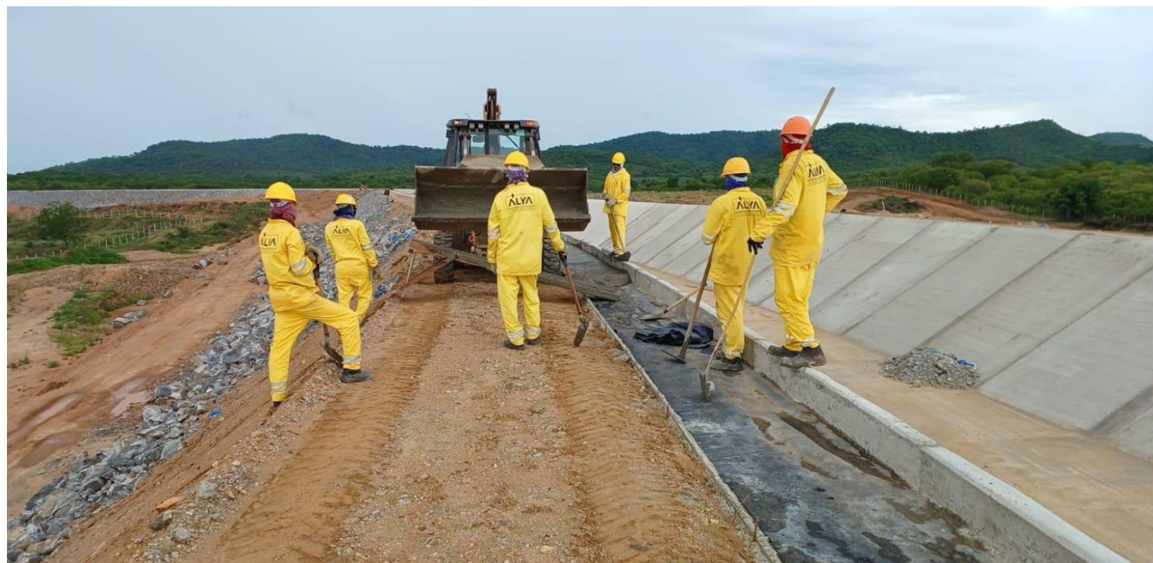
Canal C-8: Execução do concreto de ancoragem da geomembrana
