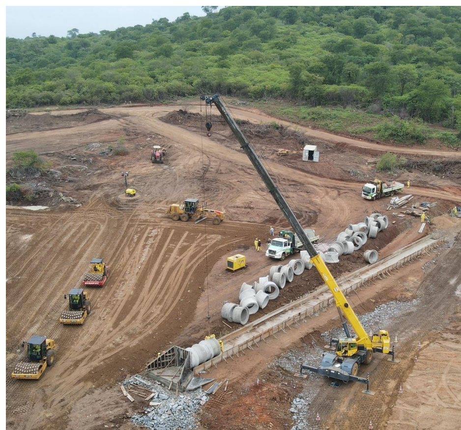
Execução de Canal
