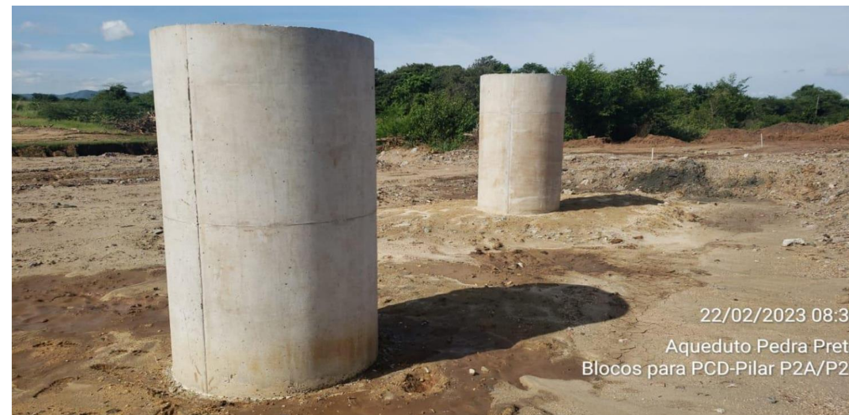
Aqueduto Pedra Preta: Concretados os blocos P2A e P2B
