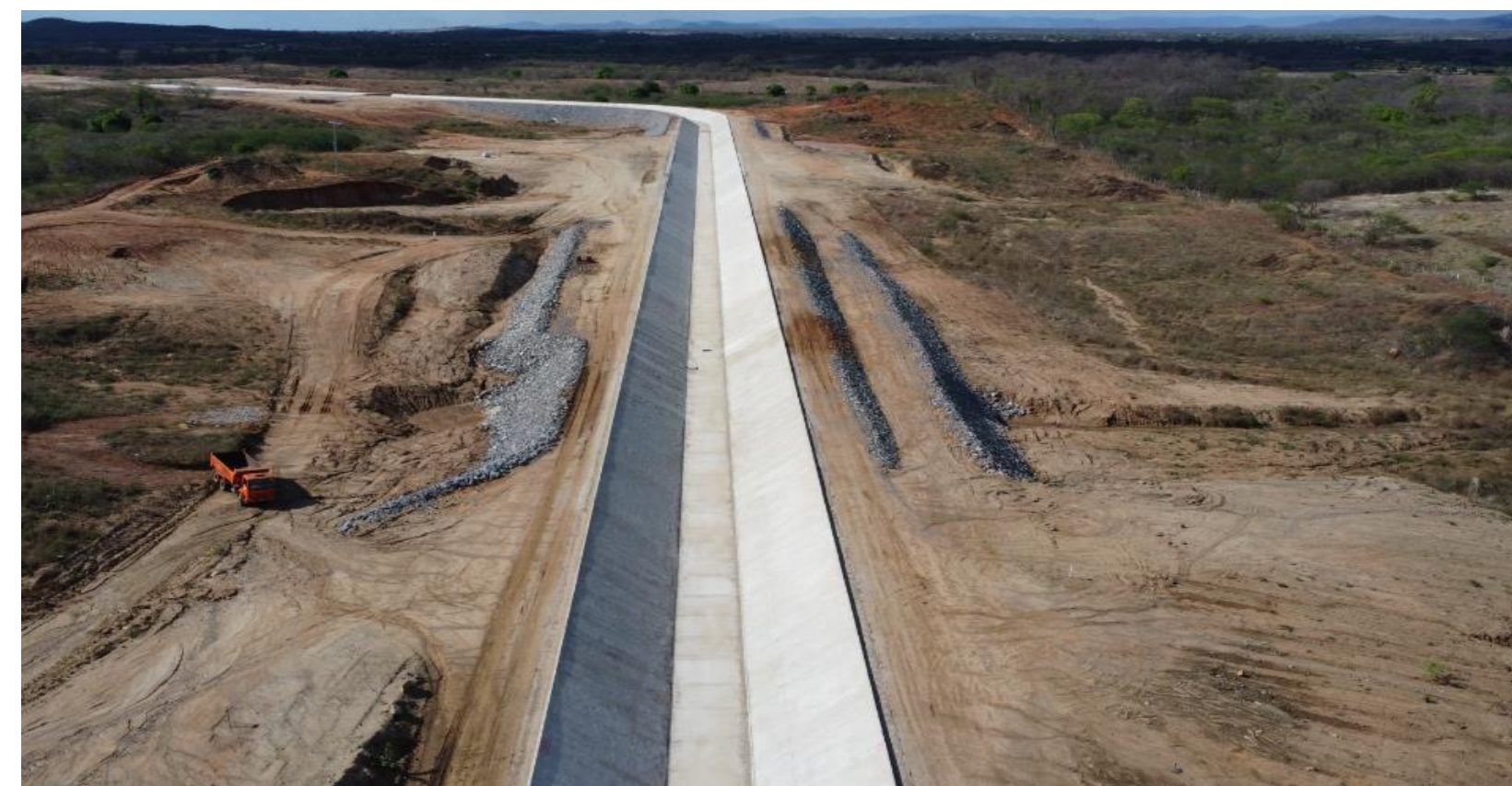
Seguimento de Canal C-5
