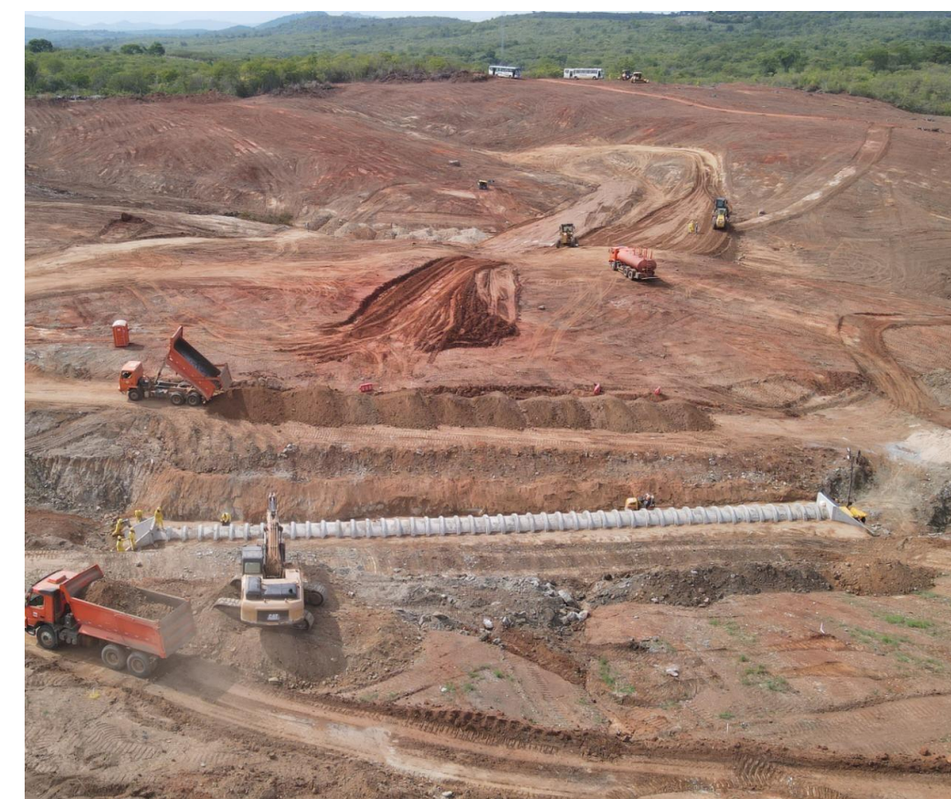
Execução de Bueiro
