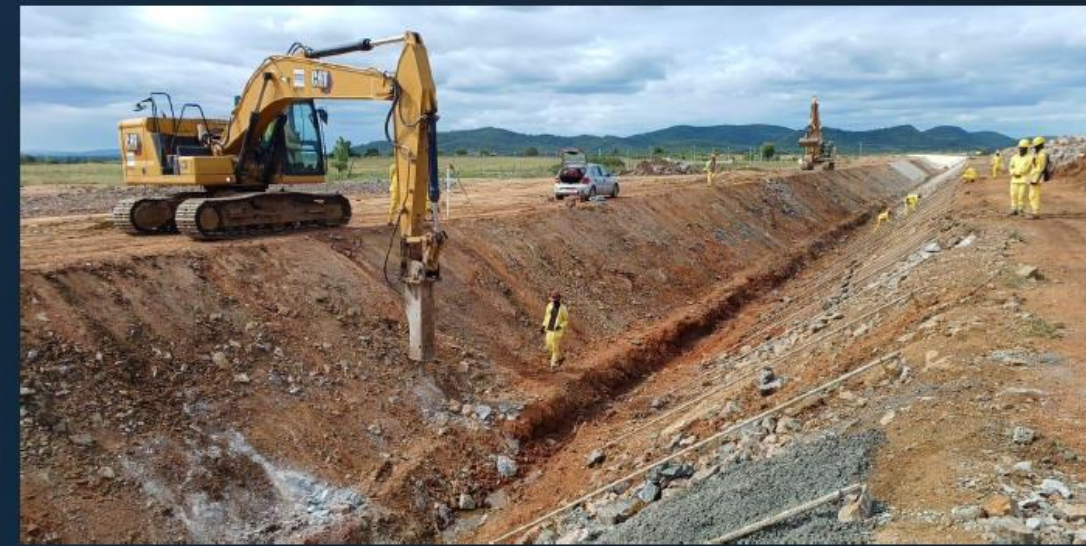
C8: Execução do dreno de fundo
