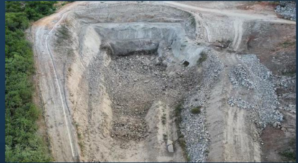
Túnel Major Sales: Vista após a detonação
