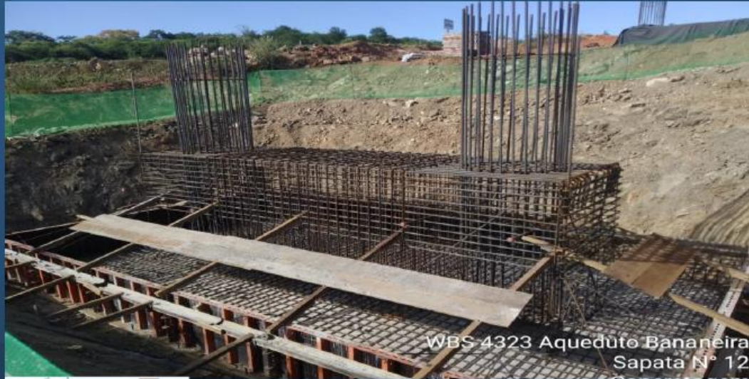
Aqueduto Bananeira: Execução da armação da sapata 12
