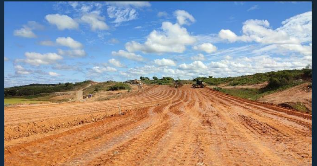
Canal 9: Execução do aterro
