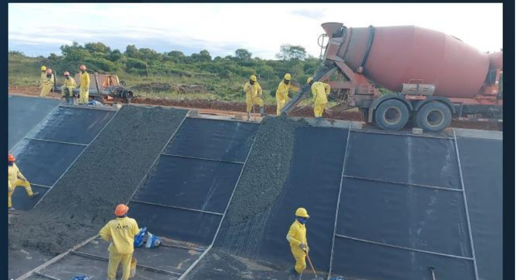
Canal 7B: Execução da placas de concreto
