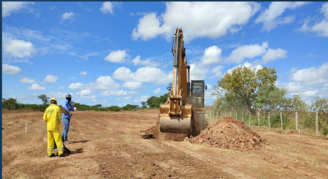
Canal 11: Execução na área de empréstimo
