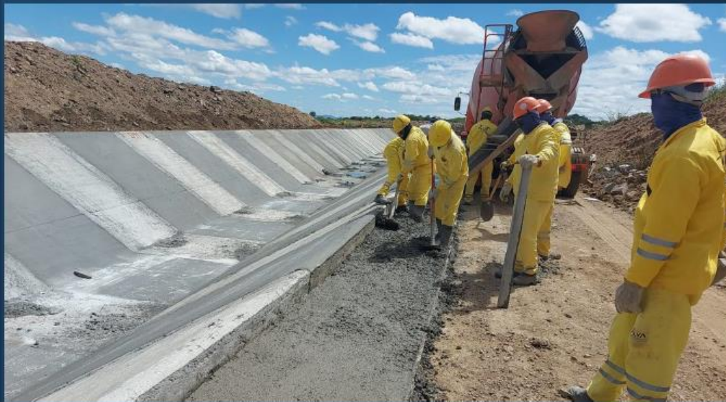
Canal 7B: Execução da ancoragem da geomembrana
