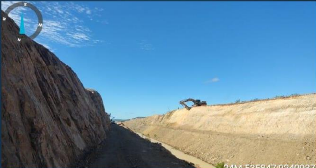
Canal 7B: Execução da limpeza do talude
