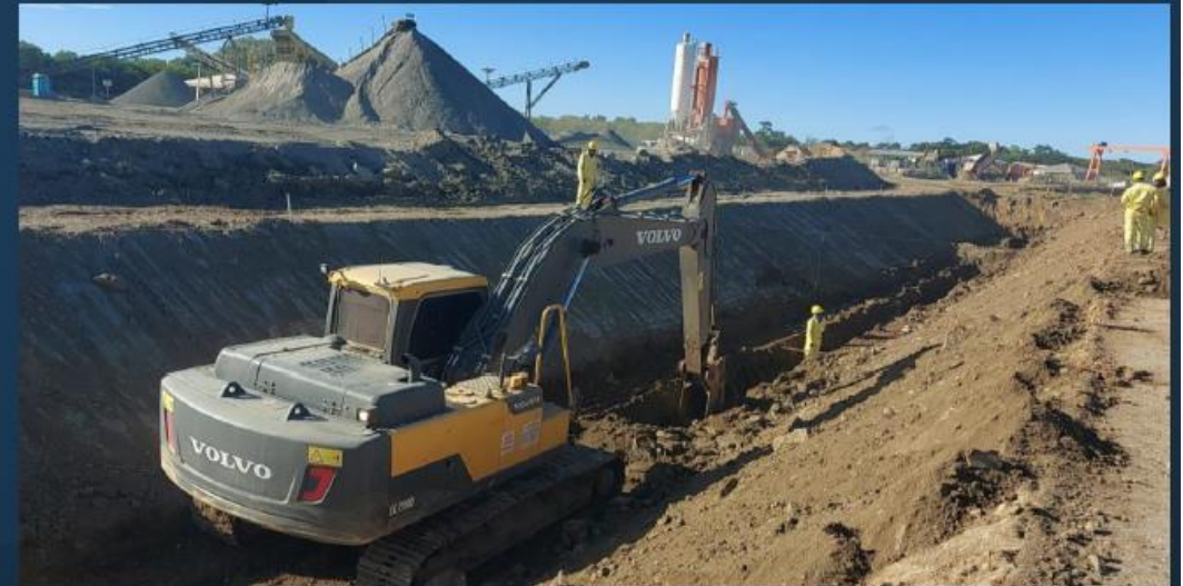
Canal 7B : Execução do dreno de fundo
