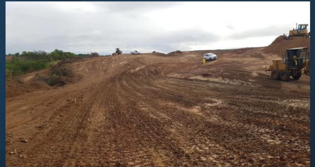
Canal 11: Execução da terraplenagem
