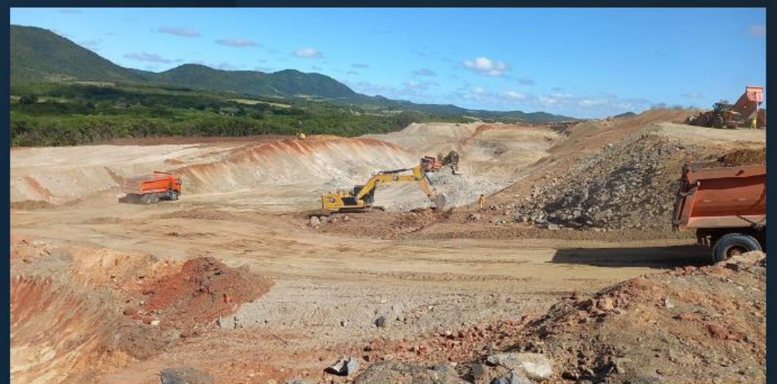
Canal 3: Execução da terraplenagem
