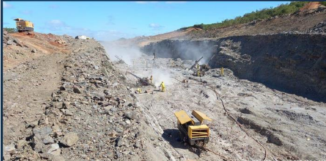
Canal 3: Execução da escavação
