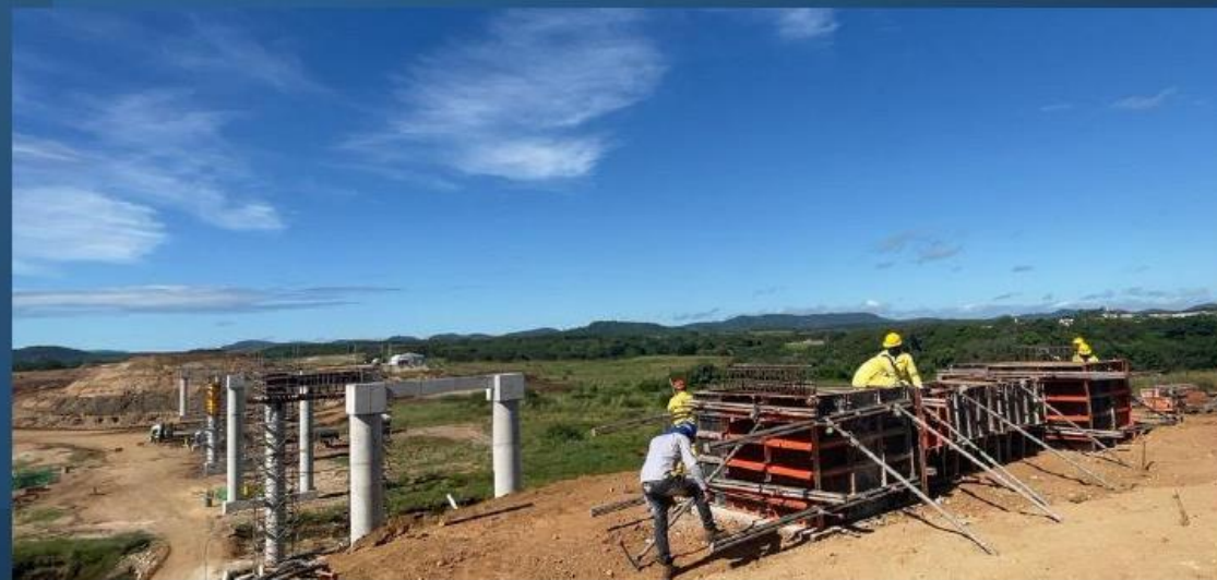
Aqueduto Pedra Preta: Execução da mesoestrutura
