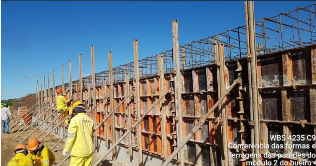
Canal 9 : Execução do bueiro 4
