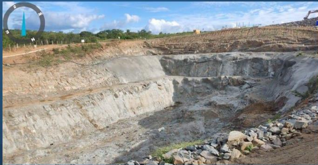
Túnel Major Sales: Execução do carregamento de explosivo para detonação
