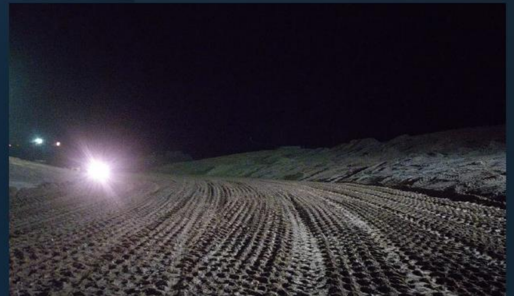
Canal 11: Execução da terraplenagem (noturno)
