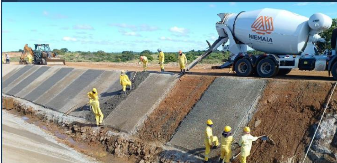
C8: Execução do concreto poroso
