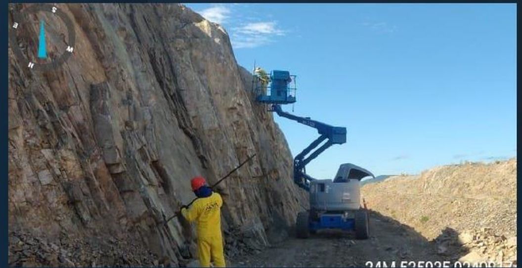
Canal 7B: Execução da limpeza e bate-choco
