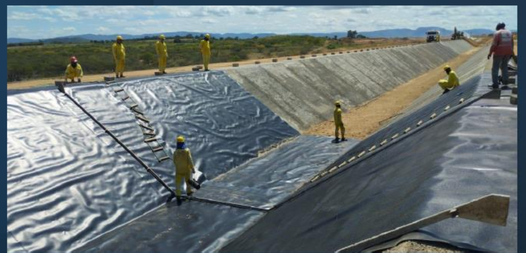
Canal 9: Execução da geomembrana
