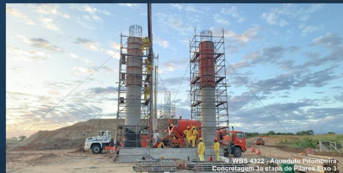
Aqueduto Pitombeira: Execução da mesoestrutura
