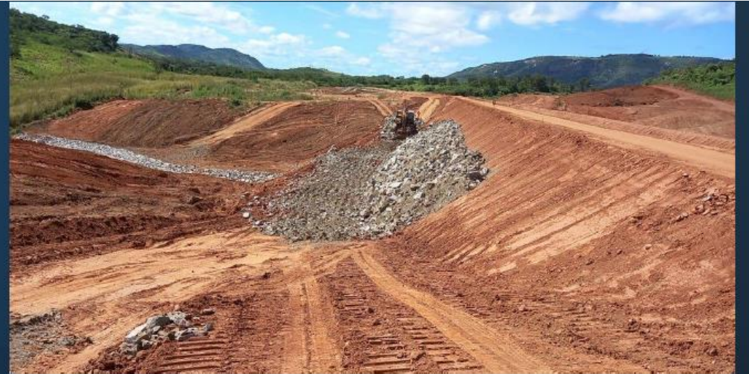
Canal 2: Execução do enrocamento de proteção
