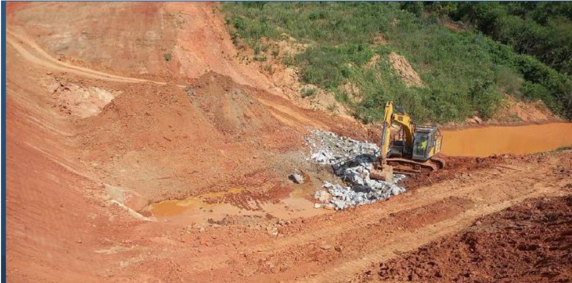
Canal 2: Execução do enrocamento de proteção da saída do bueiro 2
