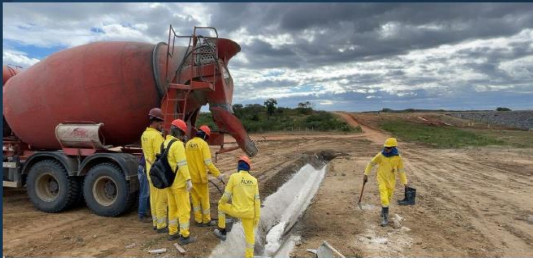
Canal 5: Execução da drenagem externa (canaletas)
