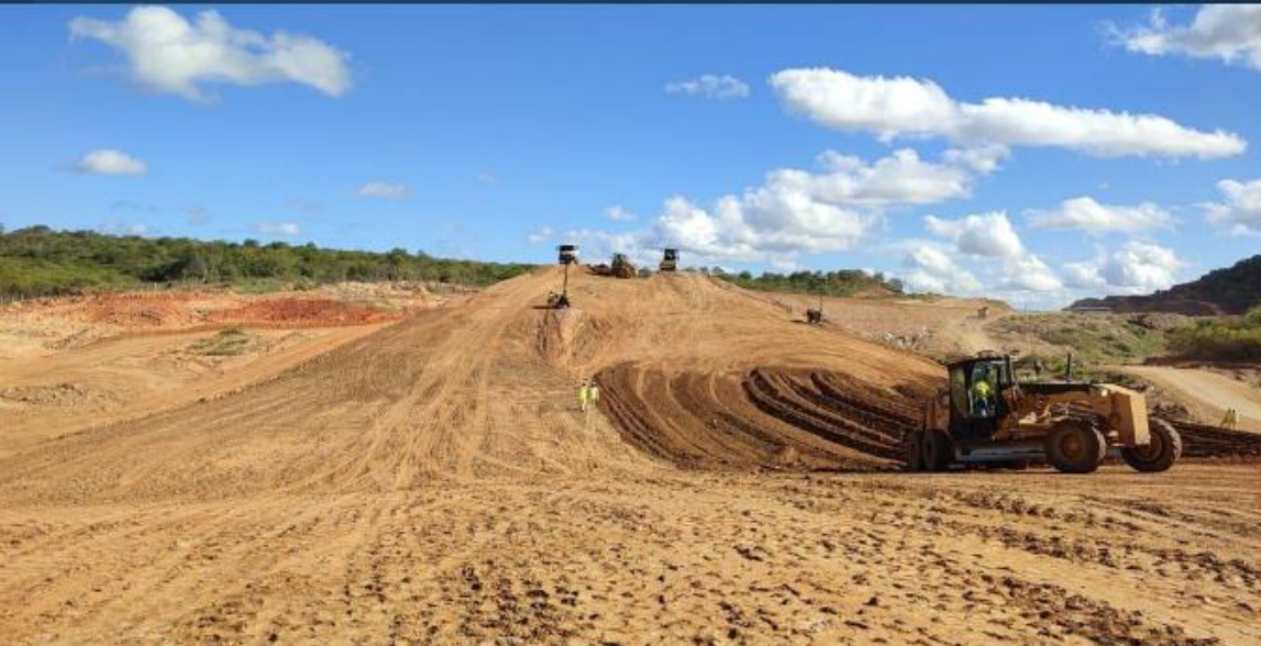
Canal 9: Execução terraplenagem
