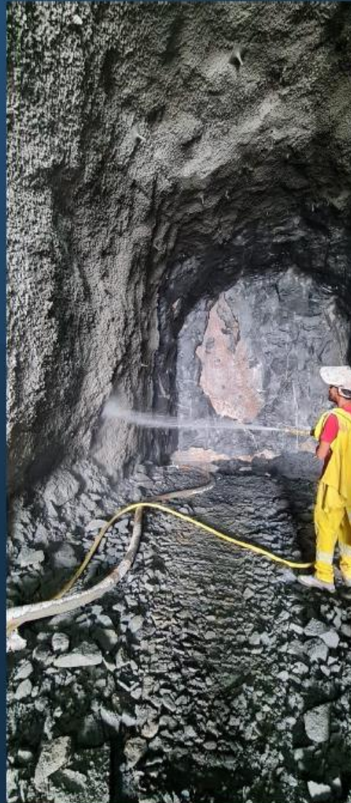
Túnel Major Sales: Execução do concreto projetado na janela de acesso.
