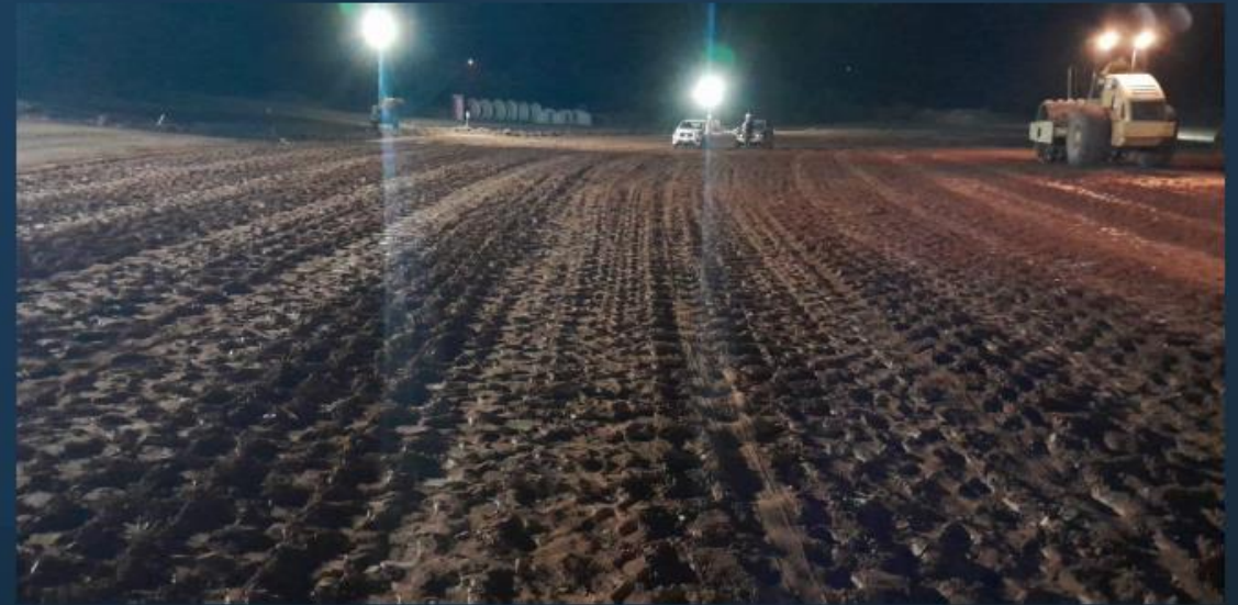
Canal 4: Execução da terraplenagem
