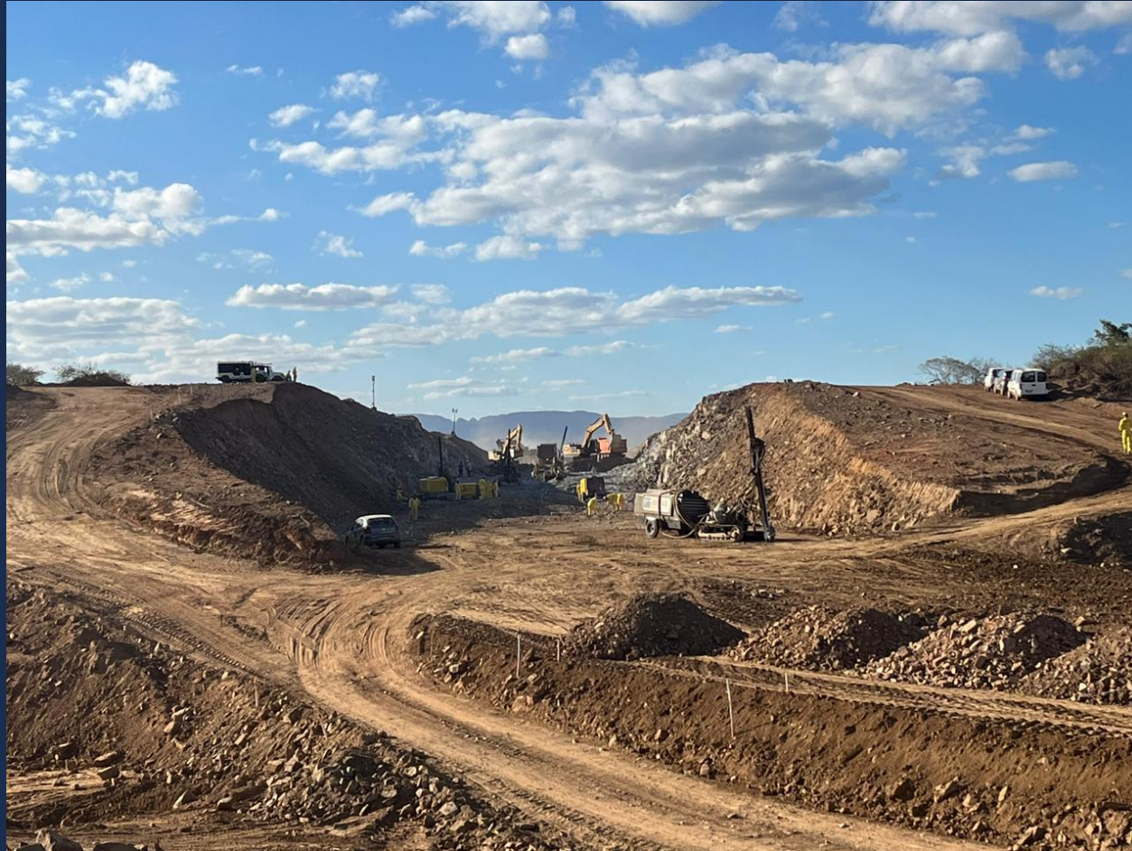
Canal 11 – Execução de Escavação
