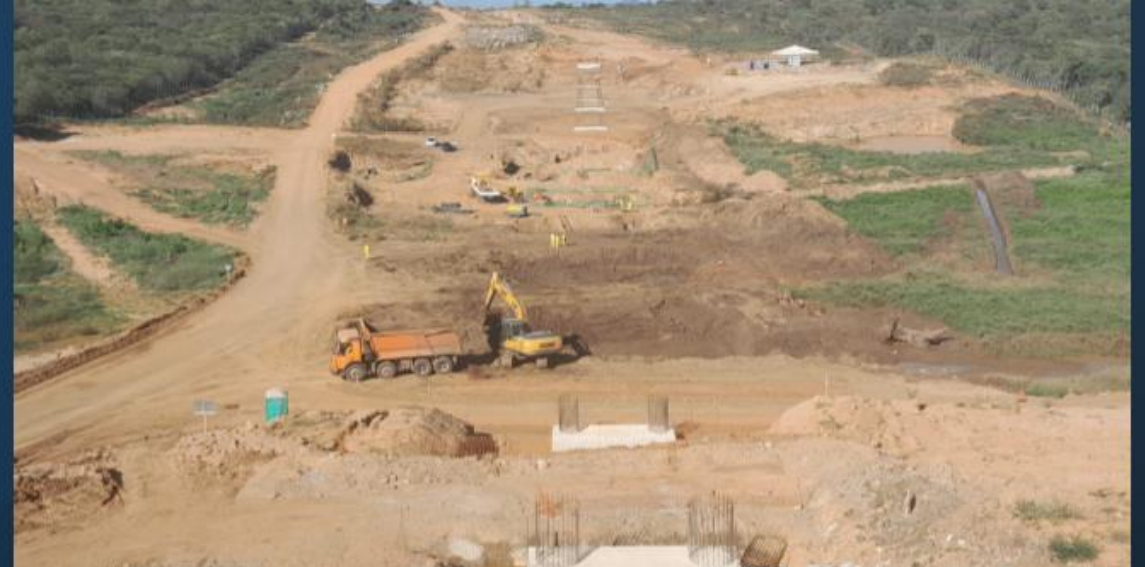
Aq. Bananeira : Execução da infraestrutura
