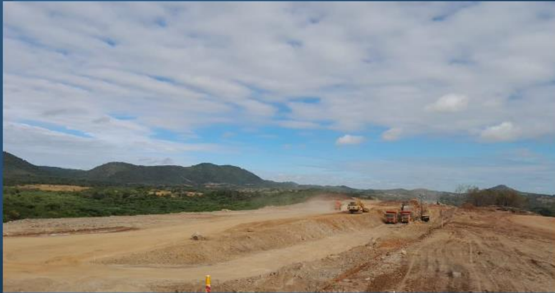
Rápido Angical 1: Execução do canal de montante
