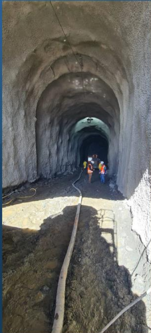
Túnel Major Sales: Execução da escavação na janela de emboque
