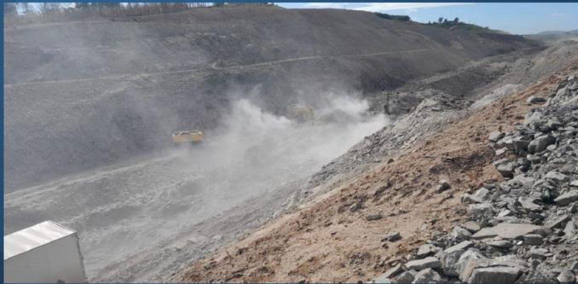
Canal 8: Execução da escavação
