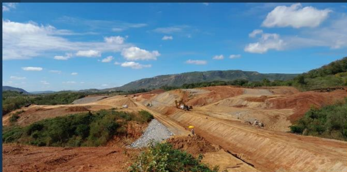
Canal 2: Execução da regularização interna do canal
