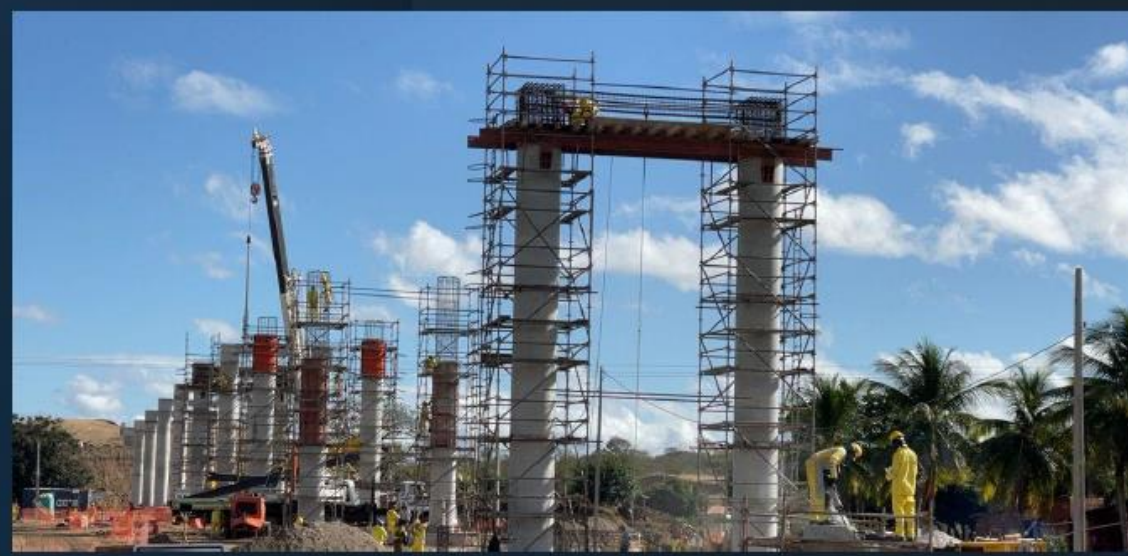
Aq. Pitombeira: Execução da mesoestrutura
