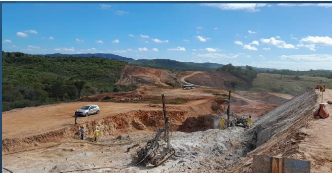
Rápido Arruído: Execução da terraplenagem
