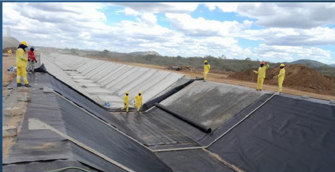
Canal 7B: Execução da geomembrana
