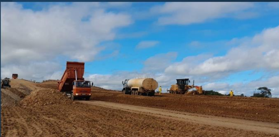
Aq. Pitombeira: Execução do aterro da transição de montante
