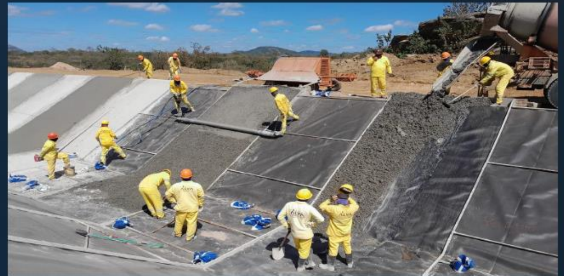
Canal 7B: Execução do concreto das placas
