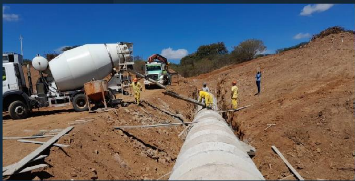
Canal 11: Execução do bueiro 6
