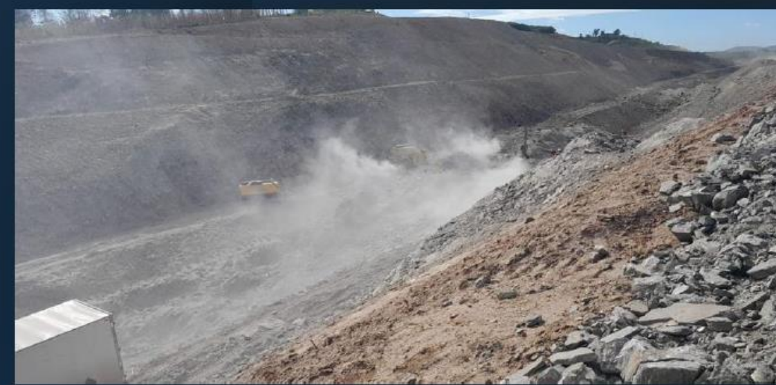
Canal 3: Execução da escavação na seção hidráulica
