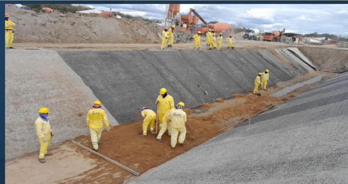
Canal 7B: Execução do dreno de fundo
