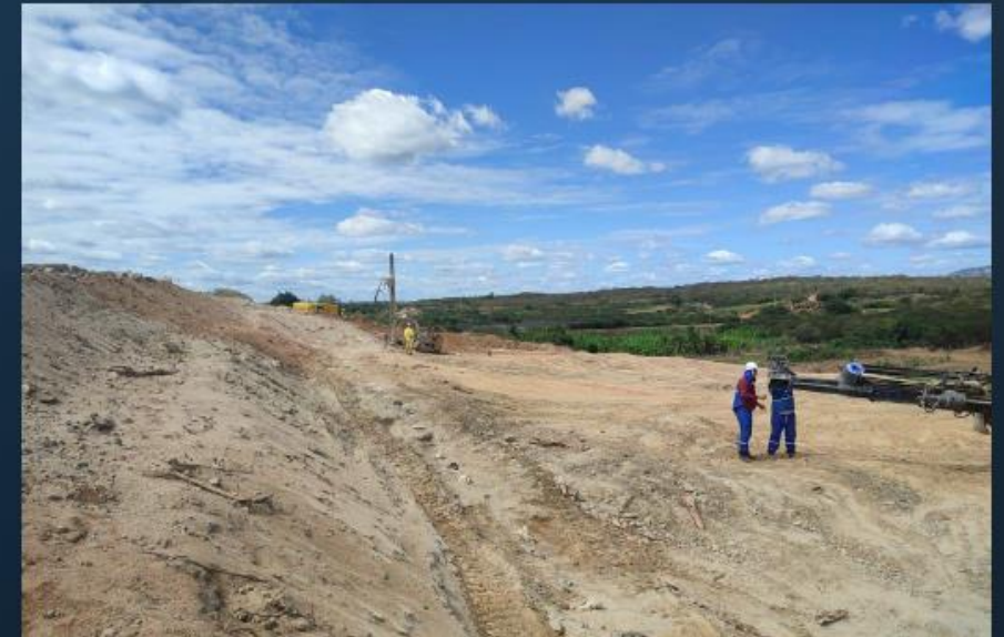
Emboque do Túnel: Execução da terraplenagem
