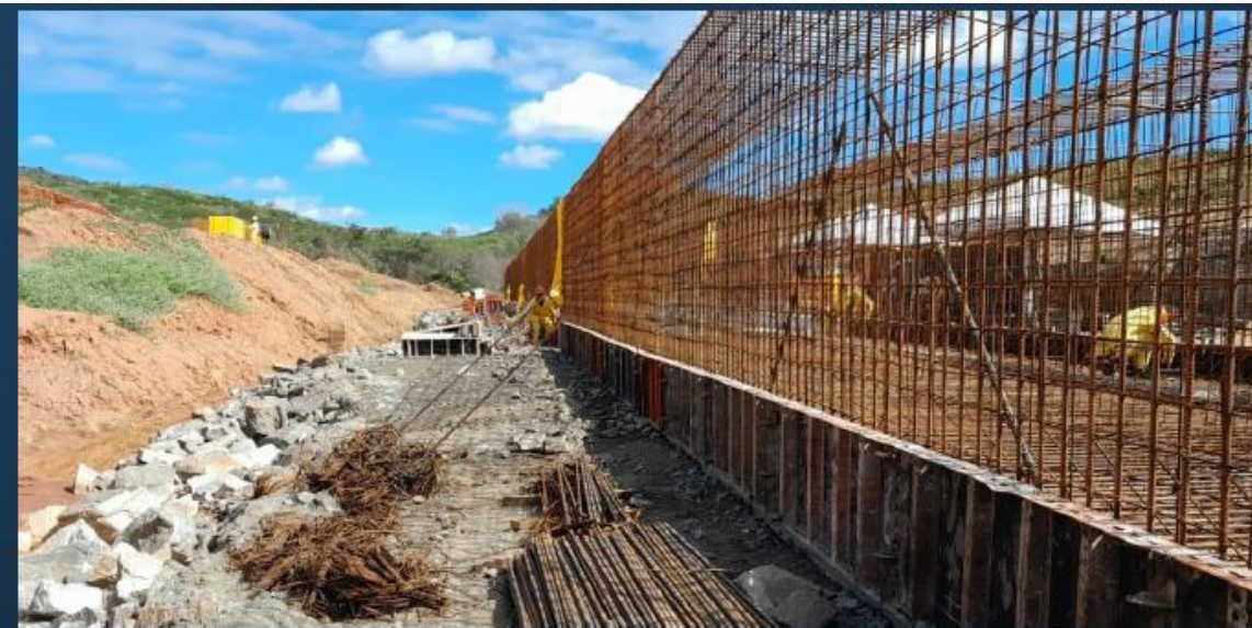
Canal 2: Execução da escavação do bueiro 1
