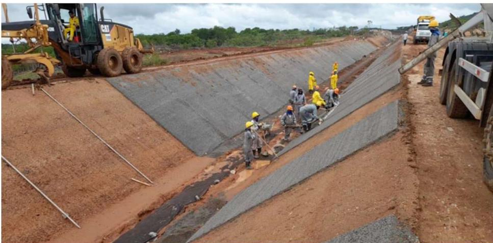
Canal C-7: Execução do concreto poroso
