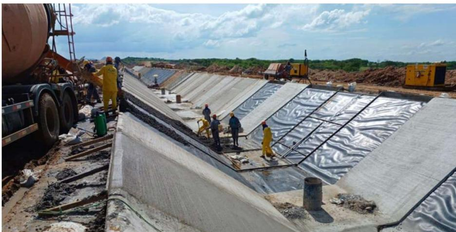
Canal C-7: Execução da drenagem interna
