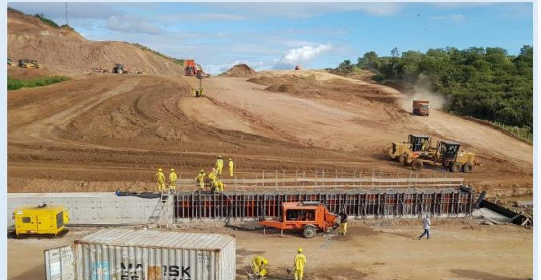
Canal 9 : Execução das paredes e laje superior do Bueiro 5
