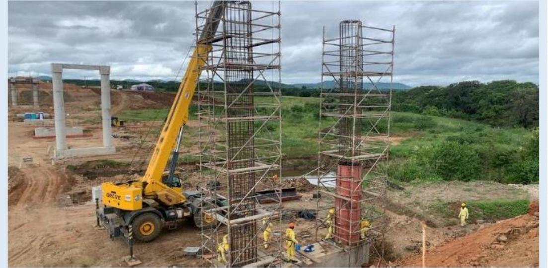
Aqueduto Pedra Preta: Montagem de forma e armação dos Pilares do eixo 2
