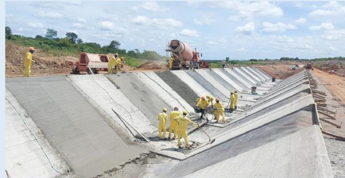
Canal 7B: Execução das placas de concreto
