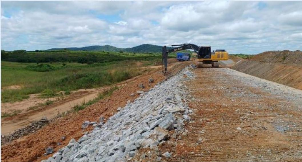
Canal 9: Execução do enrocamento de proteção dos taludes externos
