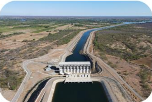
Estação de Bombeamento EBI-1(WBS 1610)
