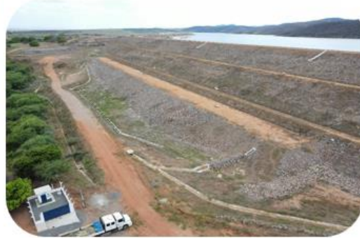
Reservatório Boi I (WBS 1116)
