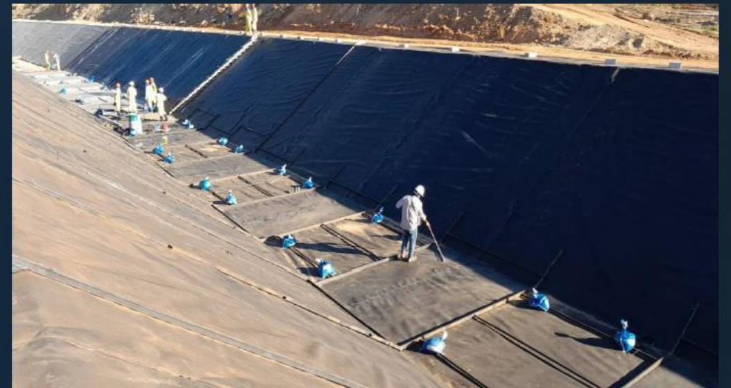
Canal 2: Execução da geomembrana
