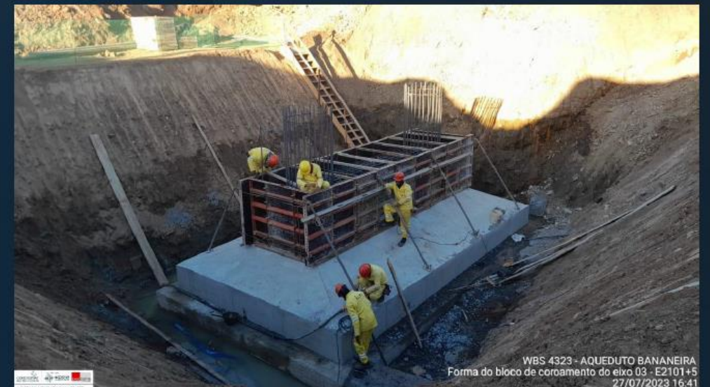
Aq. Bananeira: Execução da infraestrutura
