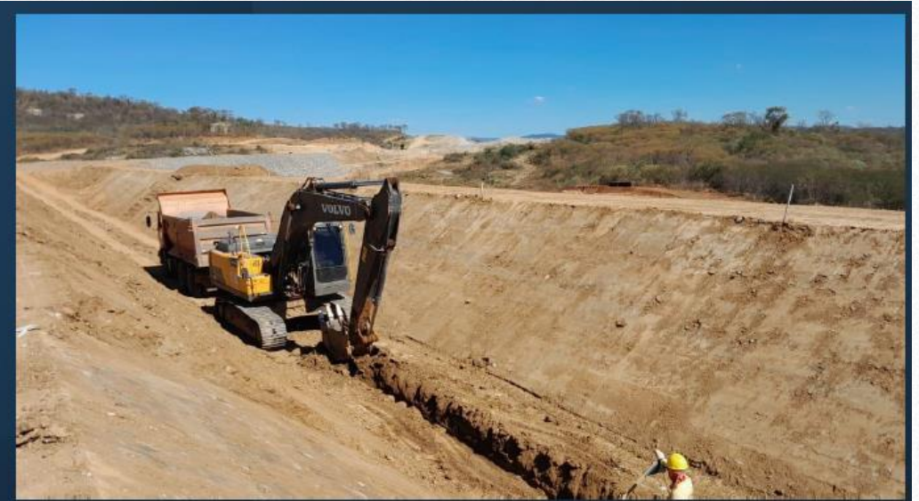
Canal 9: Execução do dreno de fundo
