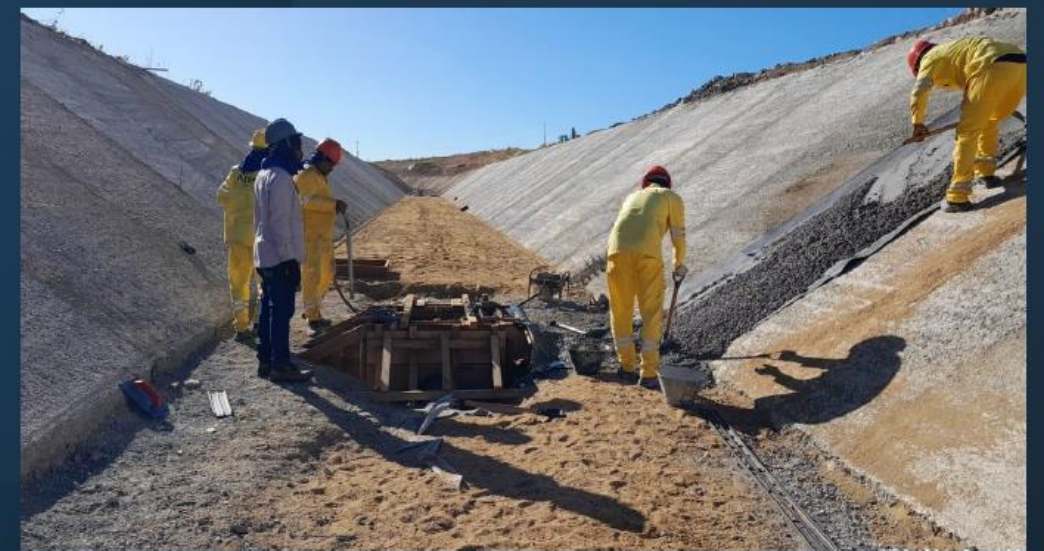
Canal 2: Execução do dreno de fundo
