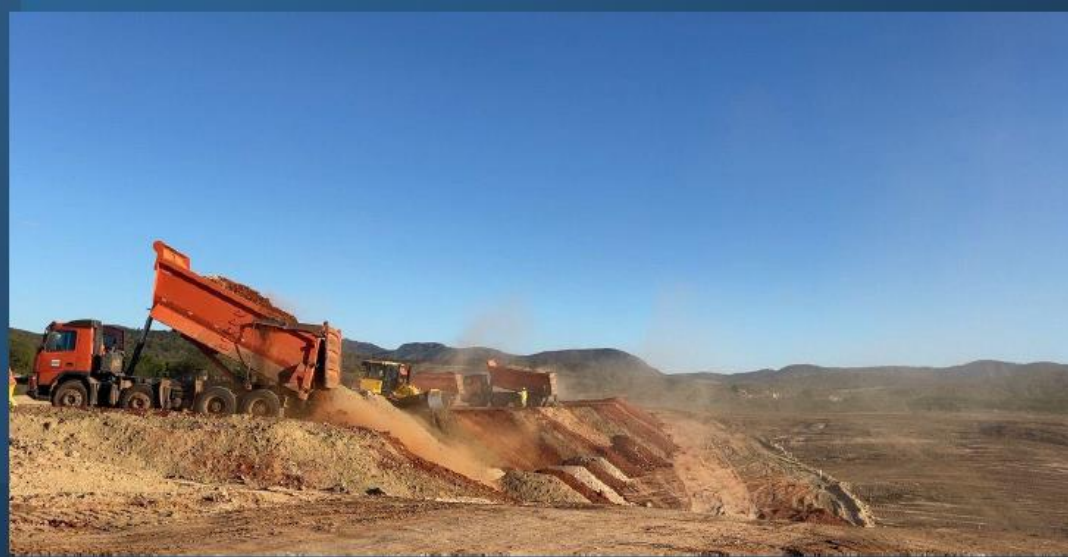
Canal 5: Início das atividades de terraplenagem
