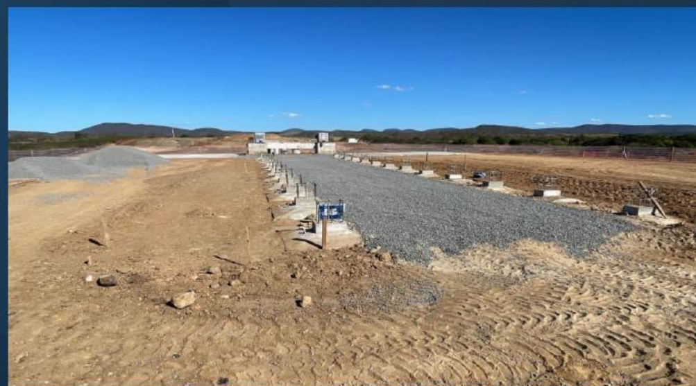
Aq. Pedra Preta: Execução do pátio de montagem
