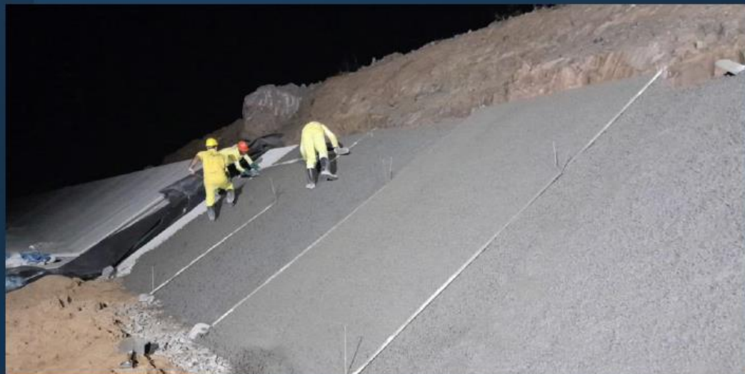
Canal 7b: Execução do concreto poroso
