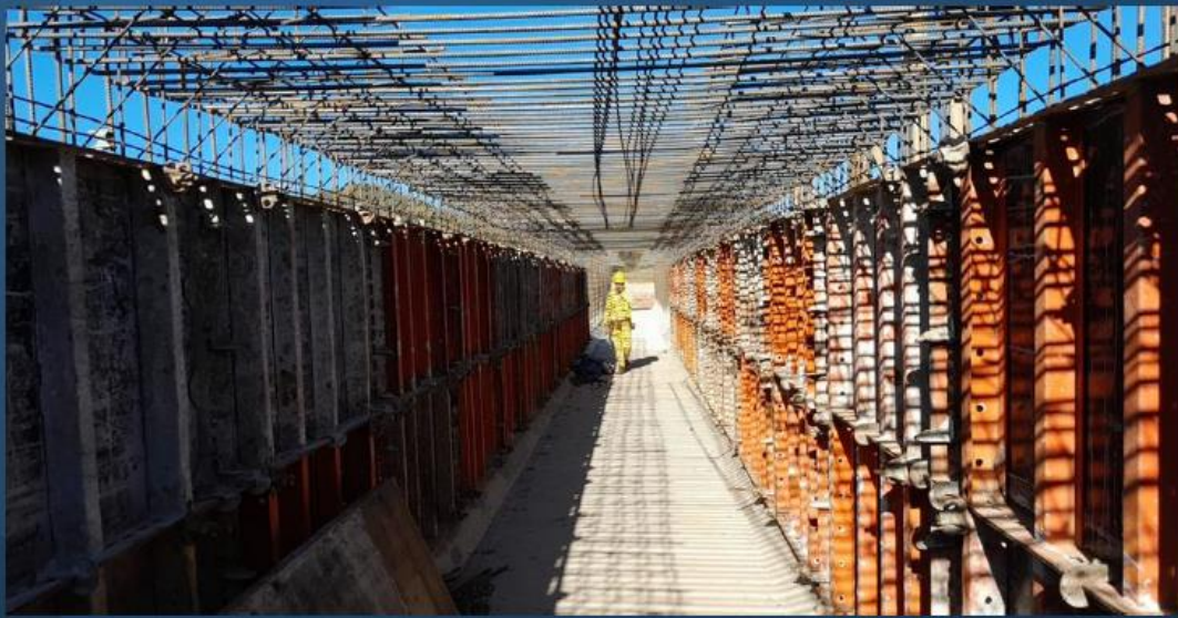
Canal 4: Execução do bueiro 2
