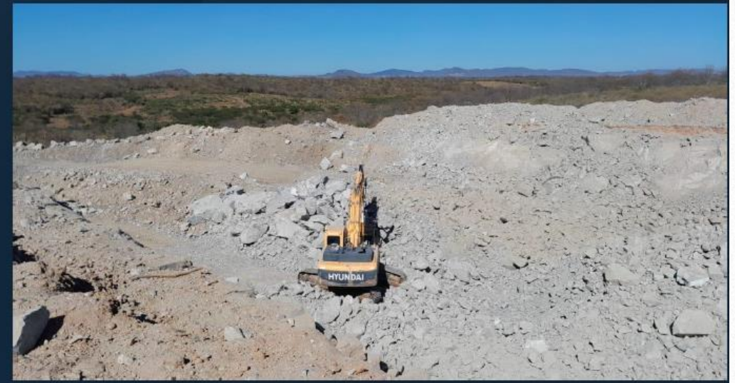
Canal 9: Execução da escavação
