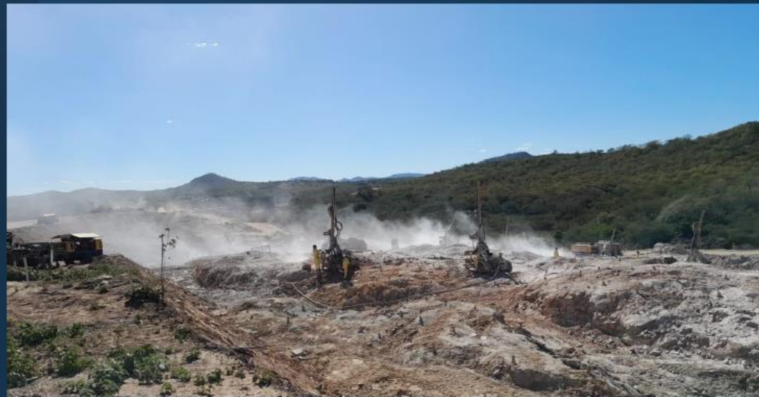
Rápido Angical 1 : Execução da escavação
