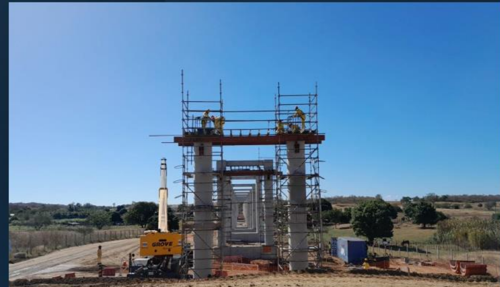
Aq. Pitombeira: Execução da mesoestrutura
