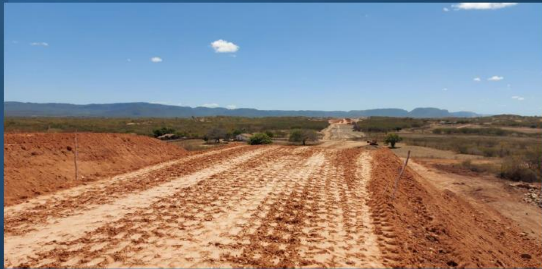
Canal 11: Execução do aterro
