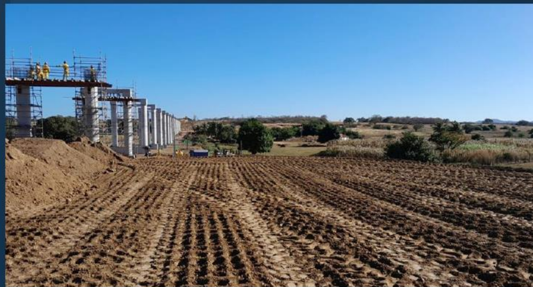
Aq. Pitombeira: Execução da terraplenagem na transição de montante
