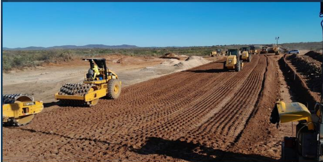
Canal 12: Execução do aterro
