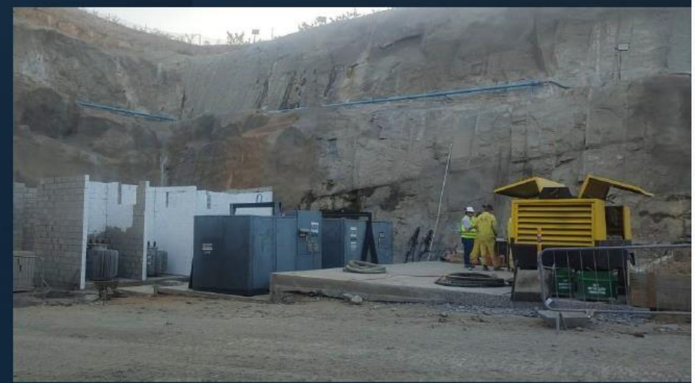
Túnel Major Sales: Execução da subestação
