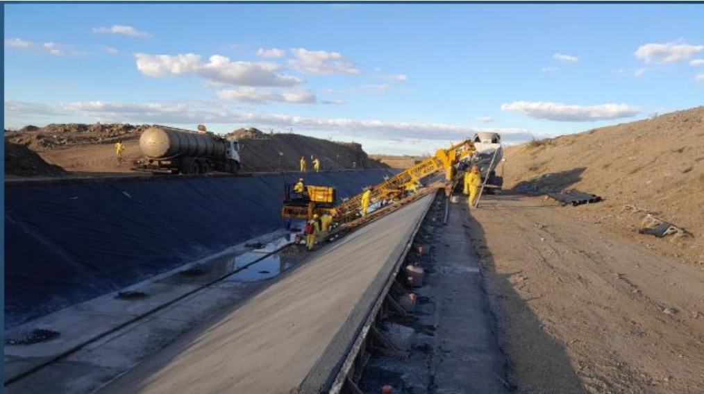
Canal 7b: Execução do concreto das placas do canal
