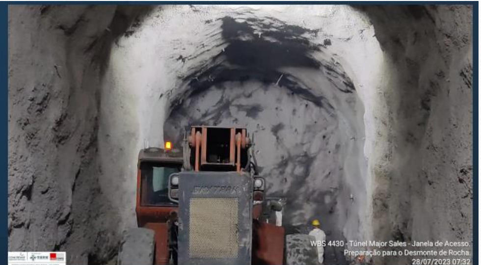
Túnel Major Sales: Execução da escavação na janela
