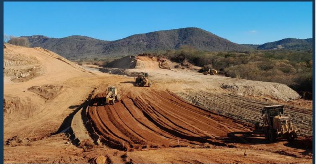
Canal 4: Execução da terraplenagem
