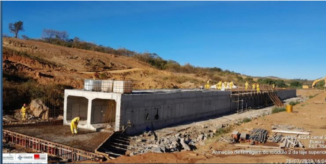
Canal 2: Execução do bueiro 1
