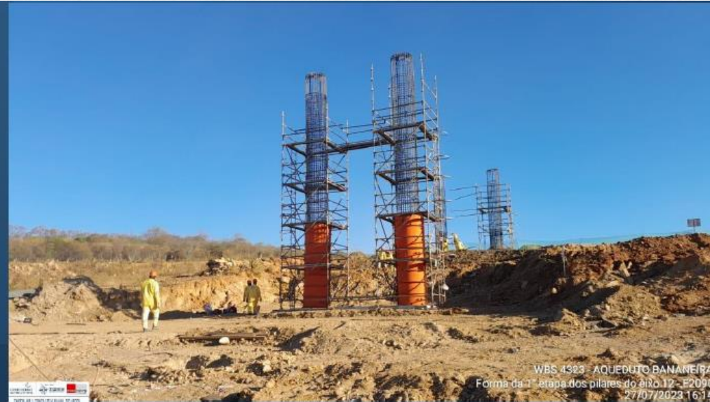
Aq. Bananeira: Execução da mesoestrutura
