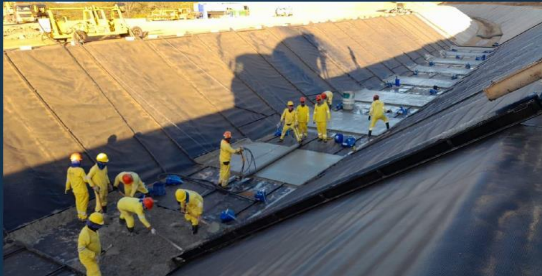
Canal 2: Execução do concreto de proteção mecânica
