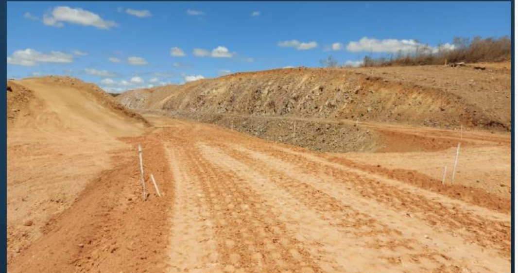
Canal 11: Execução da Aterro compactado
