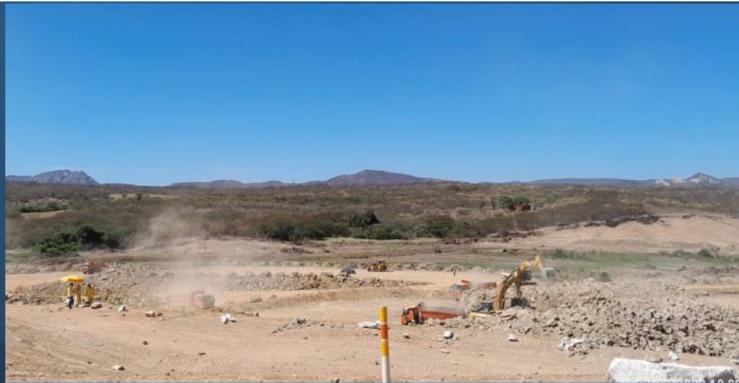
Emboque do Túnel Major Sales: Execução da escavação
