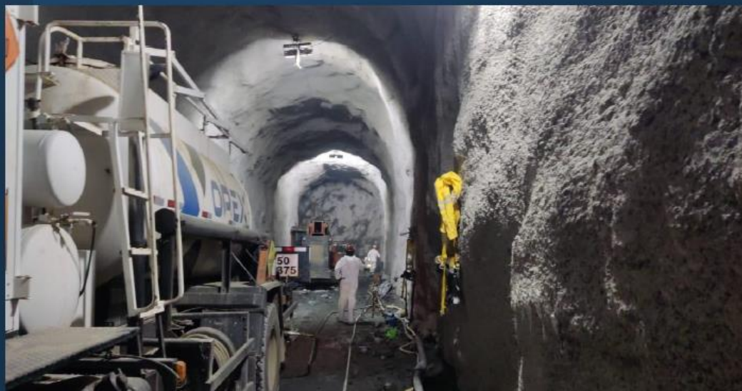
Túnel Major Sales: Execução da escavação na janela
