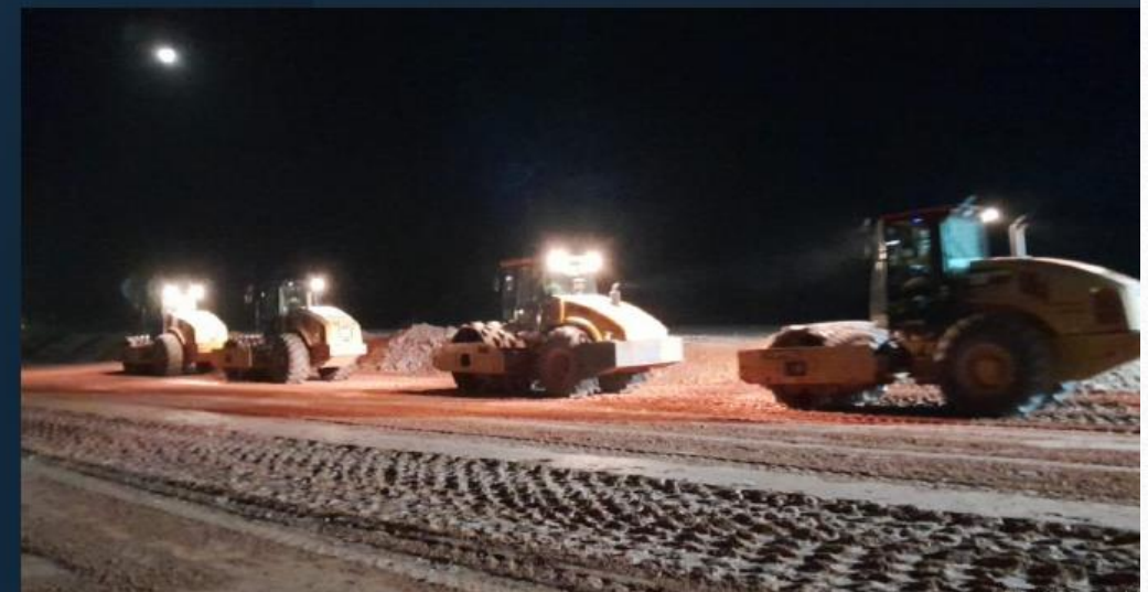
Canal 12: Execução do aterro (noturno)
