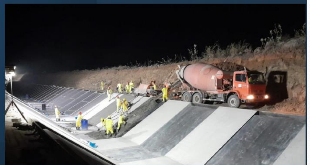
Canal 7b: Execução do concreto de proteção mecânica
