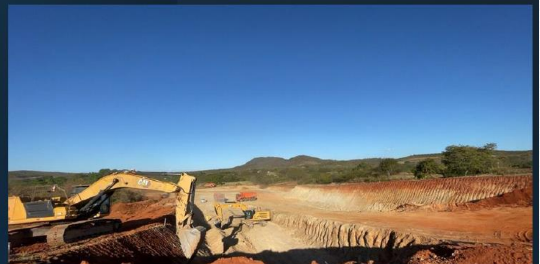
Barragem Tambor : Execução da escavação do vertedouro
