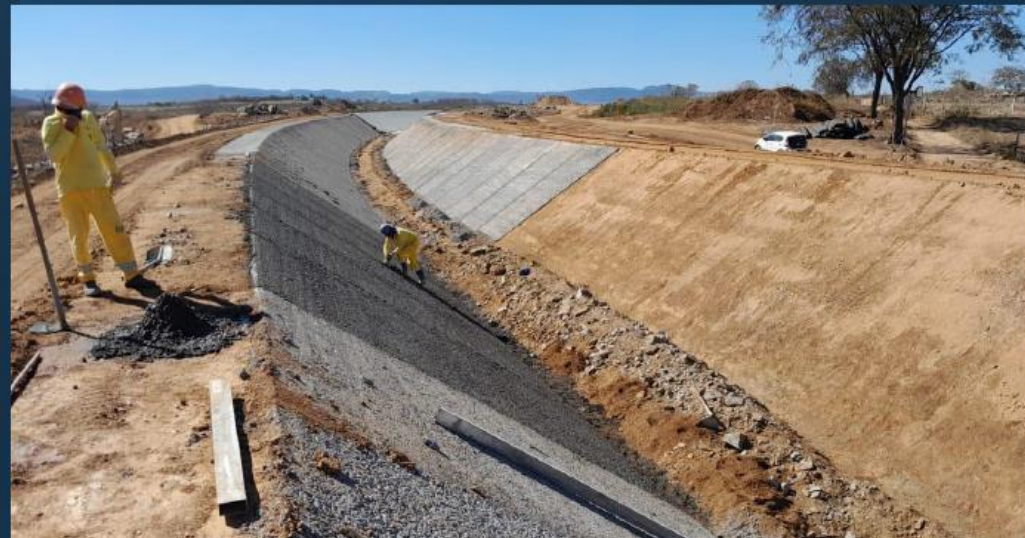
Canal 9: Execução do concreto poroso
