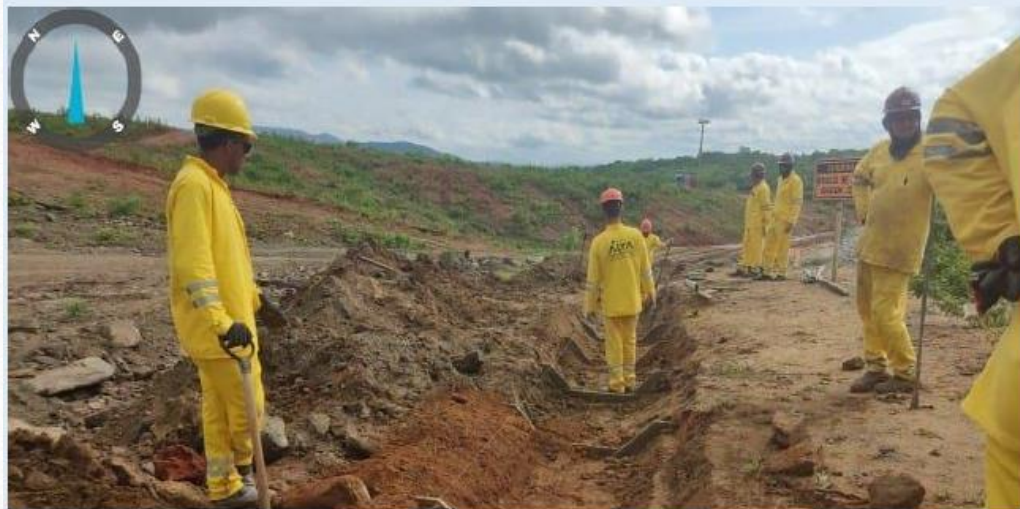
Túnel Major Sales: Execução da drenagem externa
