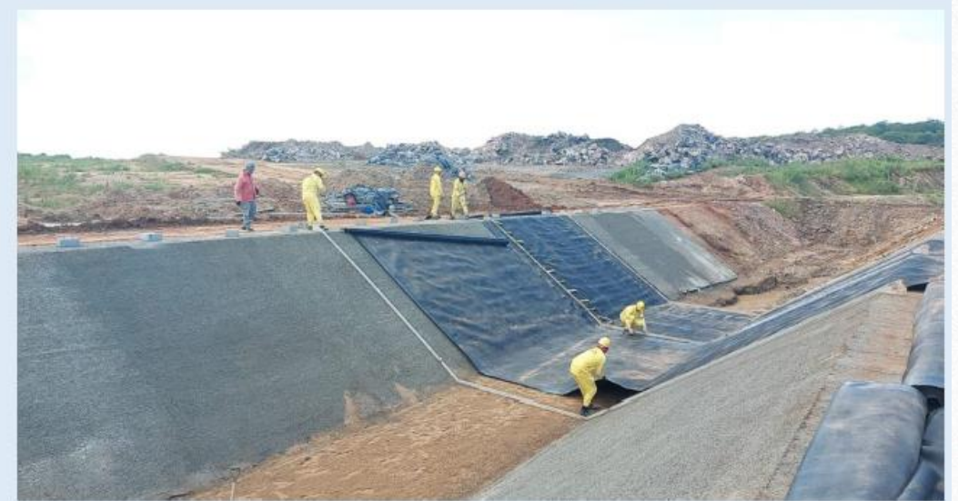
Canal 7B: Execução da geomembrana
