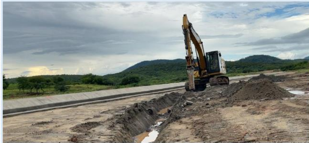
Canal 5: Execução da drenagem externa (canaletas)
