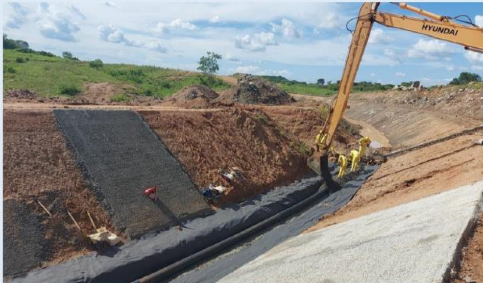
Canal 7B: Execução do dreno de fundo
