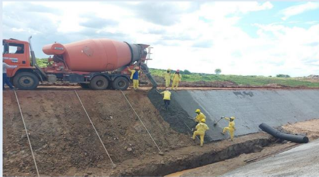
Canal 7B: Execução do concreto poroso
