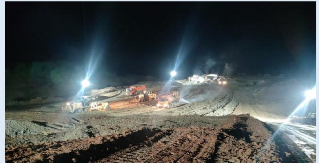
Canal 3: Execução do aterro (noturno)
