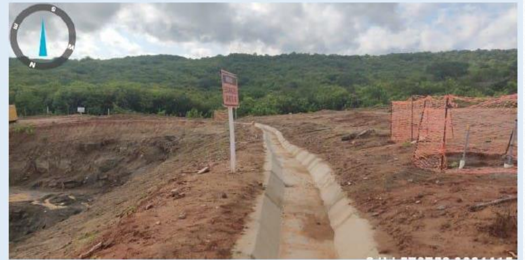
Túnel Major Sales: Execução das canaletas de drenagem
