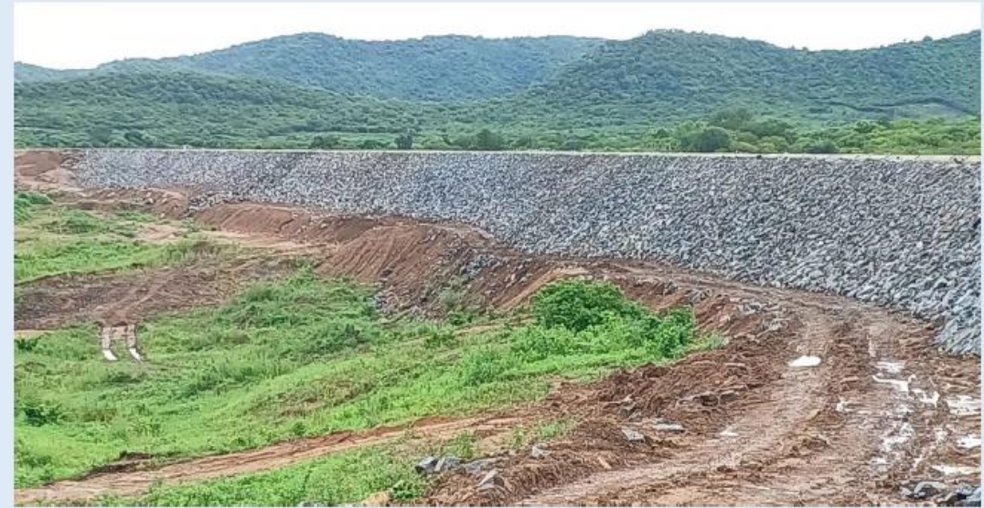
Canal 8: Enrocamento de proteção
