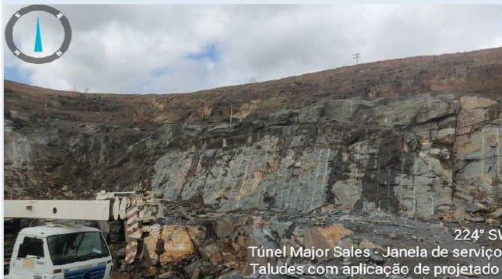
Túnel Major Sales: Execução da proteção da janela de acesso
