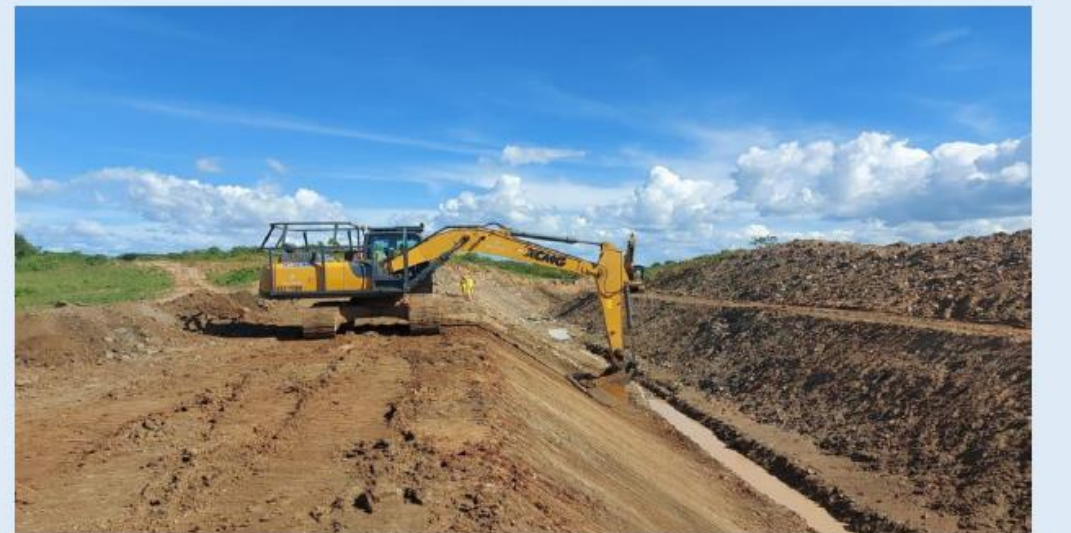
Canal 7B: Execução da regularização interna do talude
