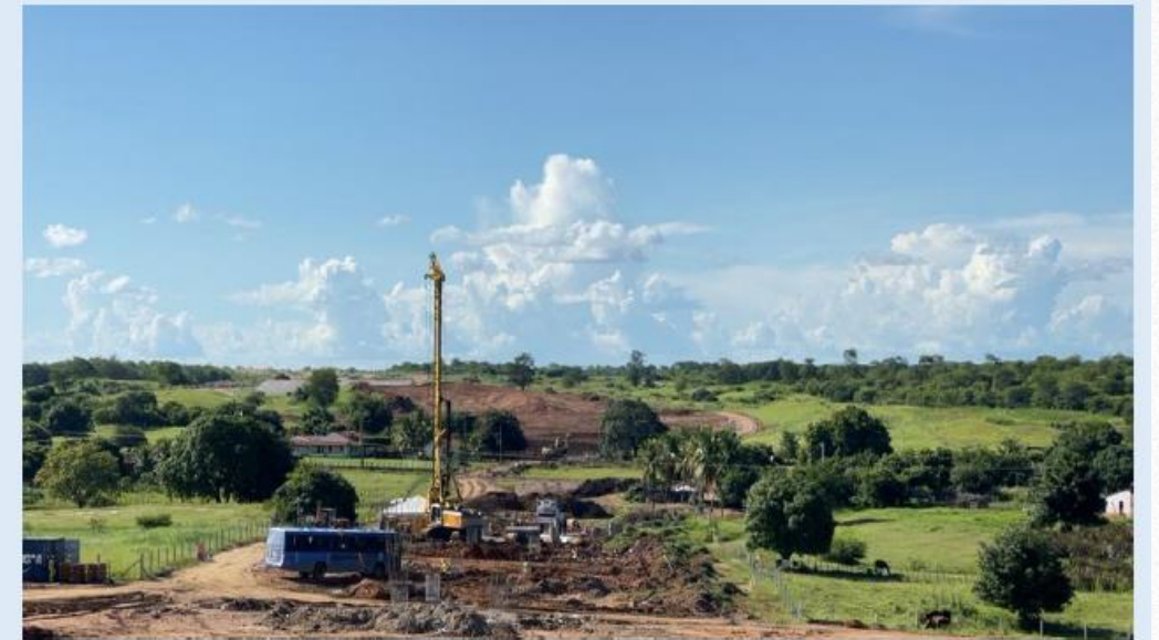
Aqueduto Pitombeira: Vista da execução das estacas
