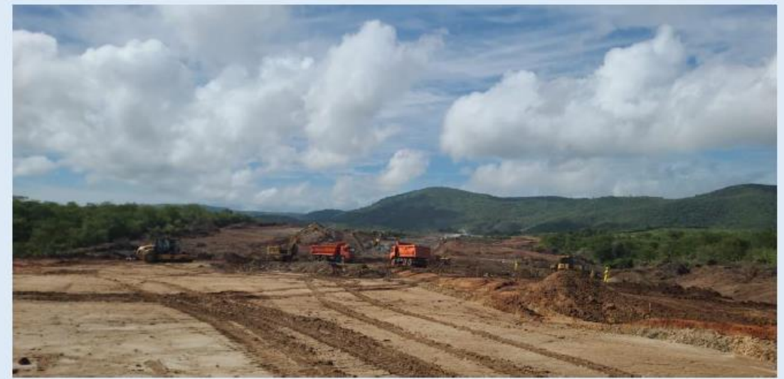
Canal 3: Execução da terraplenagem
