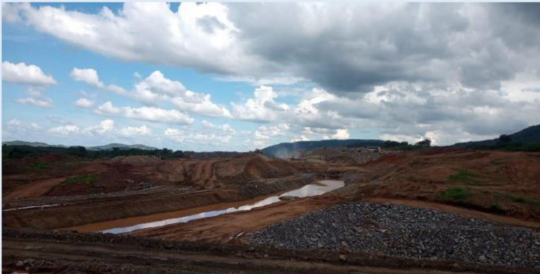
Canal 3: Execução da escavação (desmonte de rocha)
