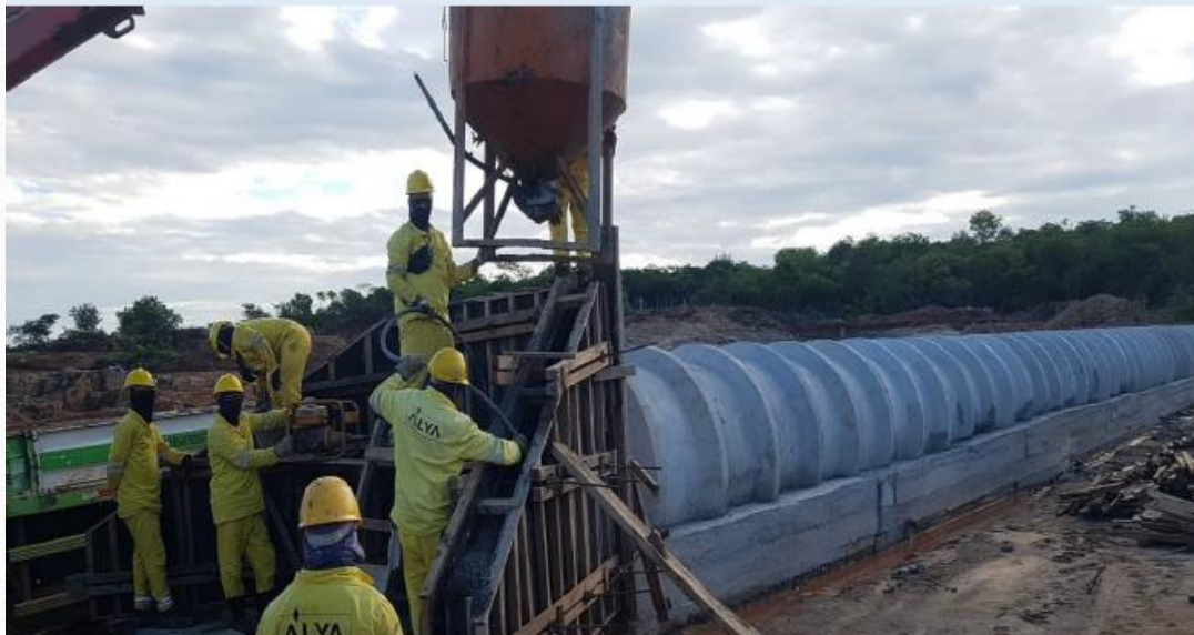
Canal 9 : Execução do bueiro 5
