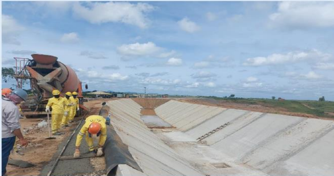
Canal 8: Execução da ancoragem da geomembrana
