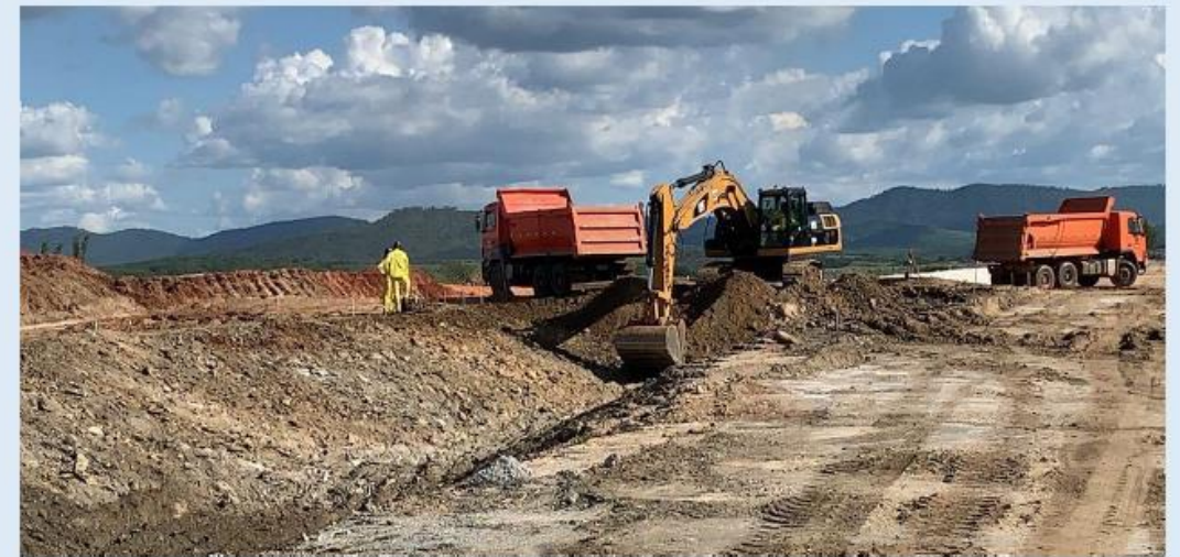
Canal 6B: Início da escavação da seção hidráulica
