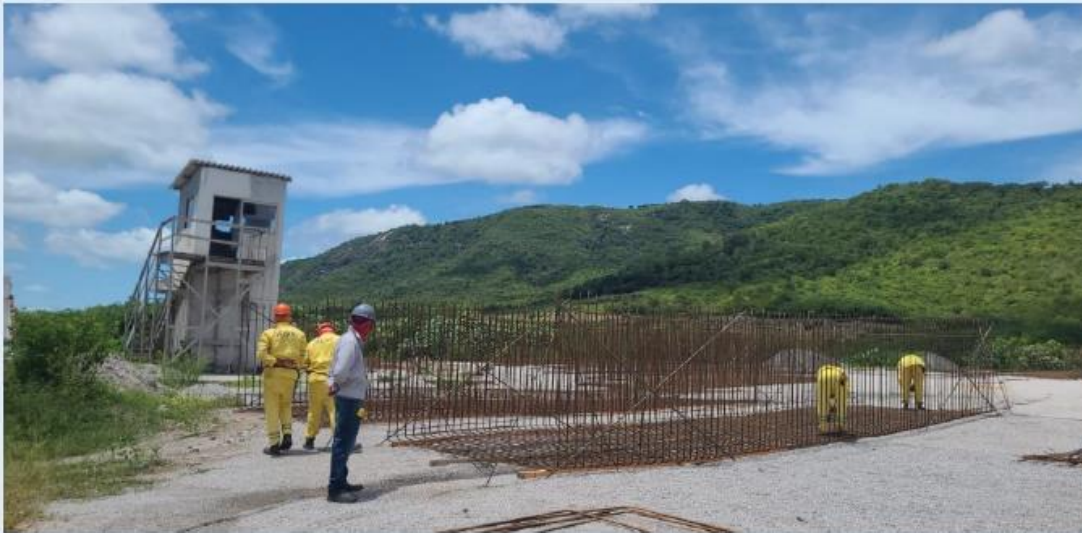
Canal 2: Execução armação do bueiro 1 (duplo)
