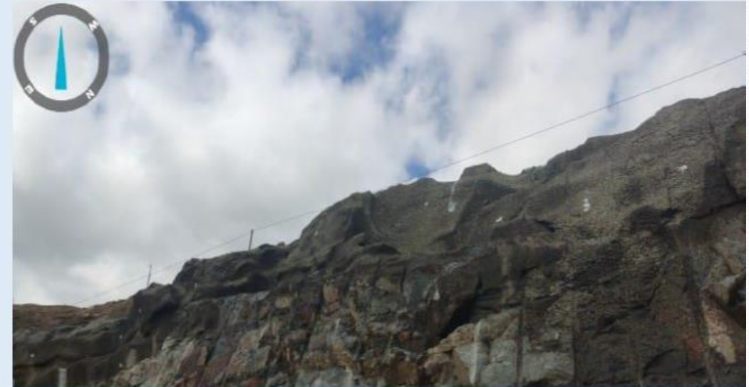
Túnel Major Sales: Marcação dos tirantes
