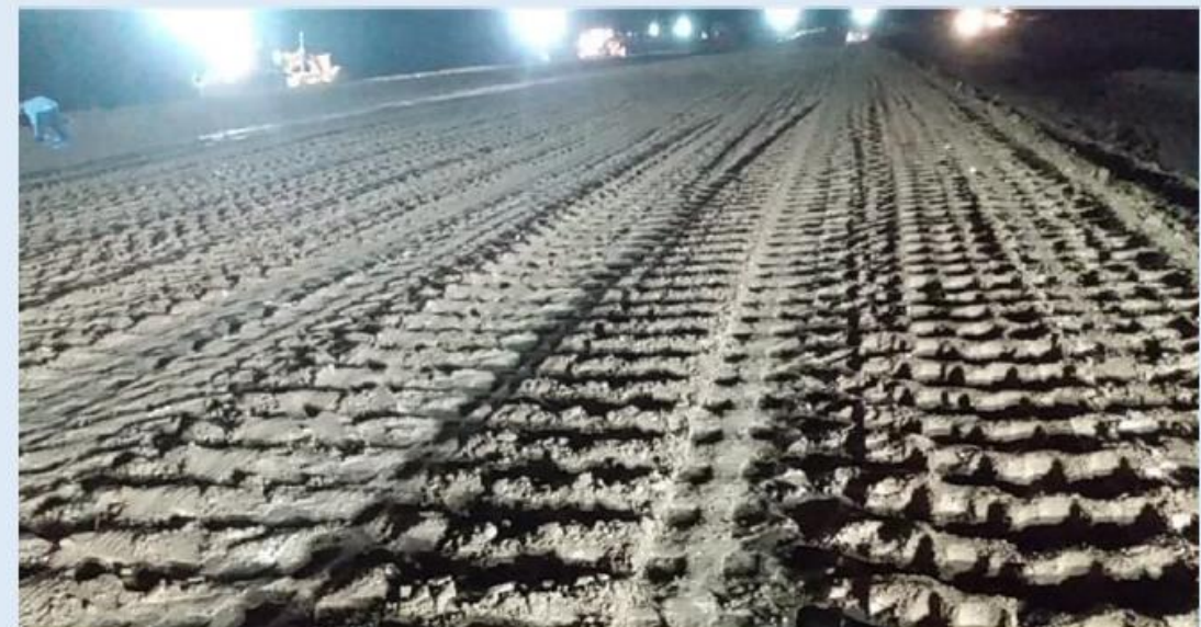
Canal 9: Execução do aterro (noturno)
