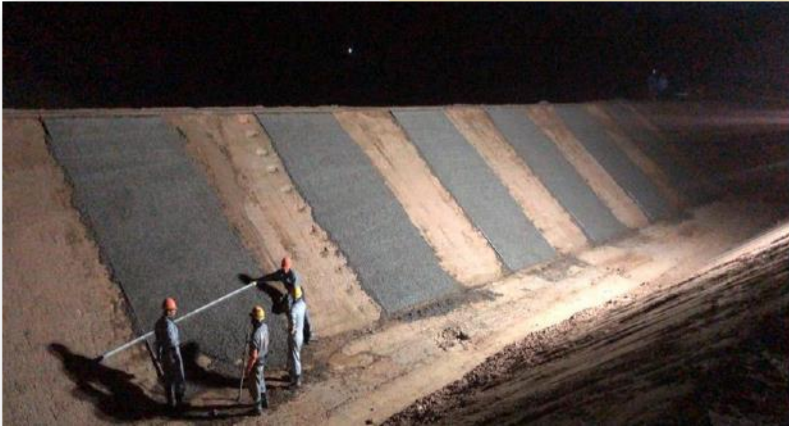
C6B: Execução do concreto poroso
