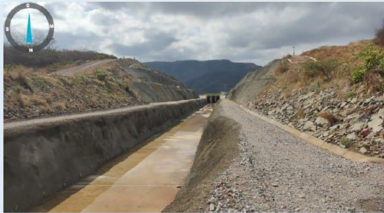
C1: Execução das drenagens externas (atividades paralisadas)
