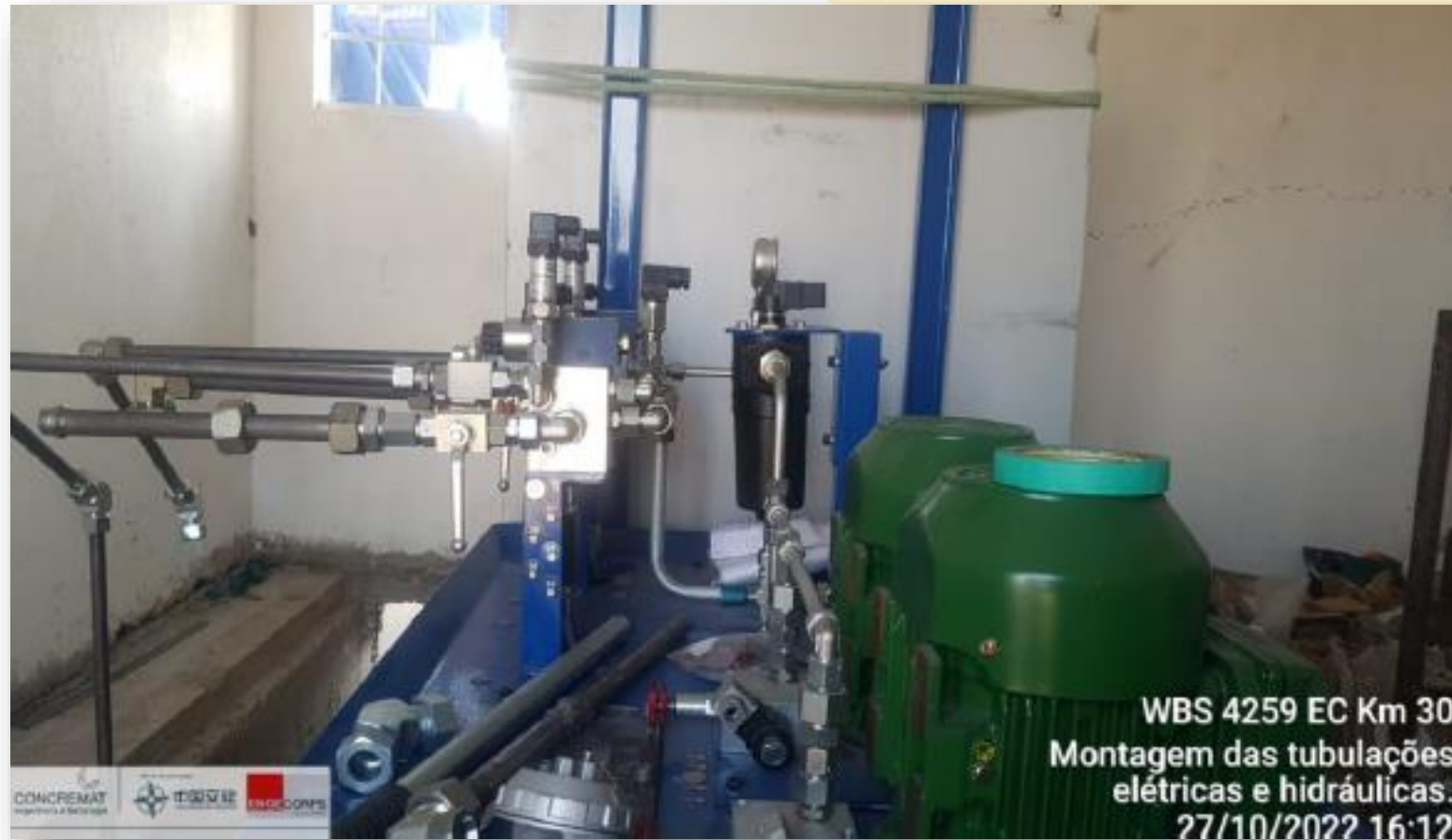
EC Km 30: Montagem dos equipamentos elétricos e hidráulicos
