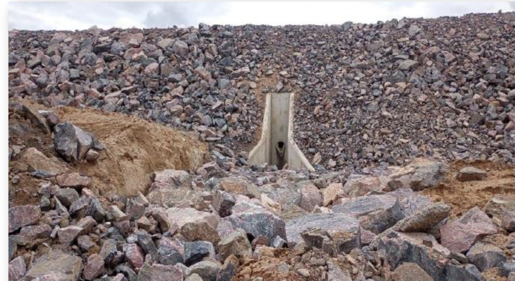
C5 Concretagem do medidor de vazão
