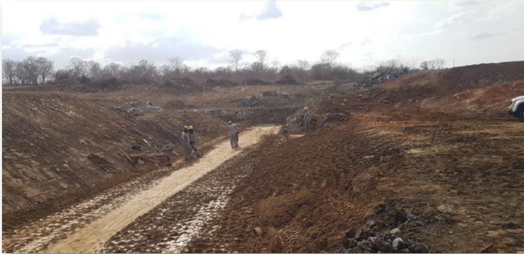
Canal 7B: Execução do aterro bueiro 8
