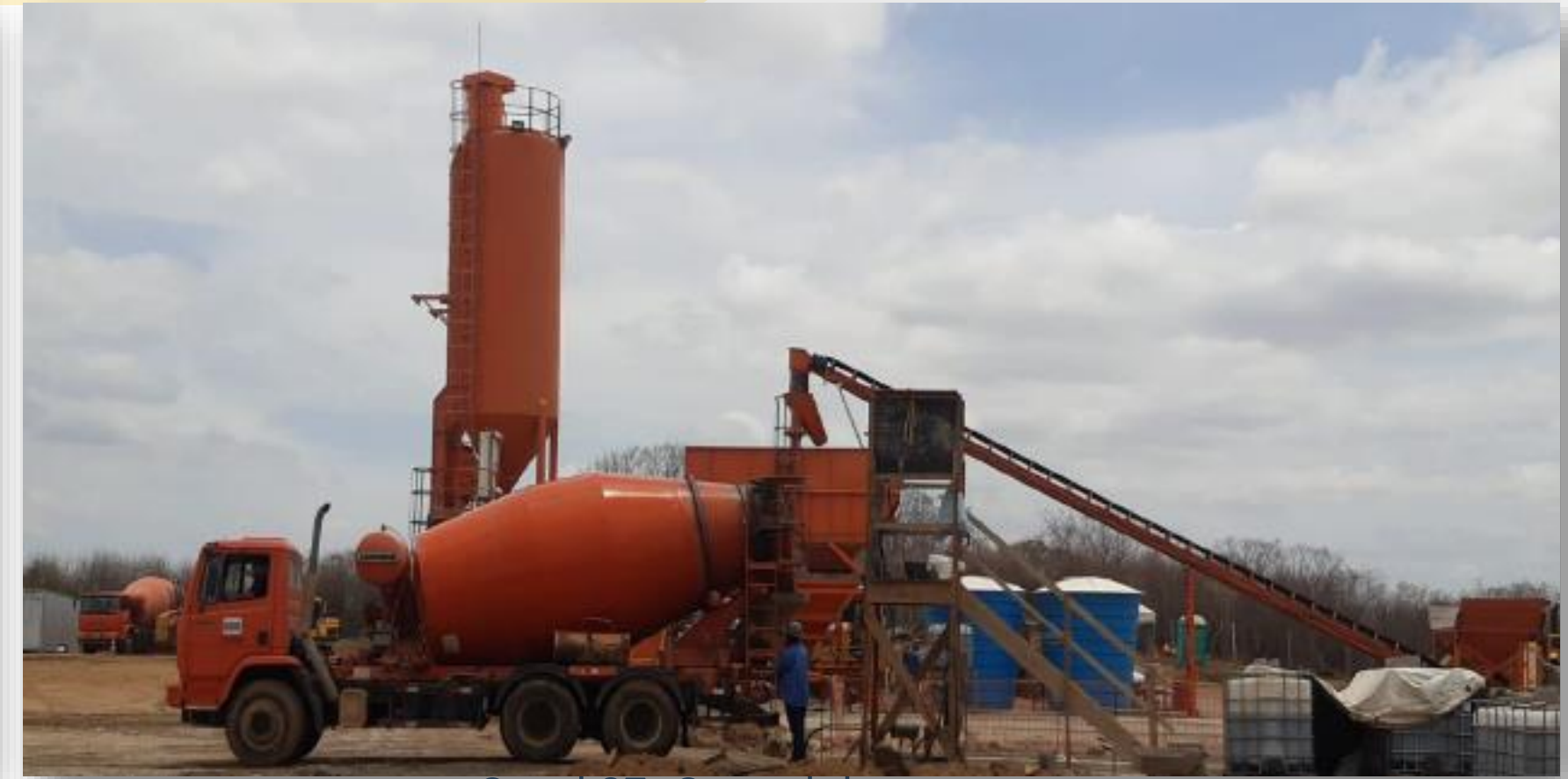
Canal 07: Central de concreto
