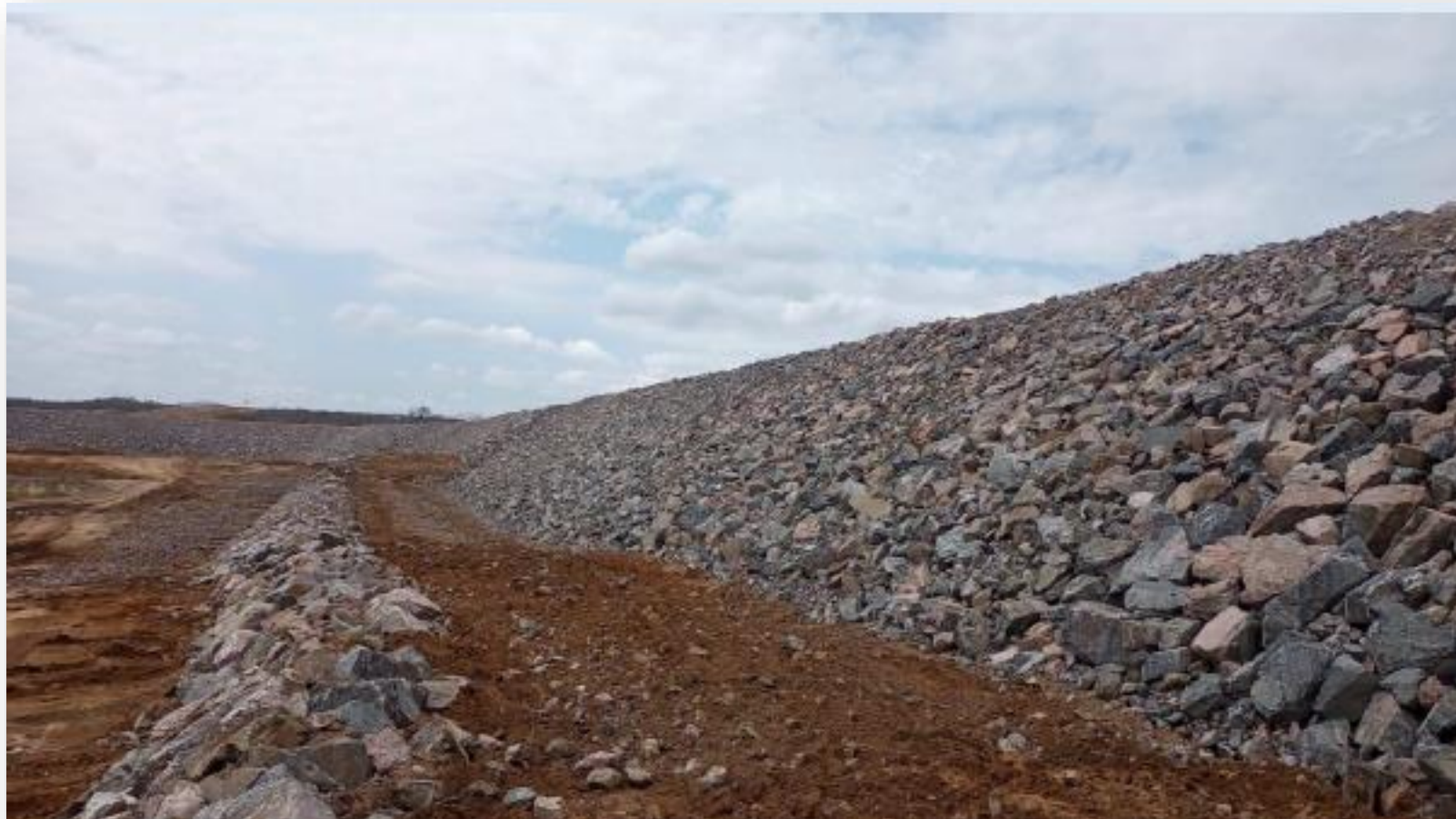
C5: Execução enrocamento de proteção
