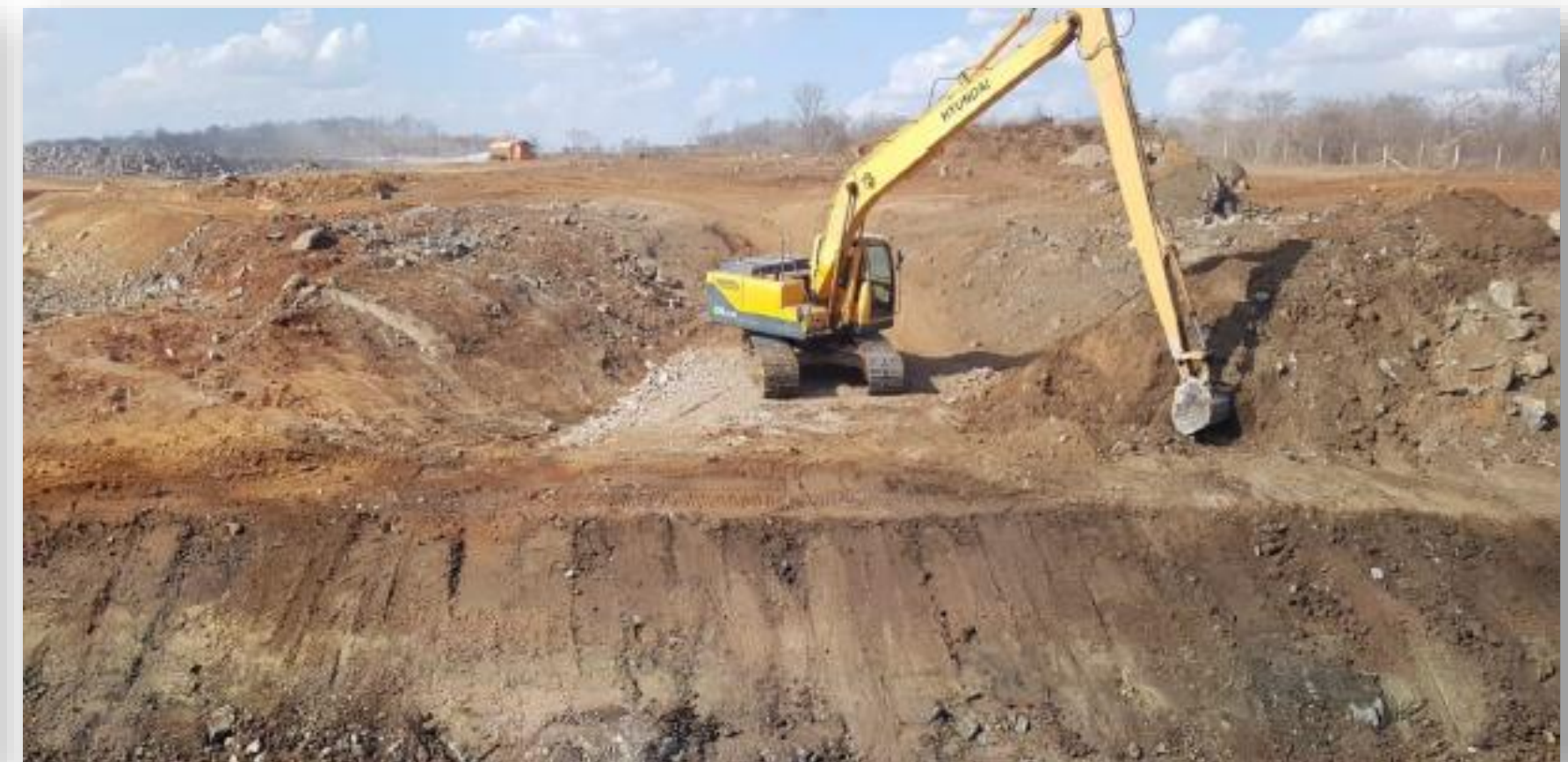
Canal 7B: Execução da terraplanagem
