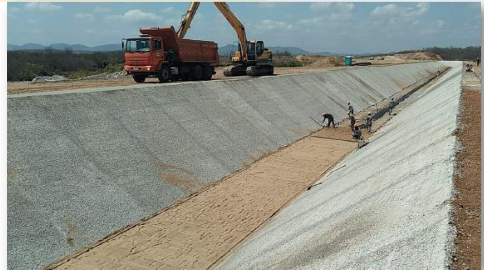
Canal 6B: Execução do dreno de fundo
