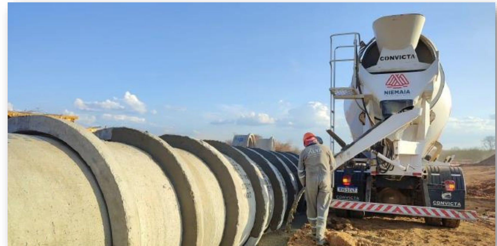
Canal 08: Execução do bueiro 04
