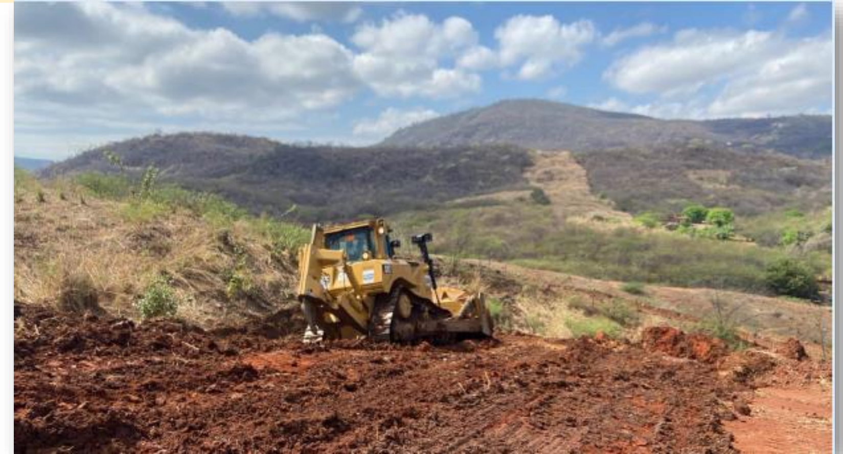
C2: Execução da supressão vegetal
