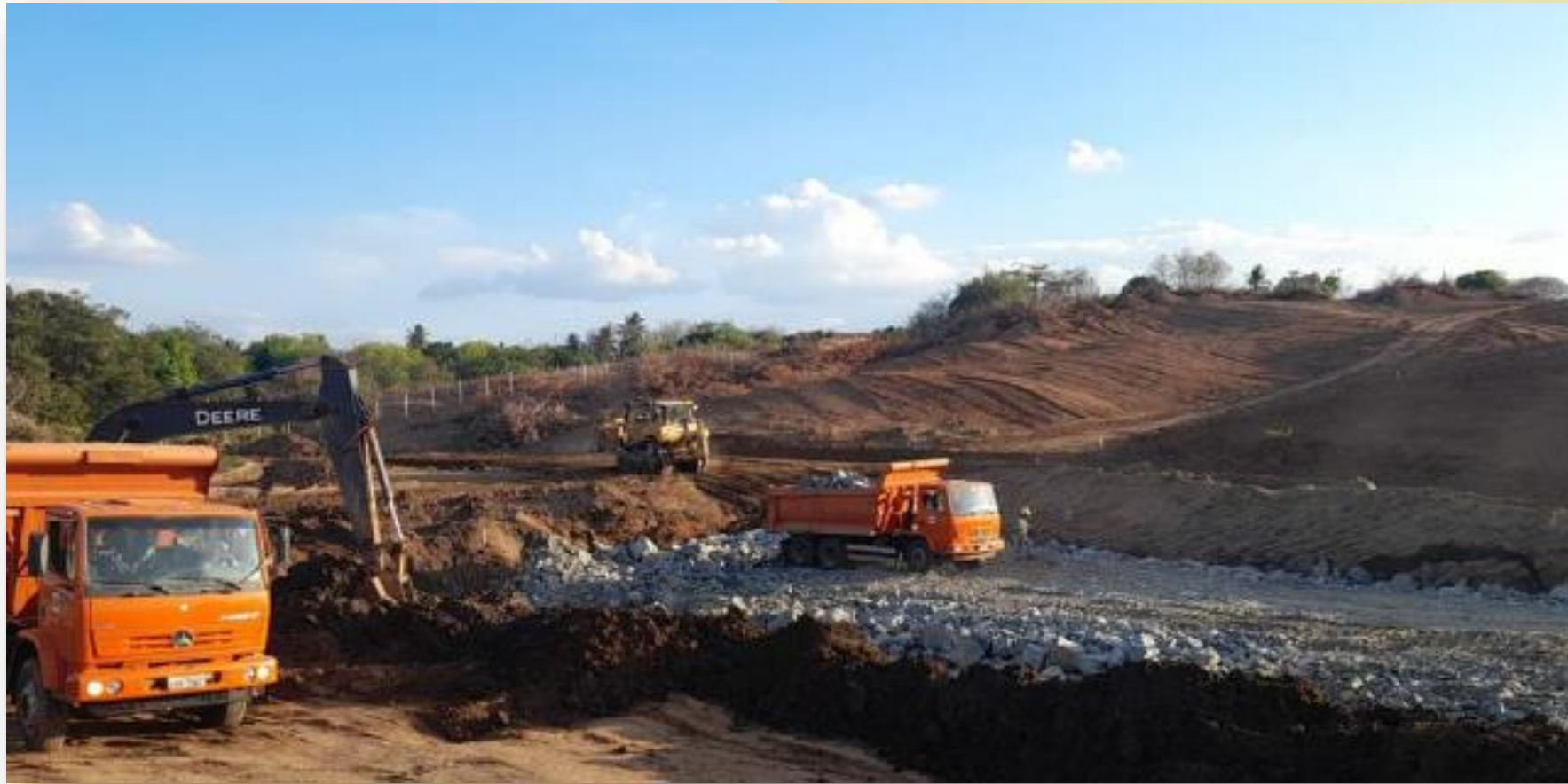
C7B: Execução do bueiro 13
