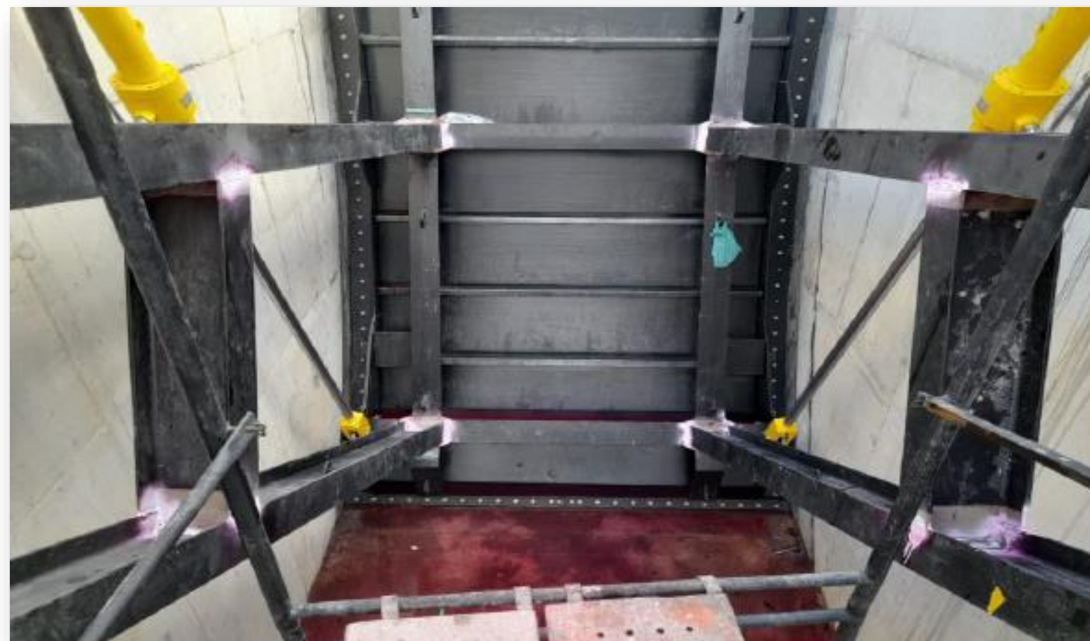
EC Km 30: Montagem das comportas
