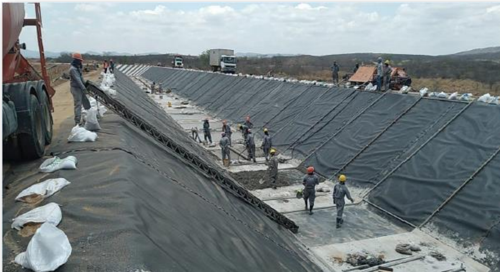
C6B: Execução do concreto de regularização
