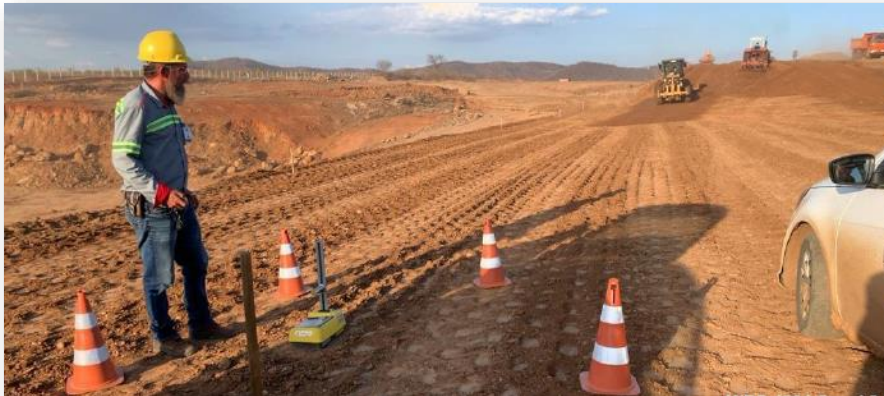
Canal 08: Execução da terraplanagem (ensaio da camada com densímetro)
