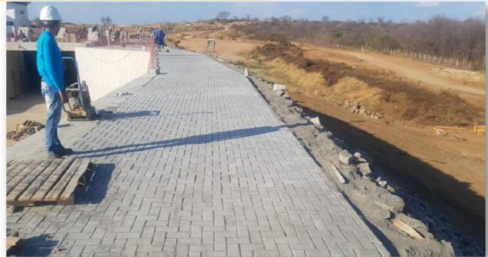
EC Km 30: Execução do piso
