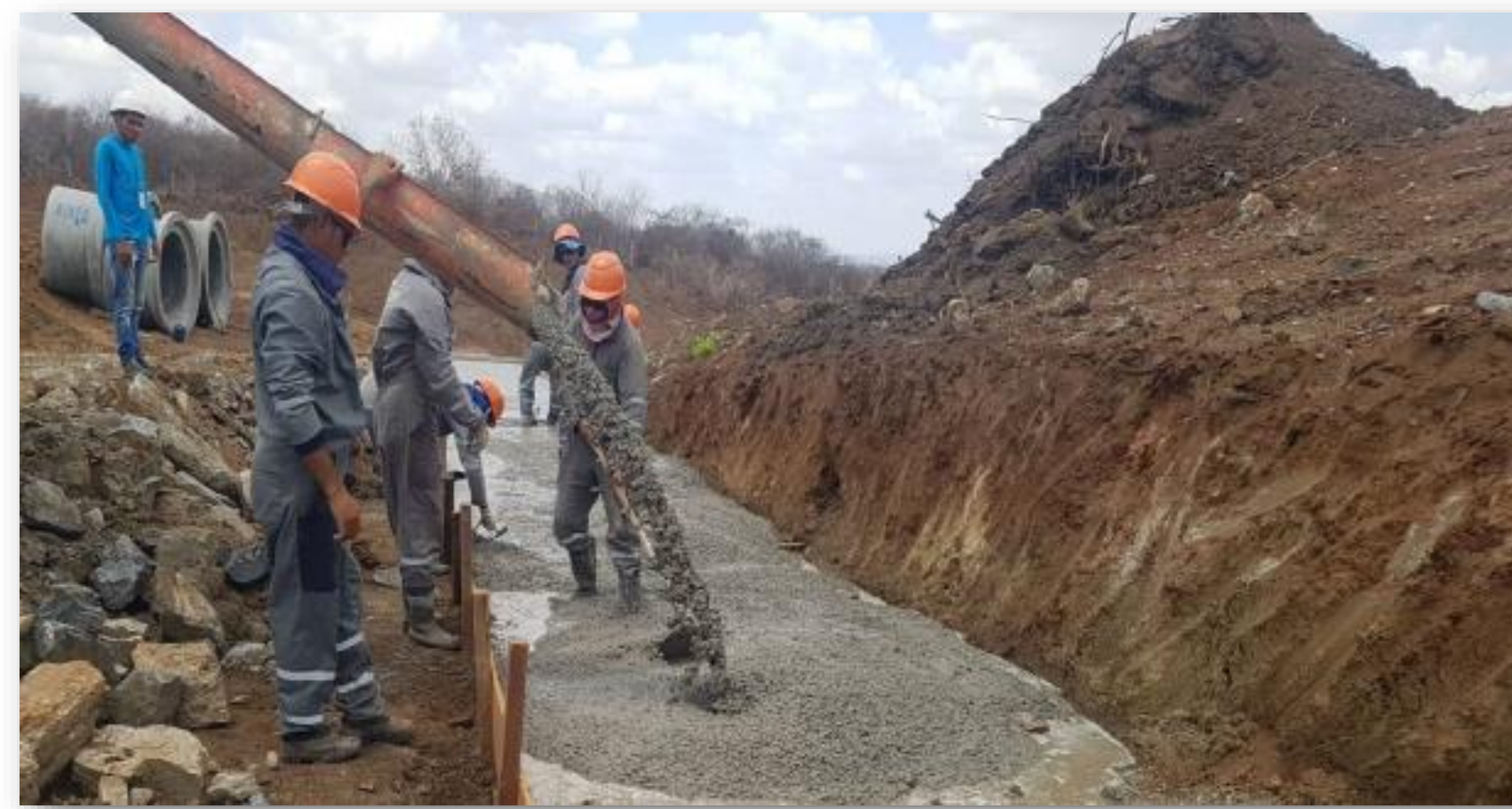
Canal 7B: Execução do bueiro 11 (berço)
