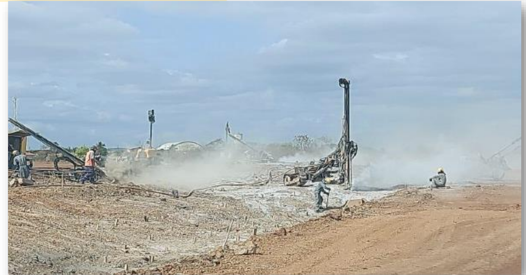
Canal 08: Execução dos furos para detonação
