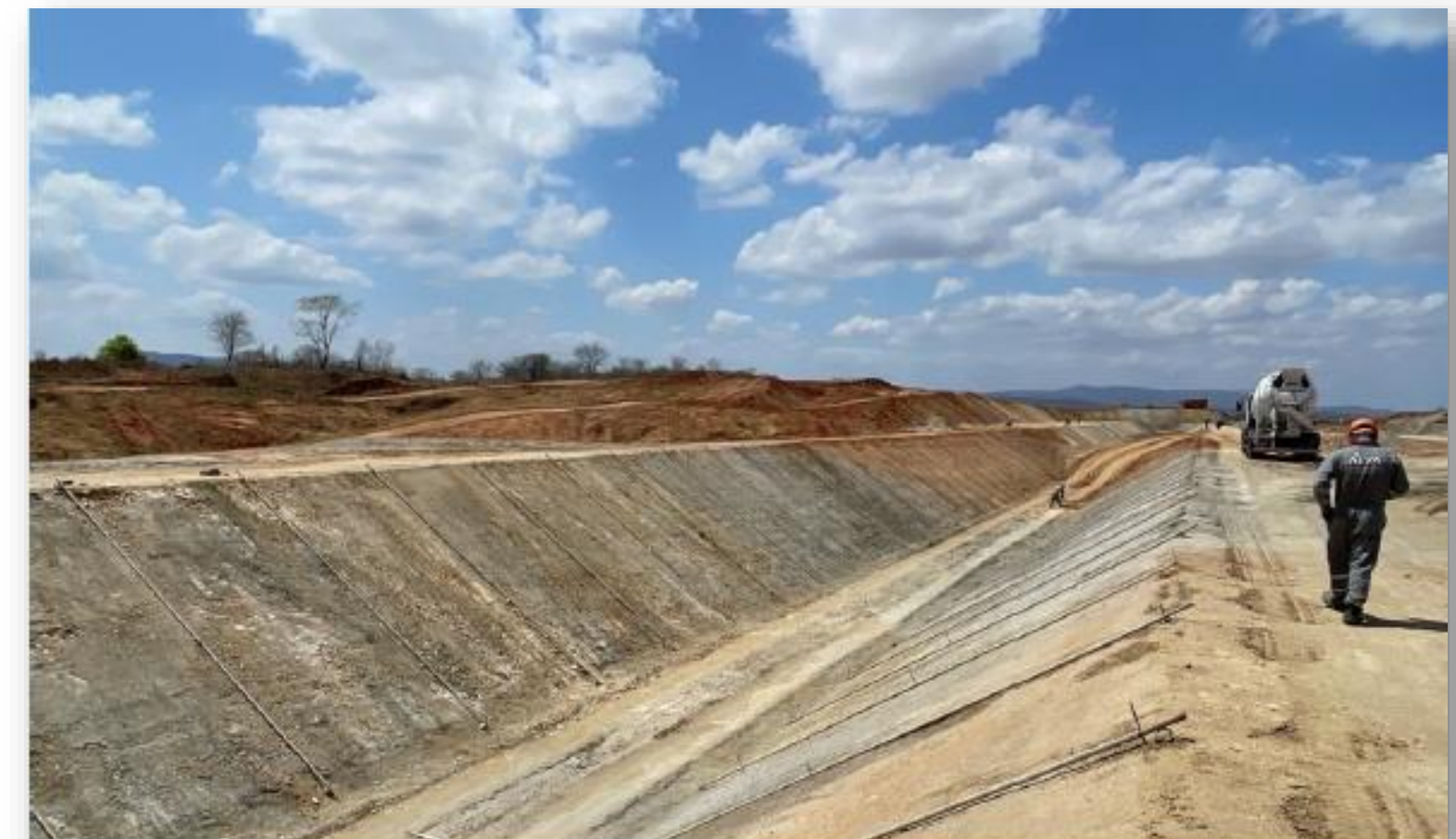
C6B: Execução da seção hidráulica
