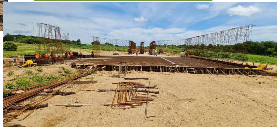
Estrutura de Controle do Ramal do Salgado
