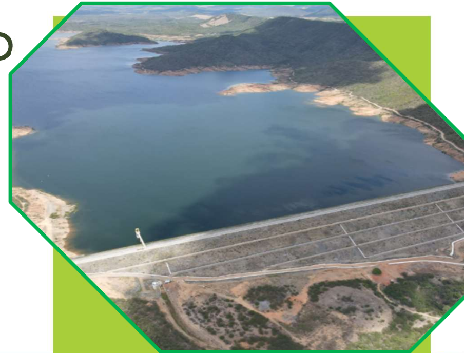
Reservatório Boa Vista (WBS 1119)
