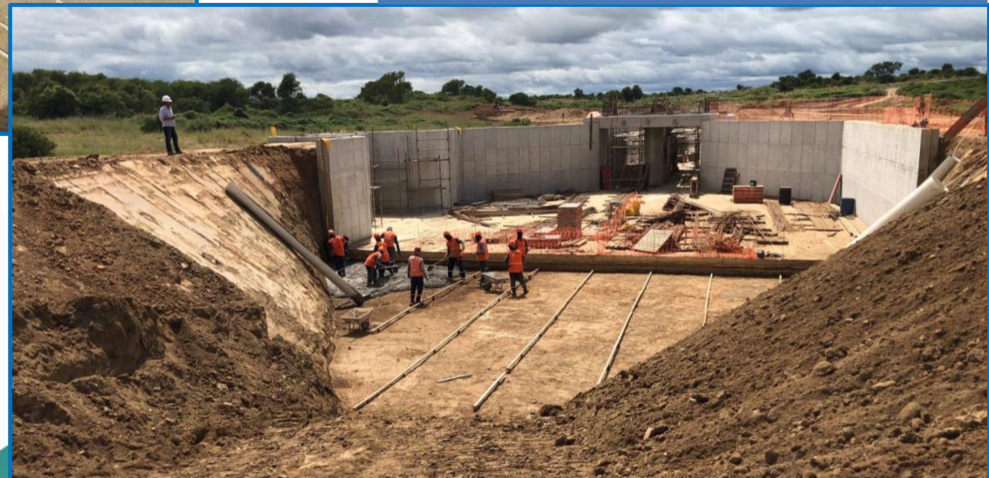
Estrutura de Controle km 30
