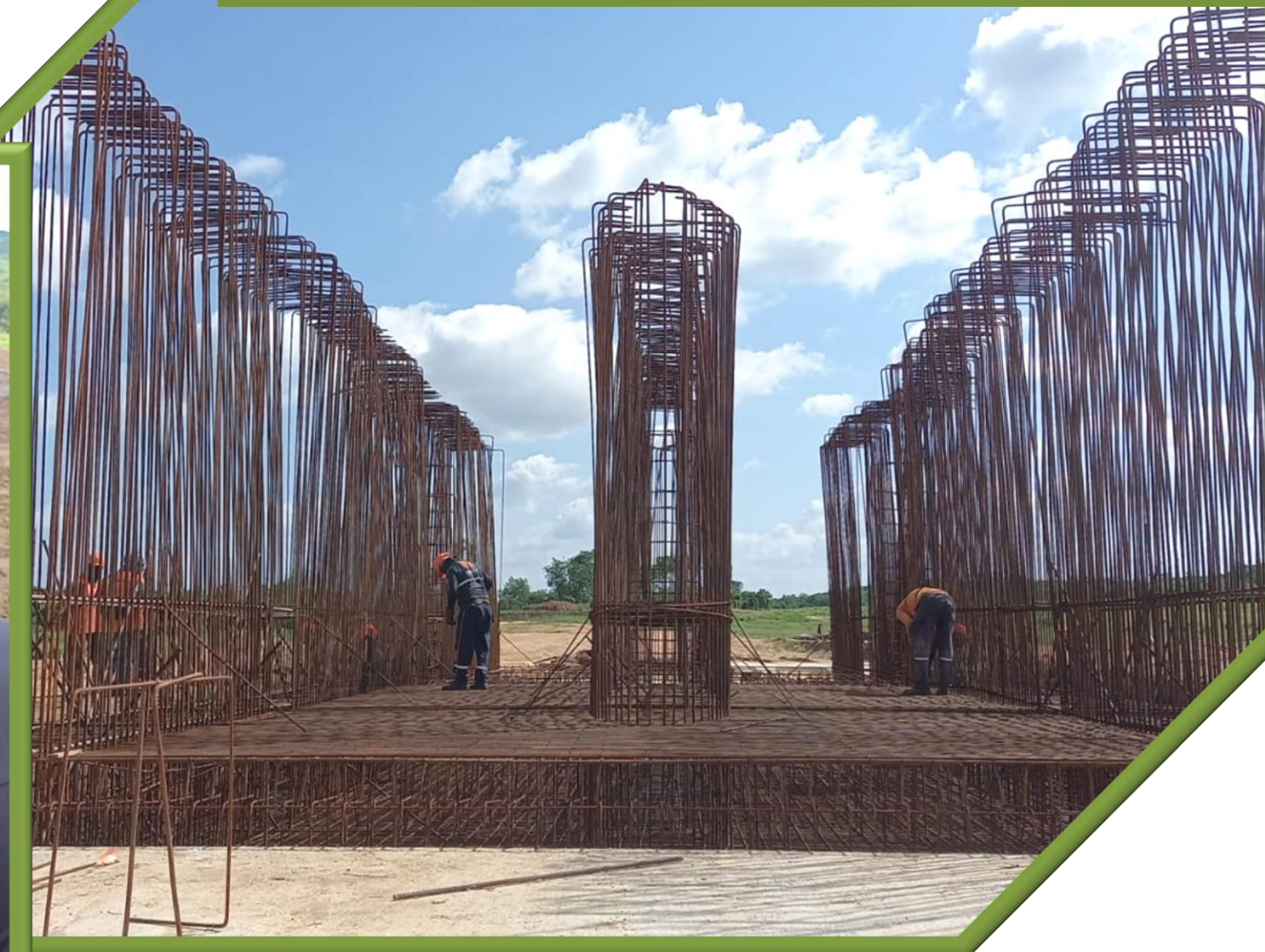
Estrutura de Controle do Ramal do Salgado
