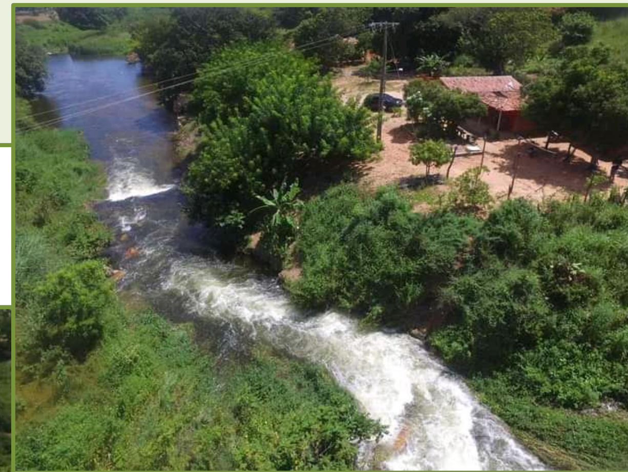
Reservatório Engenheiro Avidos
