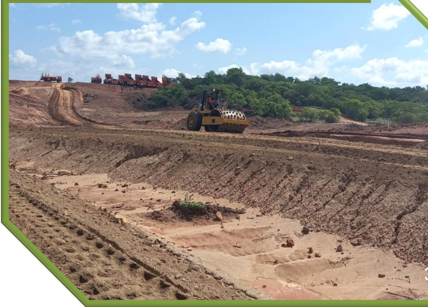
Canal 05 - Compactação de aterro
