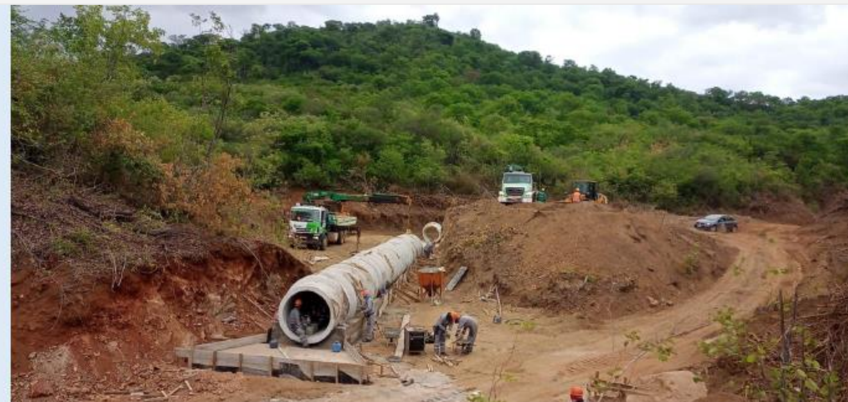
Canal 2: Vista do bueiro 04
