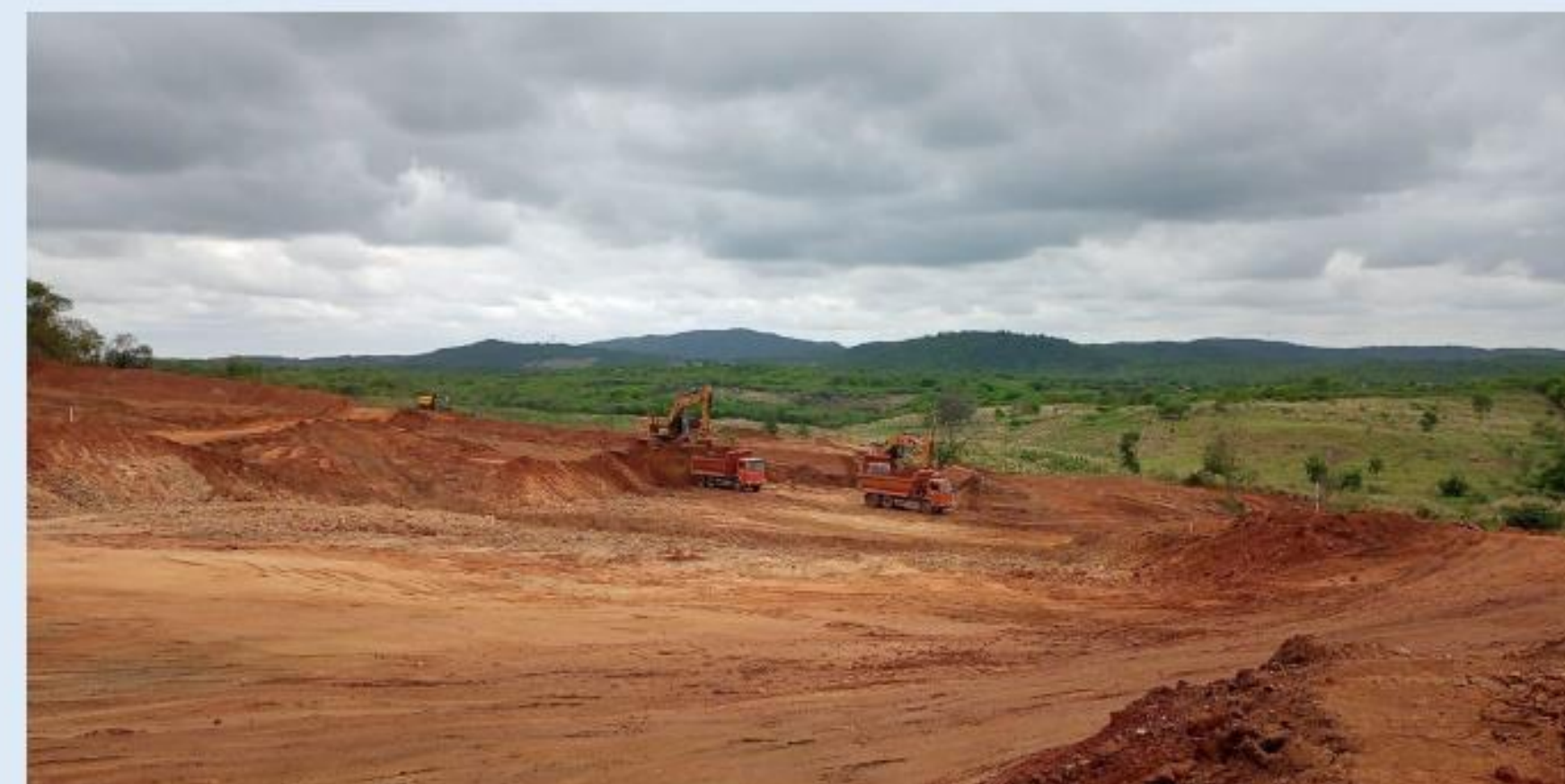
Canal 2: Execução da terraplenagem
