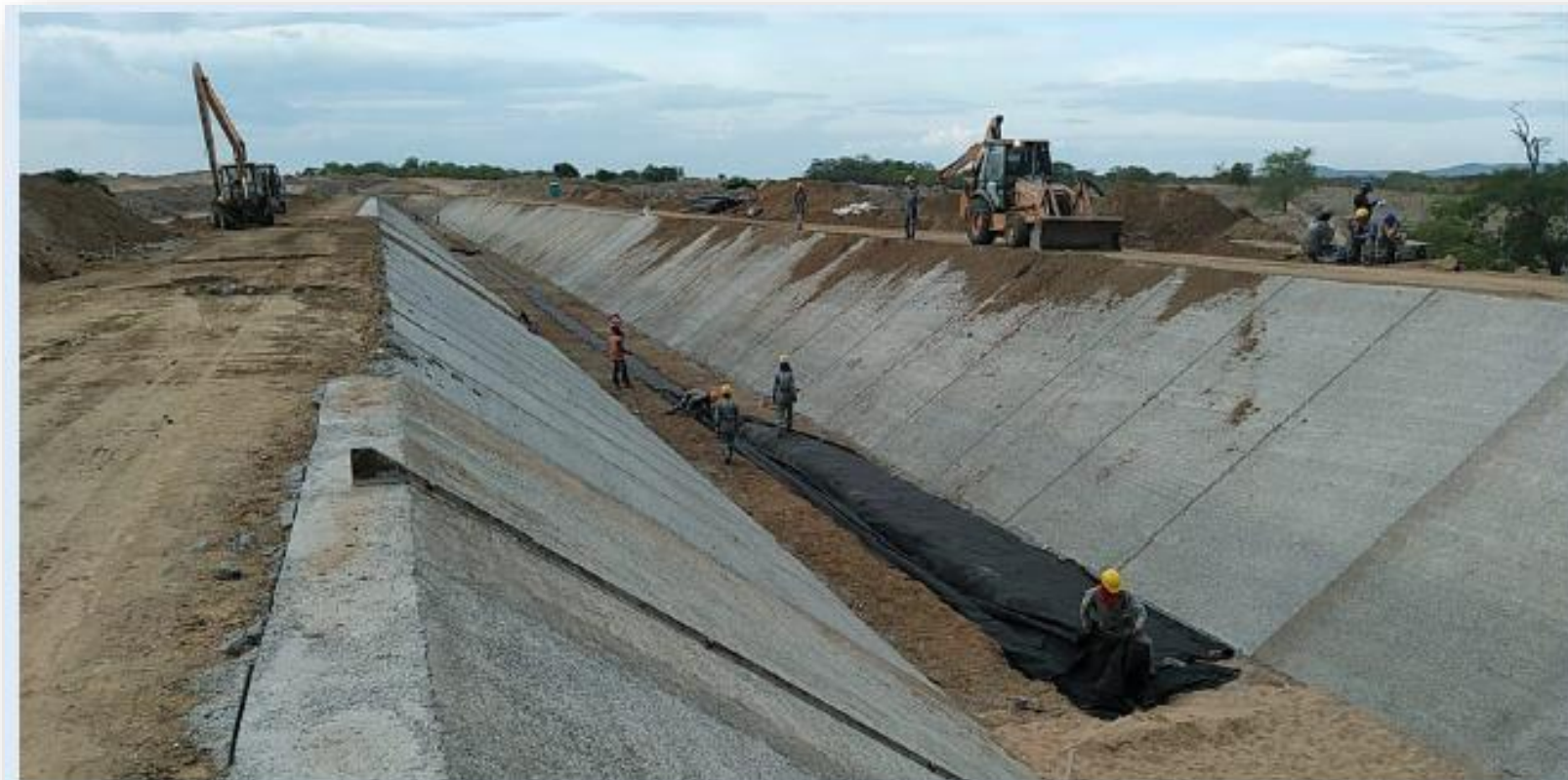
Canal 7A: Execução dreno de fundo do canal
