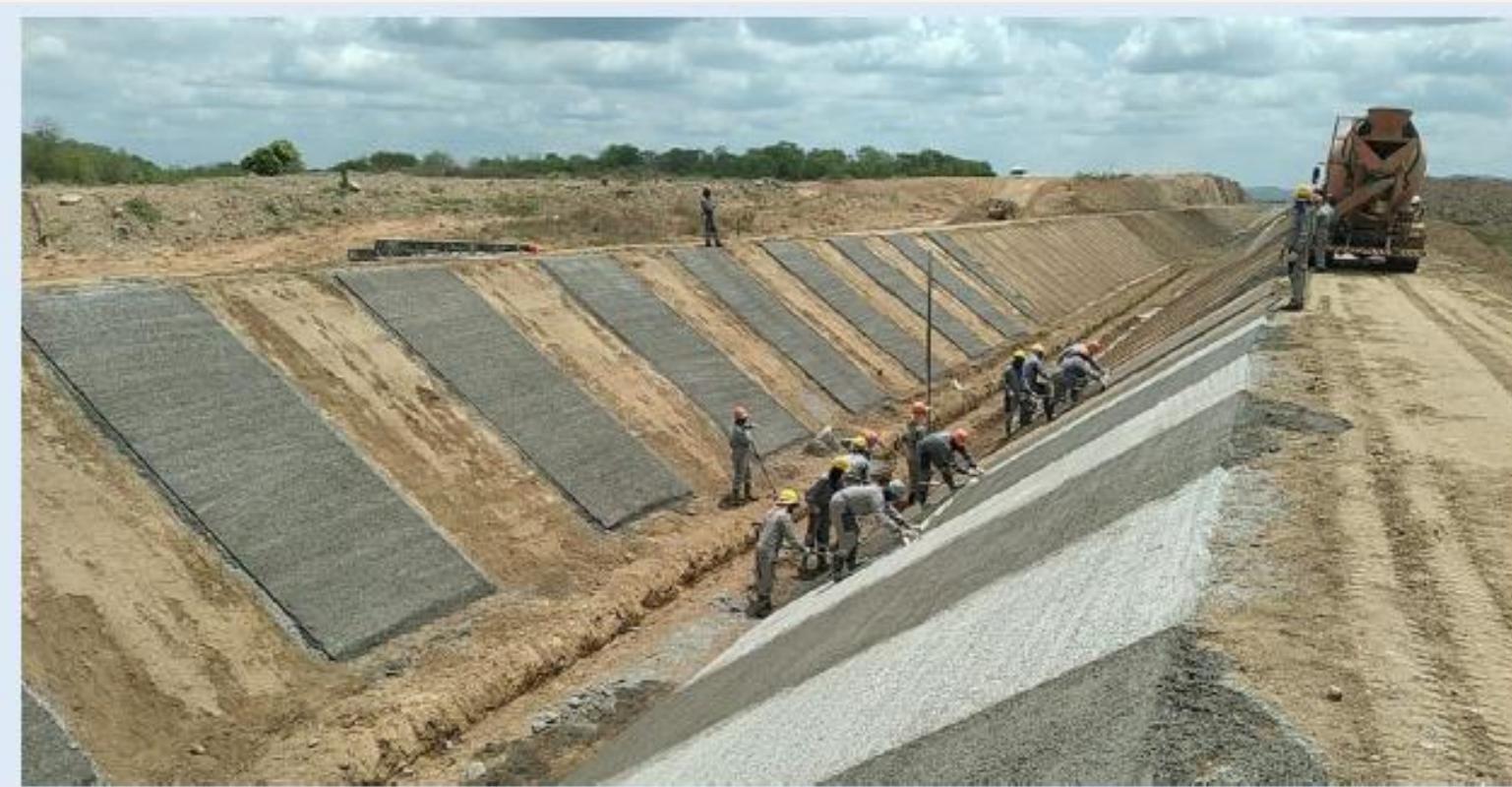
Canal 7A: Execução do concreto poroso
