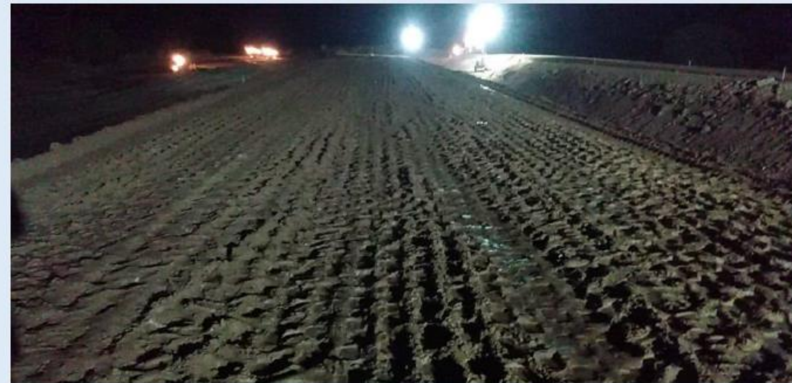
Canal 5: Execução do Aterro (noturno)
