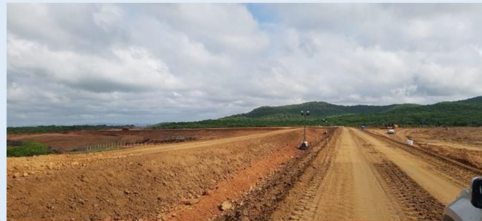
Canal 8: Execução do aterro
