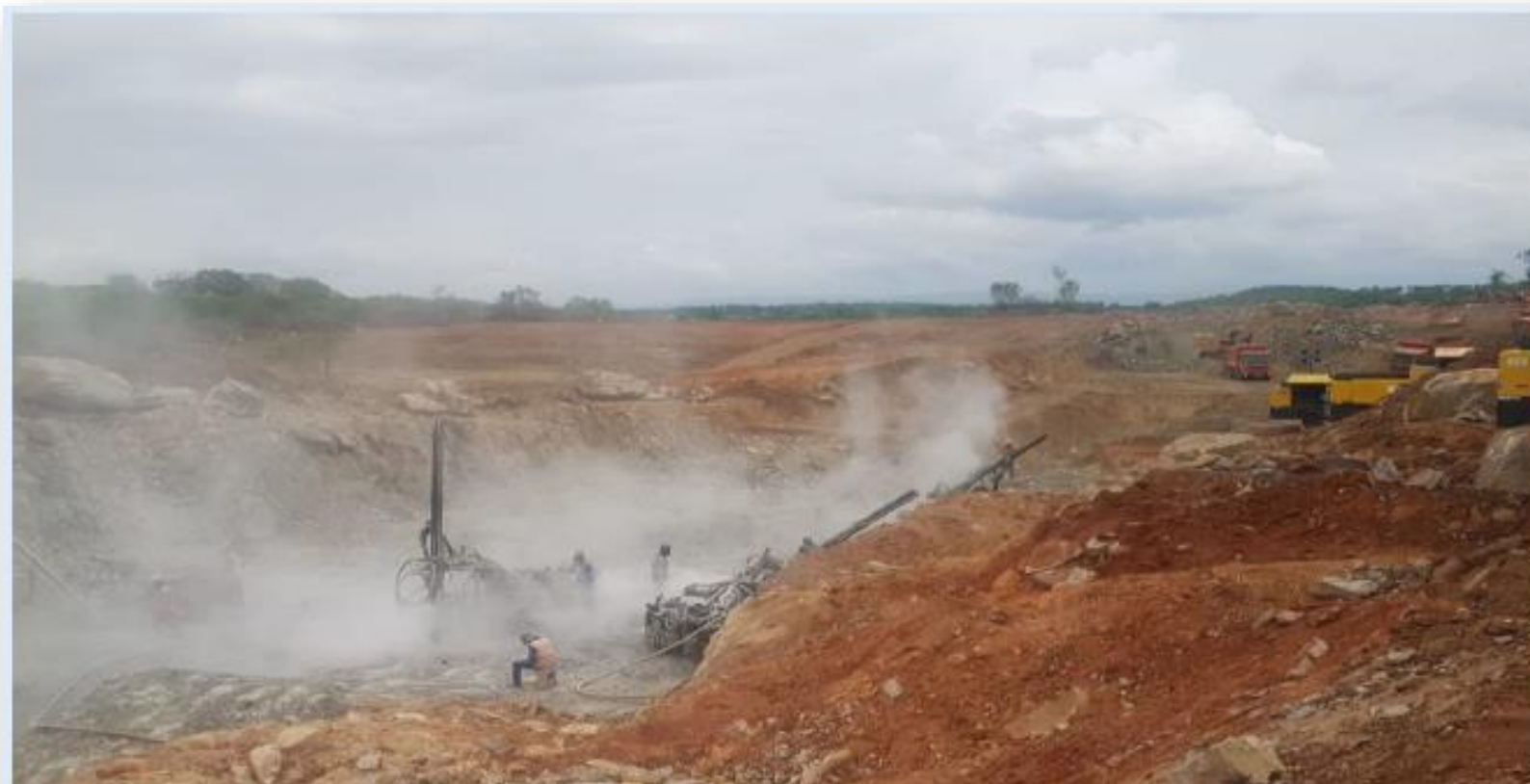
Canal 8: Execução da escavação
