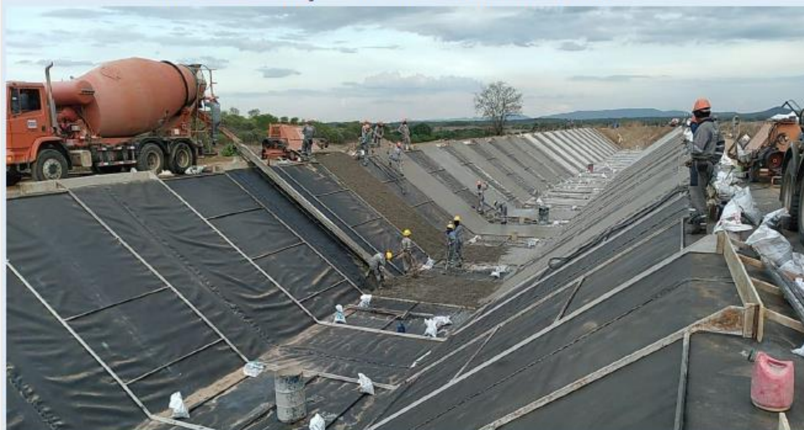
Canal 7A: Concretagem do canal
