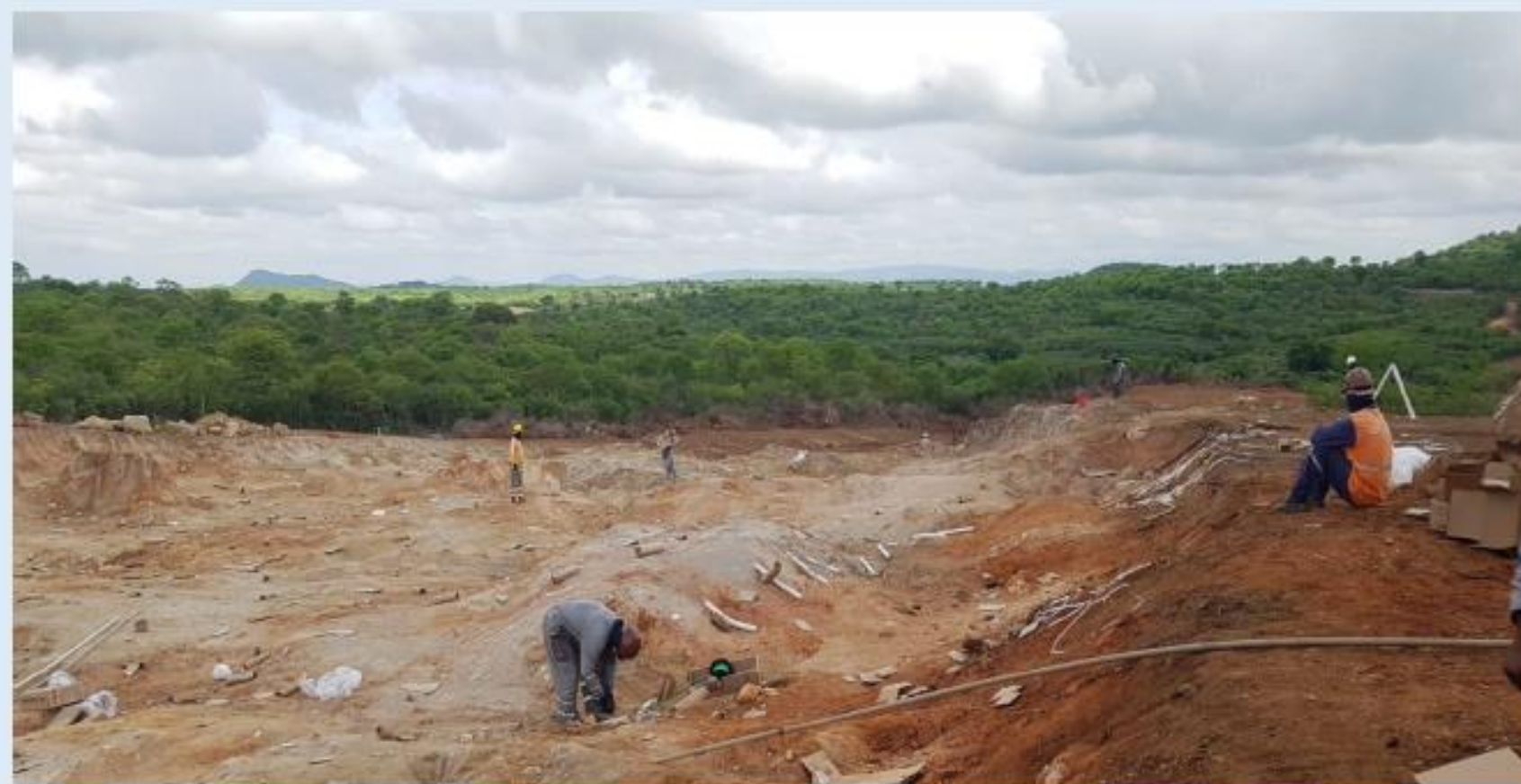
Canal 8: Preparação para detonação
