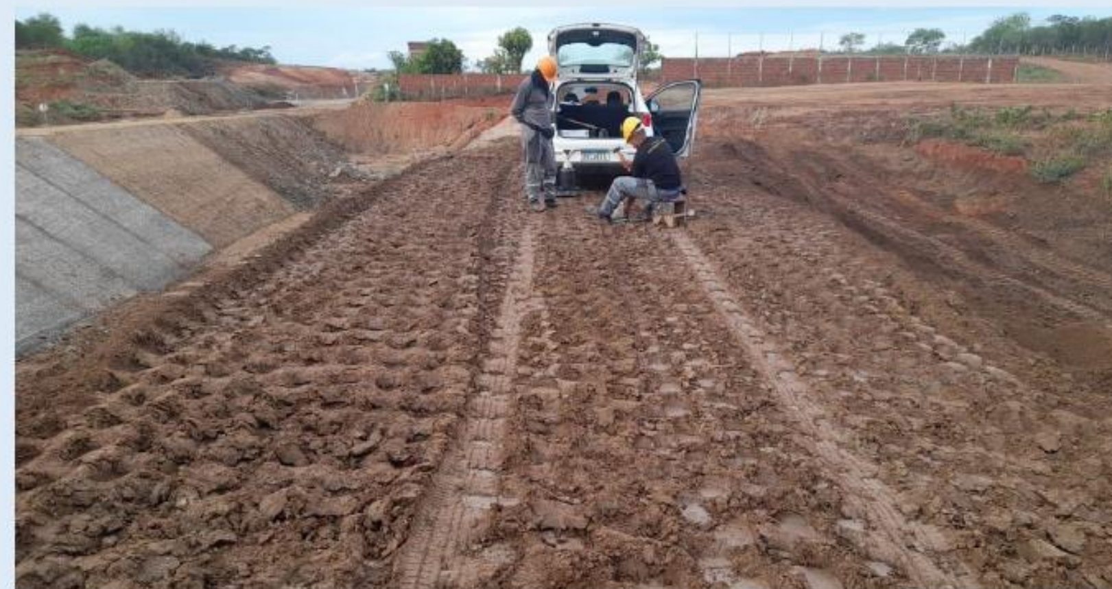
Canal 6: Execução da terraplanagem (ensaio)
