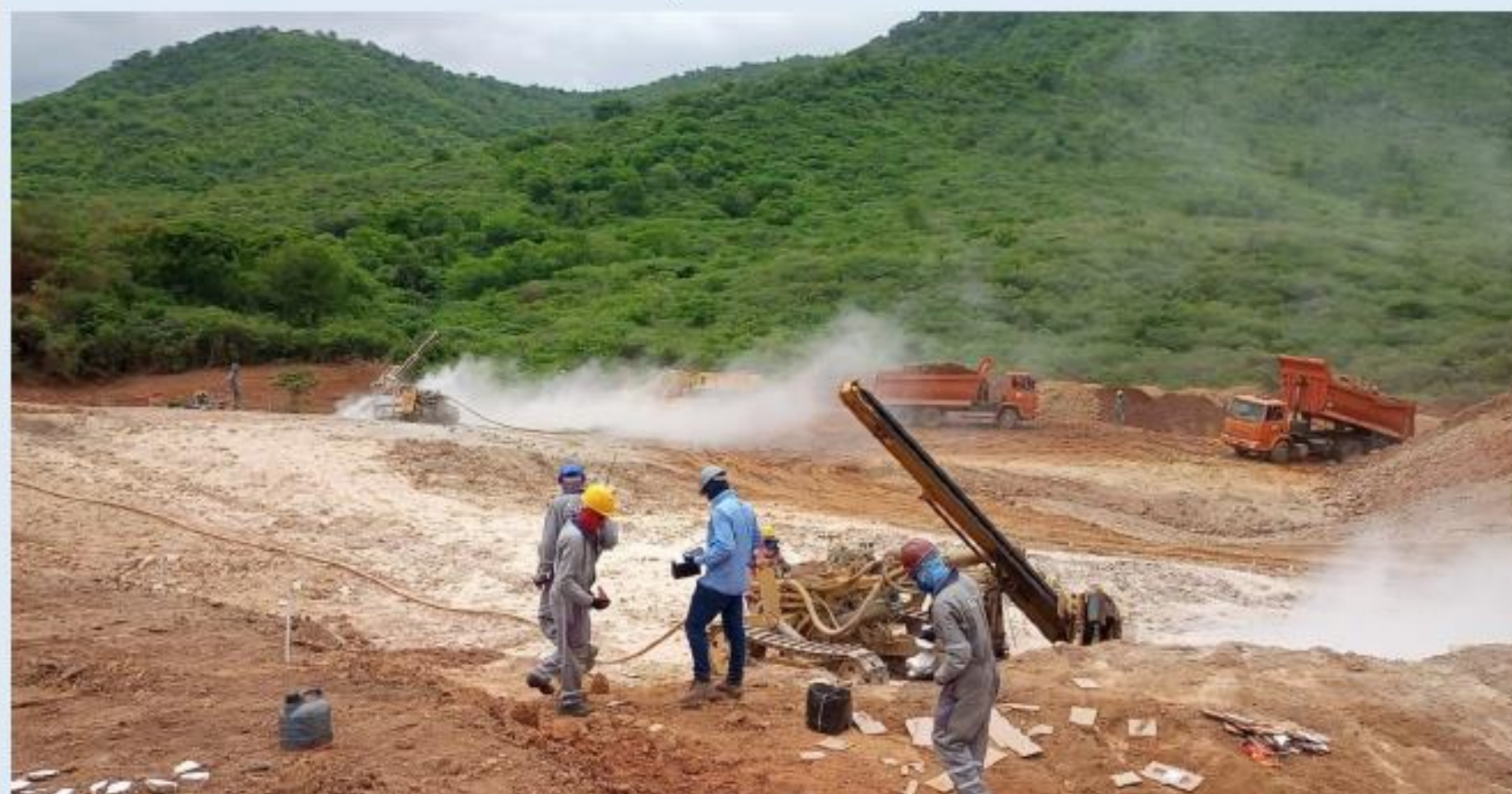
Canal 2: Execução de Escavação
