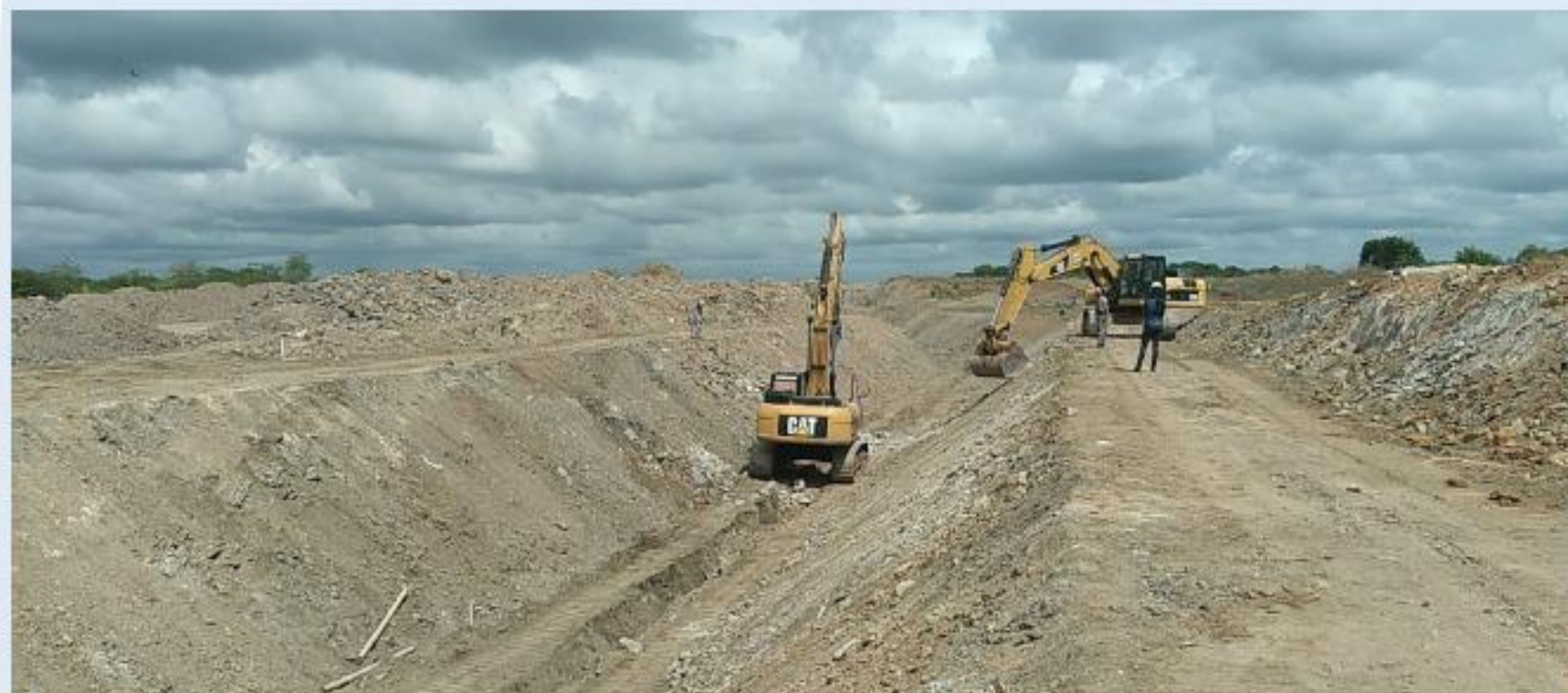
Canal 07: Execução da regularização do talude interno da seção hidráulica
