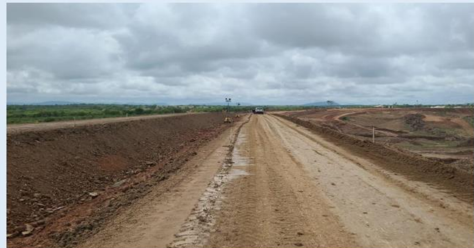
Canal 8: Execução da terraplenagem
