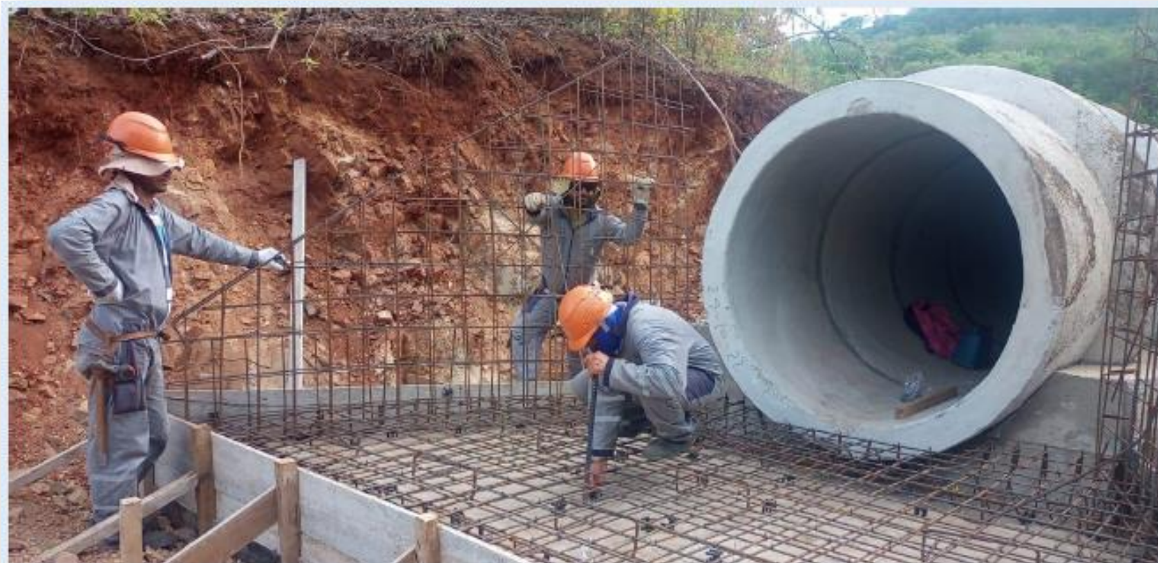
Canal 2: Execução da do bueiro 04
