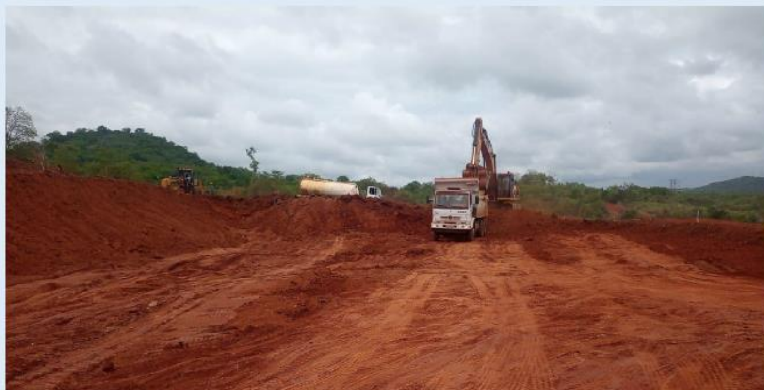
Canal 2: Execução da terraplanagem
