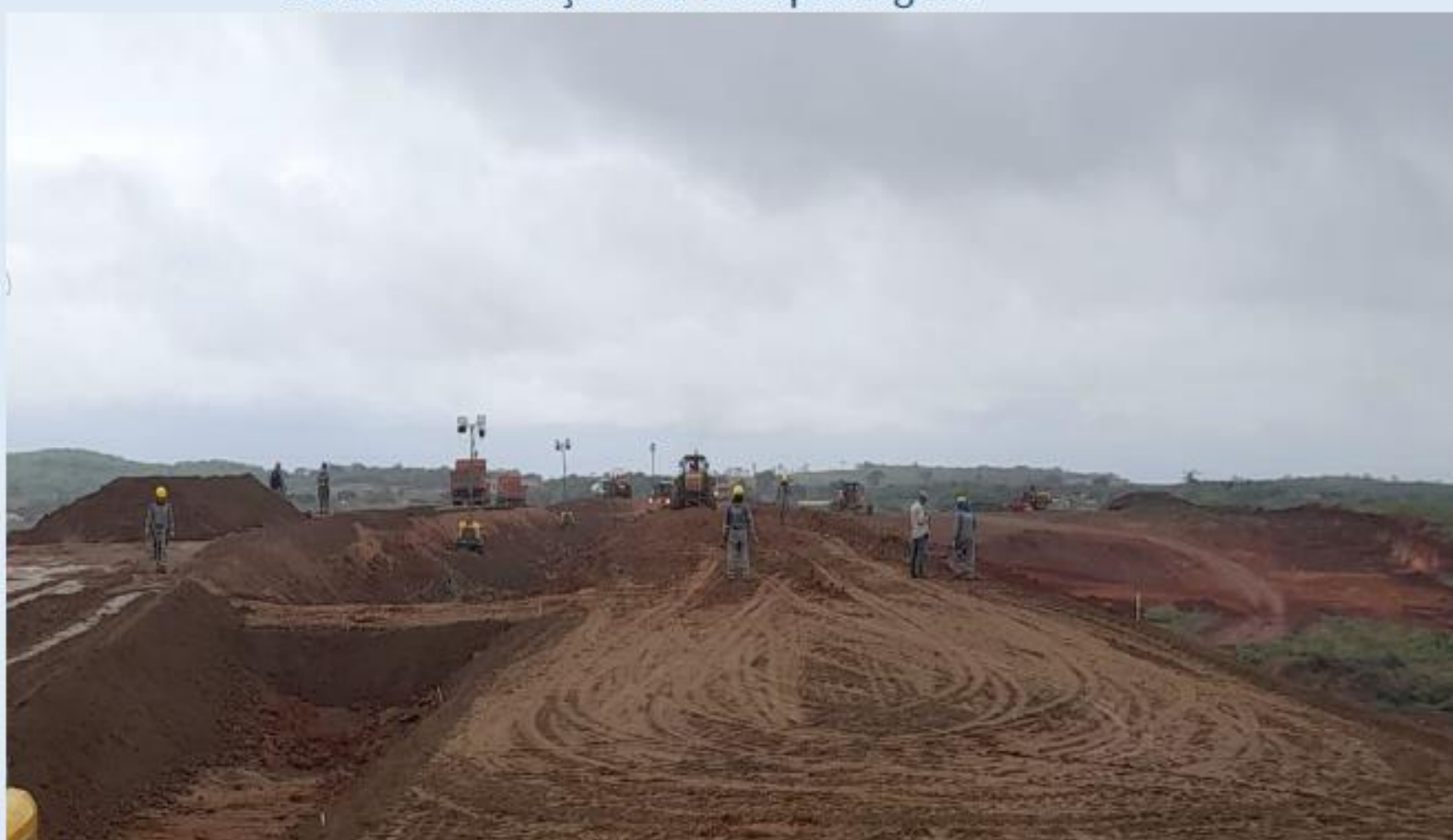
Canal 5: Execução da terraplanagem
