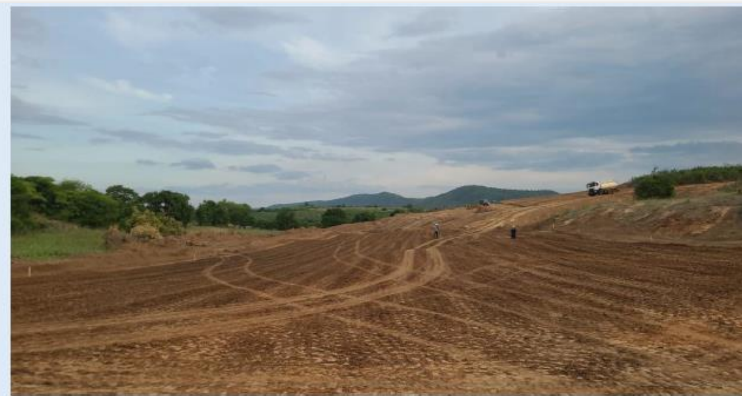
Canal 9: Vista do trecho concluído da supressão vegetal
