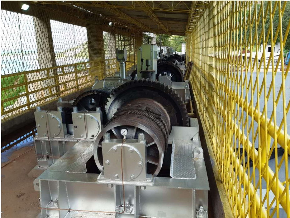
Reservatório Engenheiro Avidos/PB
