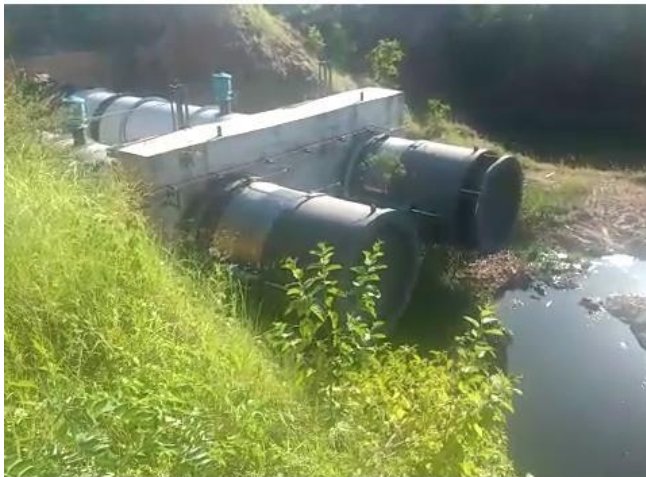
Saída PISF: 2 tubos com diâmetro 2600mm
