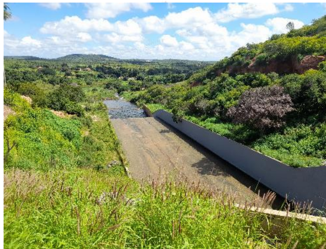
Água do PISF passando pelo vertedouro
