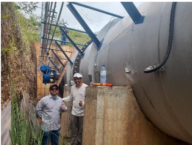
Medição ANA: tubulação com 2600mm de diâmetro
