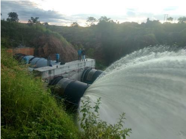
Abertura das comportas: medição de vazão
