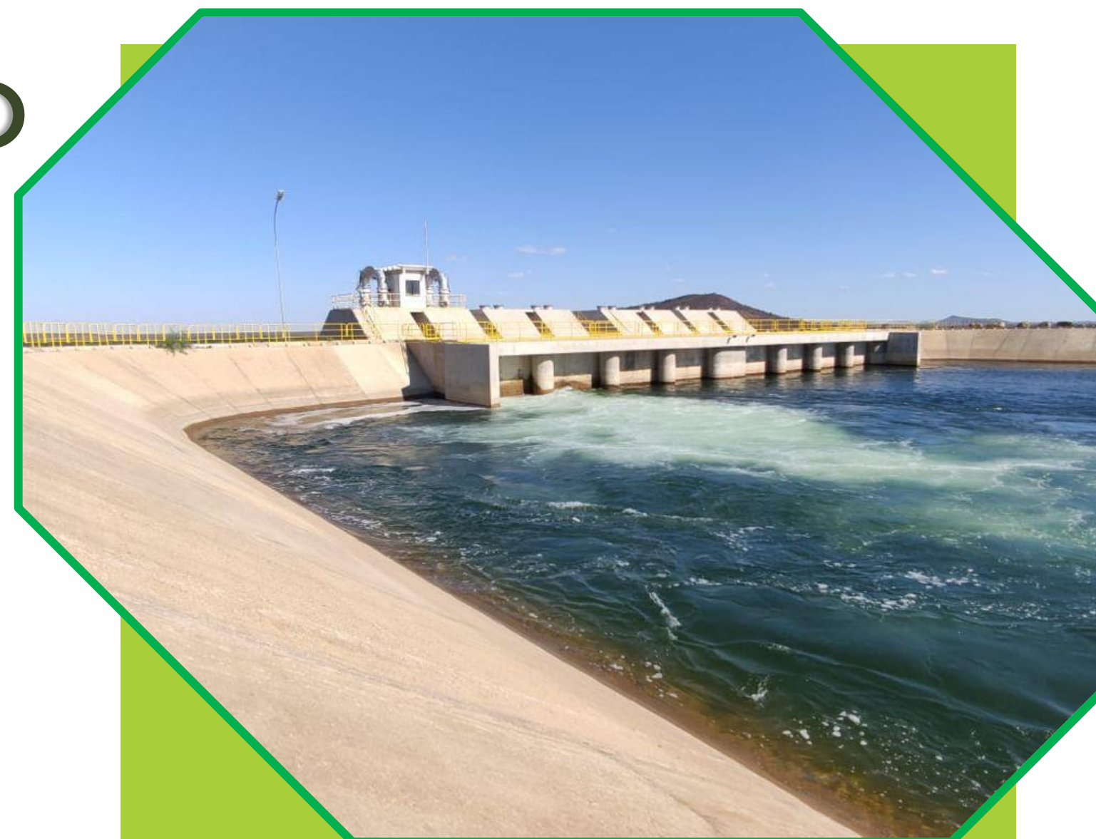
Forebay de jusante da EBI-1 (WBS 1610)
