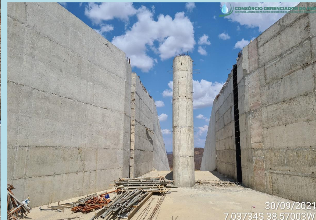
Transição de entrada do Rápido (WBS 1382)
