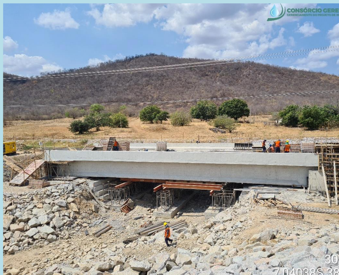
Ponte sobre a PB-400
