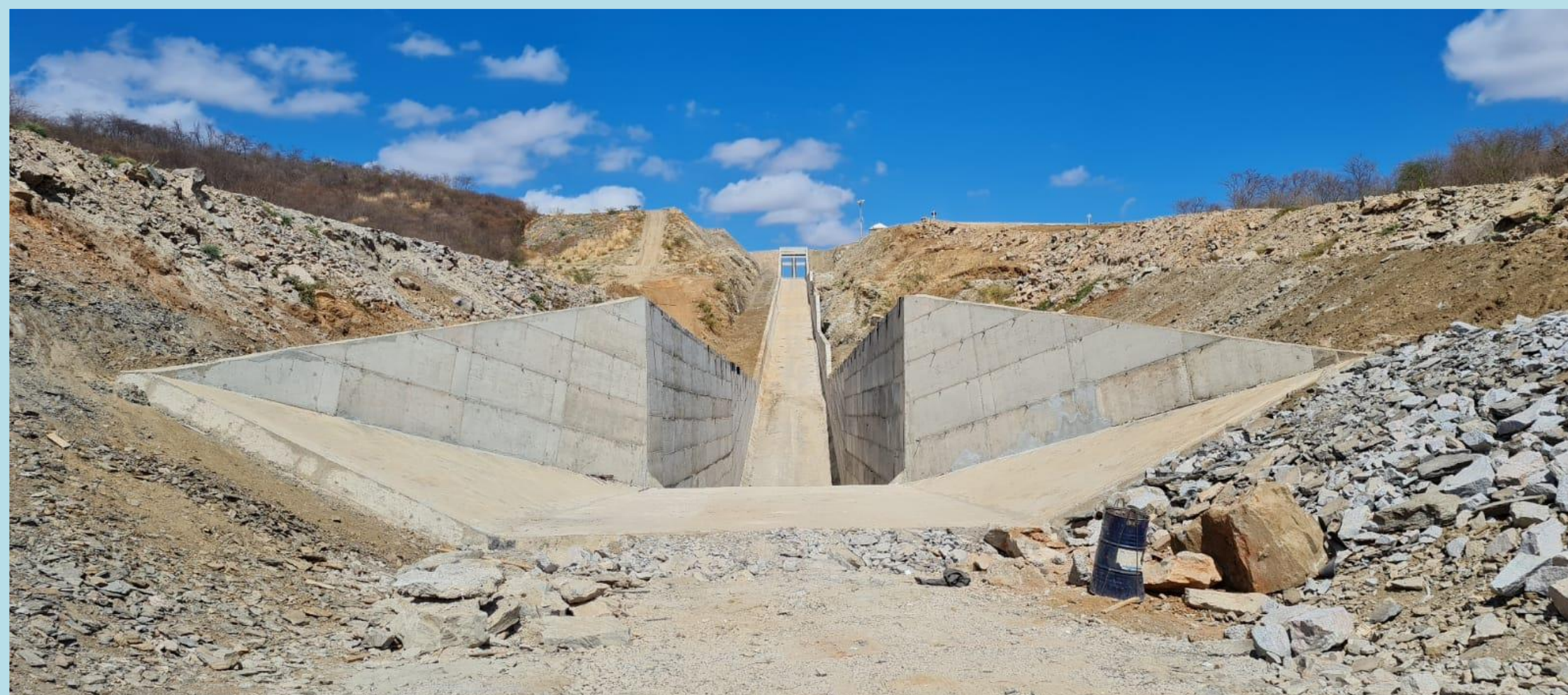
Transição de jusante do Rápido (WBS 1382)
