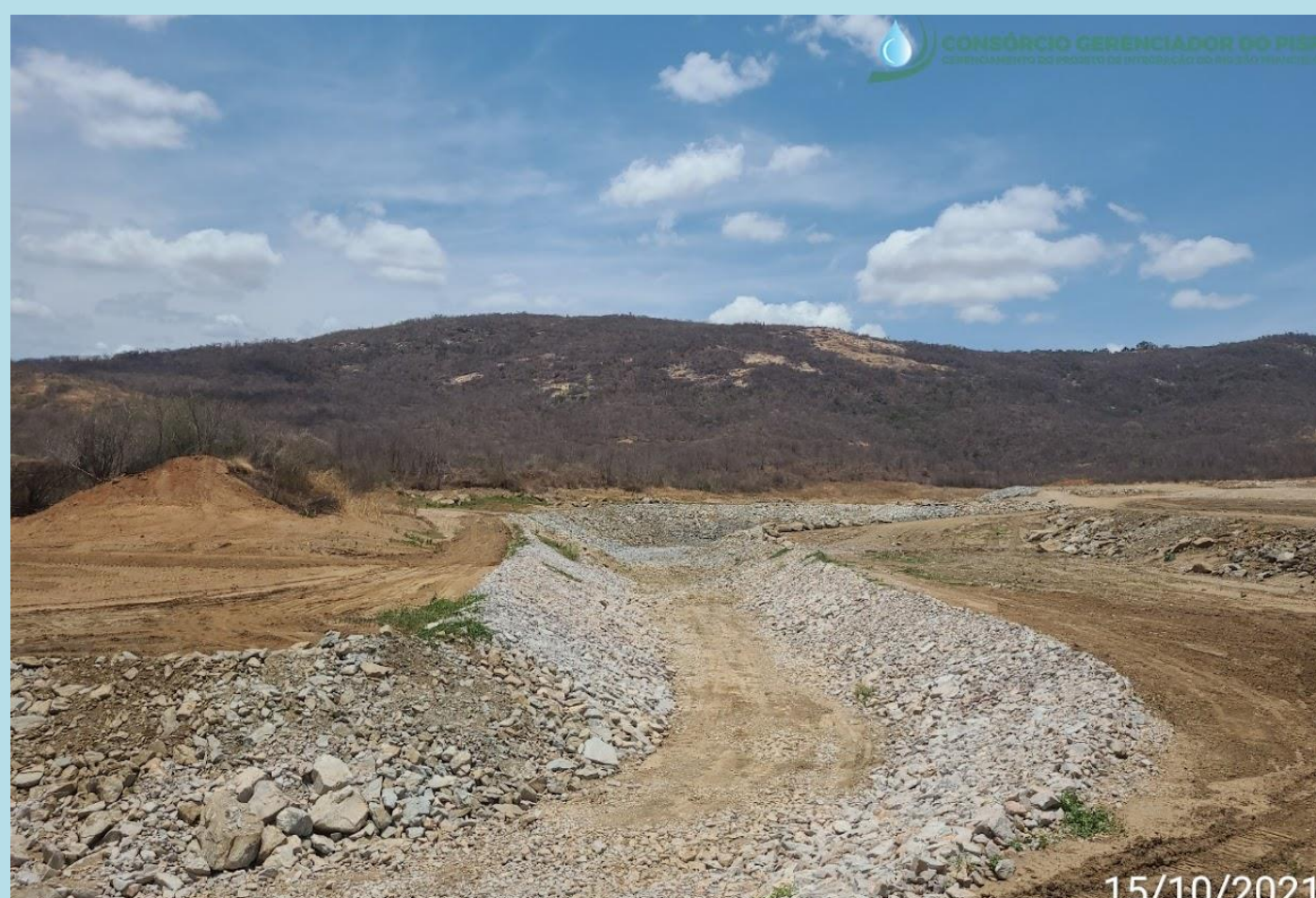
Trecho de Canal enrocado (WBS 1241)
