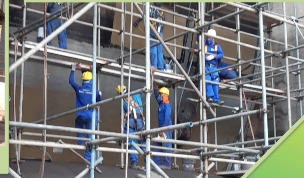
Reservatório Engenheiro Avidos
