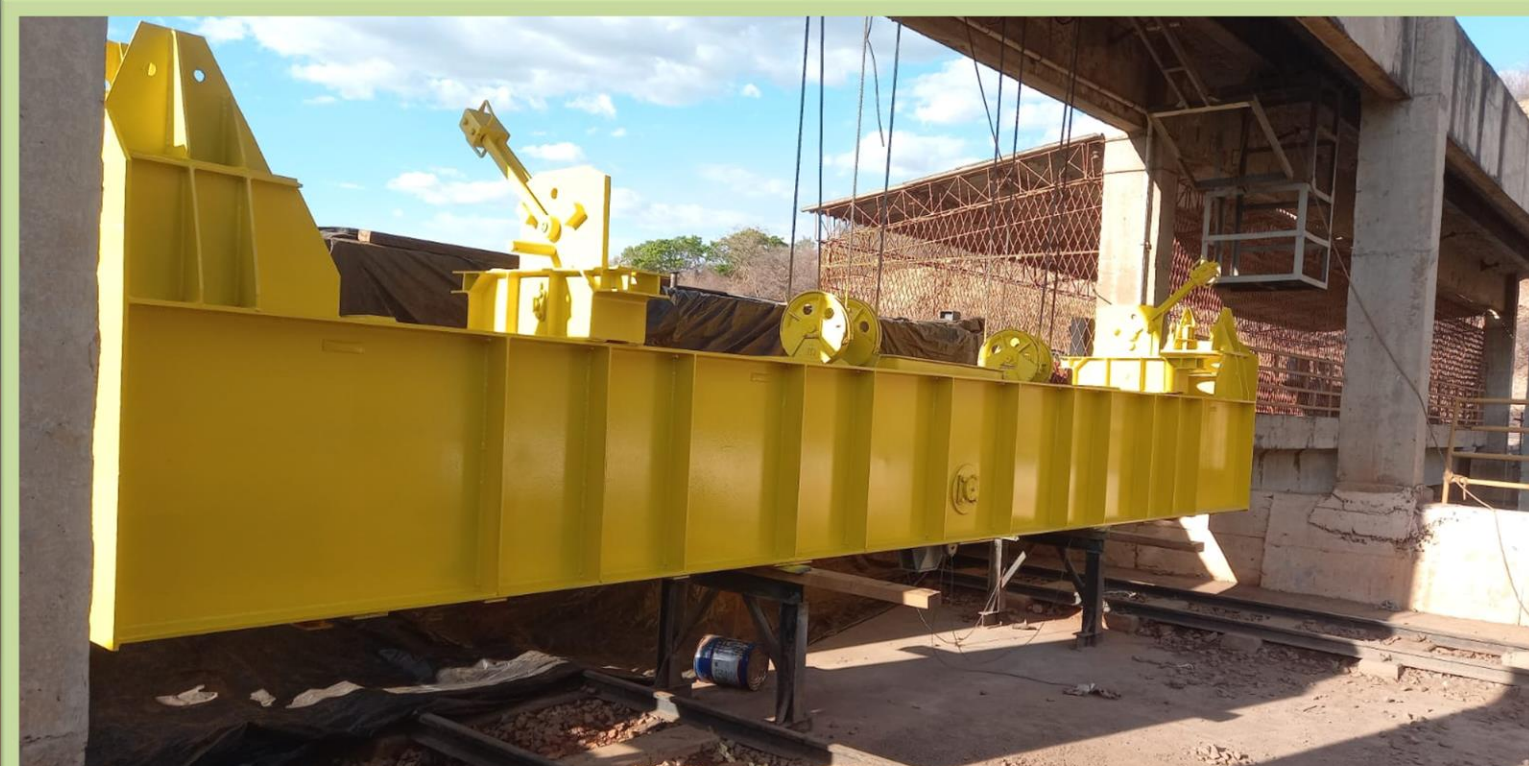
Reservatório Engenheiro Avidos
