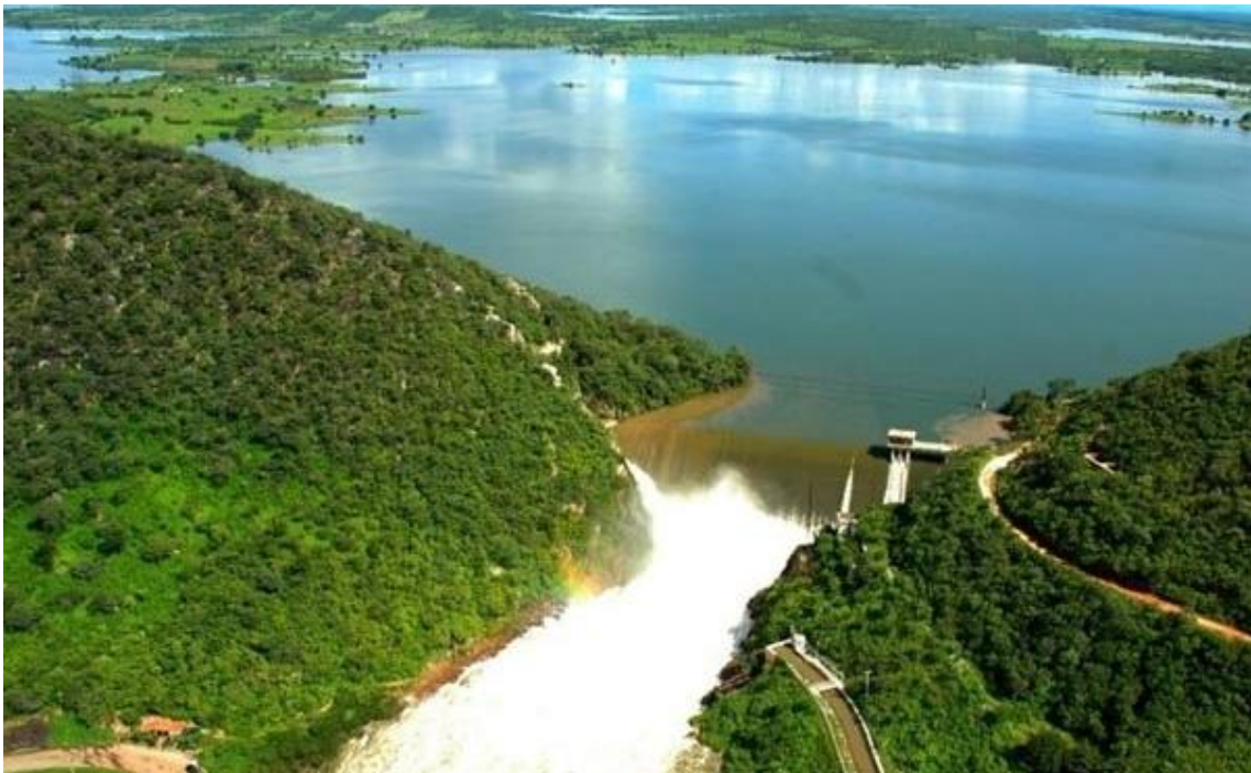
Barragem Curema Mãe D'água (PB)
