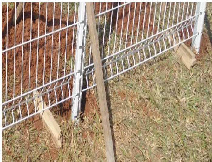
Figura II.6 Calçar os painéis com madeira de modo que fiquem a 10cm a 12cm do solo
