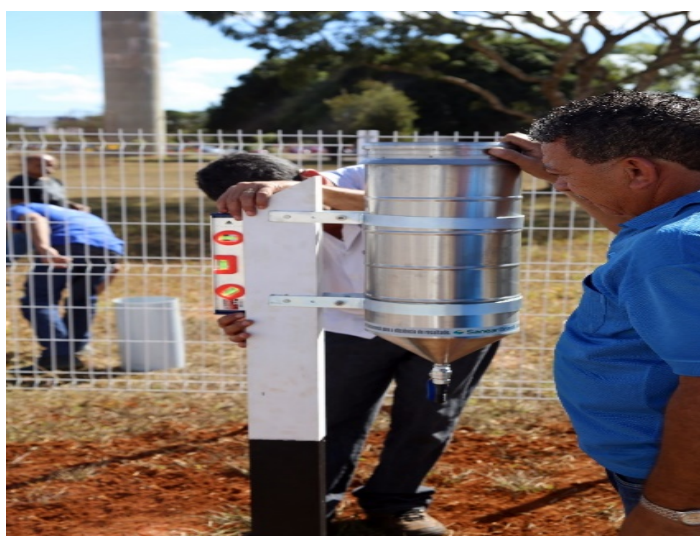
Figura 13: Alinhamento vertical do mourão com nível
