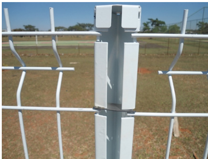
Figura II.5 Instalação das lâminas antifurto com auxílio de alicate apropriado.
