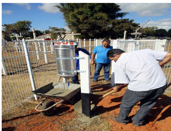
Figura 12 : Detalhe da concretagem da base do mourão
