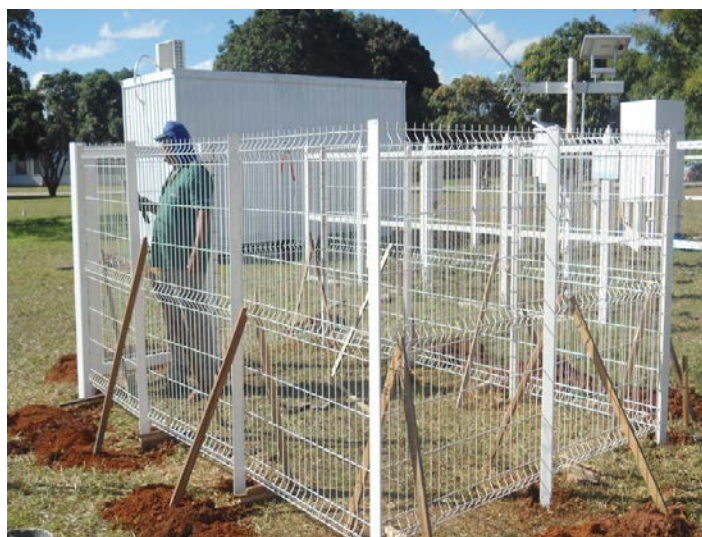
Figura II.9 Apoiar os painéis na vertical com ripas de madeira nos dois lados.
