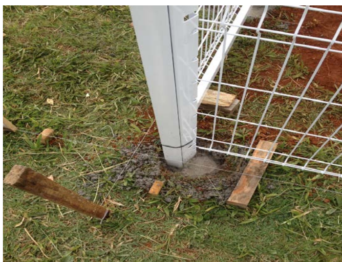
Figura II.11 Concretagem dos postes.
