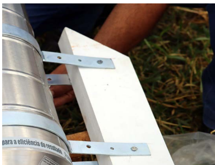
Figura 11 : Detalhe da parte superior do mourão fixado em forma de cunha
