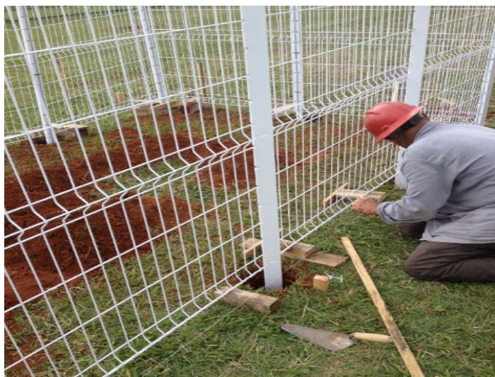
Figura II.8 Verificação do alinhamento dos postes com a linha.
