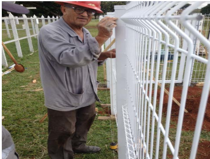
Figura II.7 Verificação do alinhamento do painel com o prumo.
