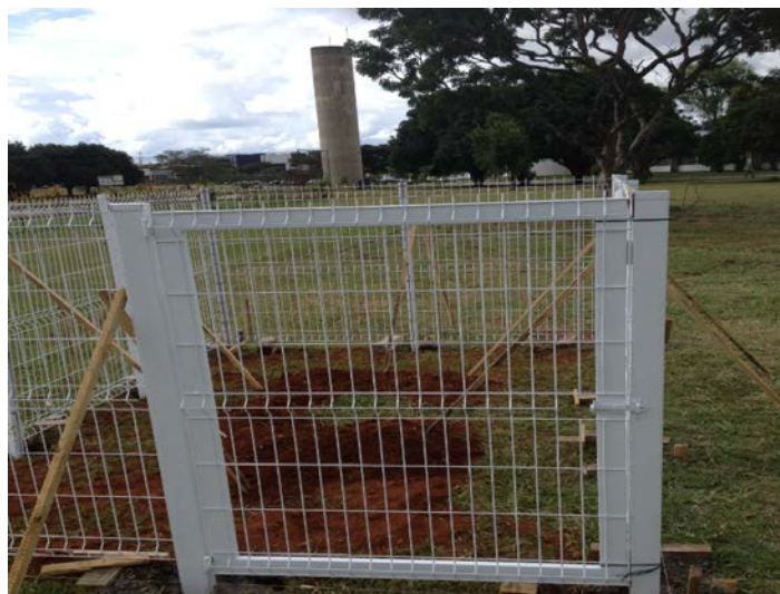
Figura II.10 Instalação do portão.
