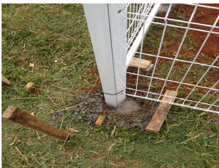
Figura I.11 Concretagem dos postes.
