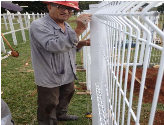
Figura I.7 Verificação do alinhamento do painel com o prumo.
