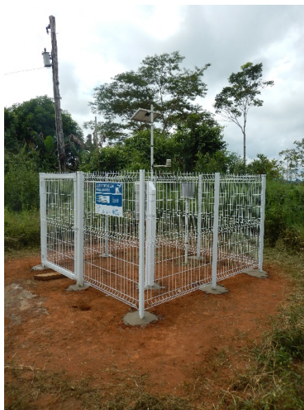
Figura 10- Cercado para proteção da PCD
