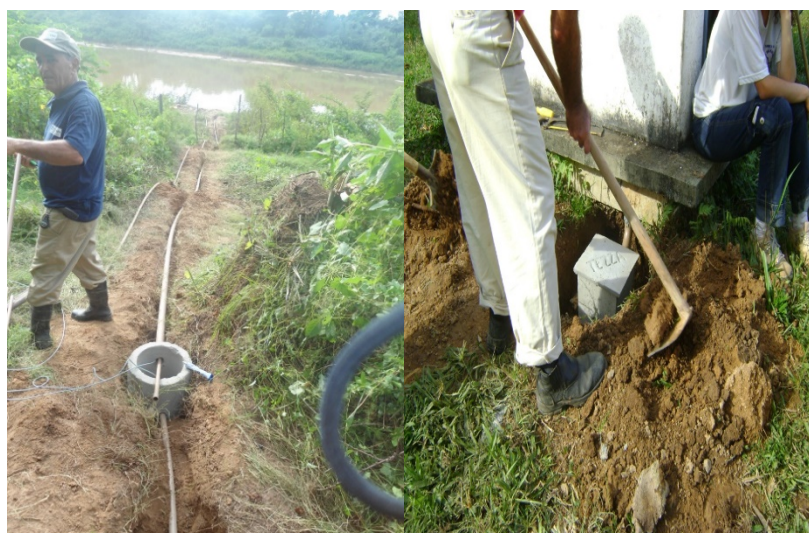
Figura 21- Caixas de passagem em concreto para assentamento do cabo do sensor
