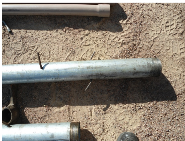
Figura 15- Travamento dos postes metálicos
