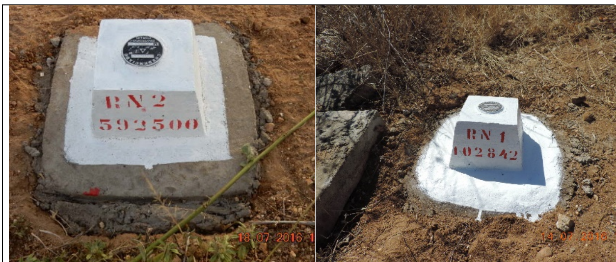
Figura 31 – Padrão construtivo do RN
