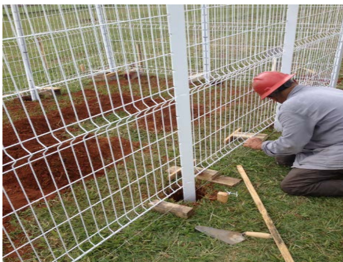
Figura I.8 Verificação do alinhamento dos postes com a linha.
