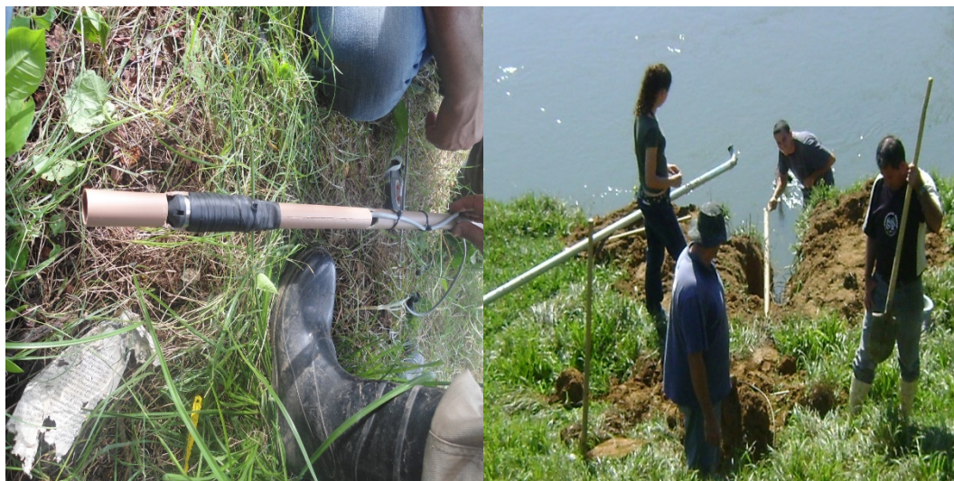
Figura 22- Colocação do sensor de pressão na extremidade do tubo guia.
