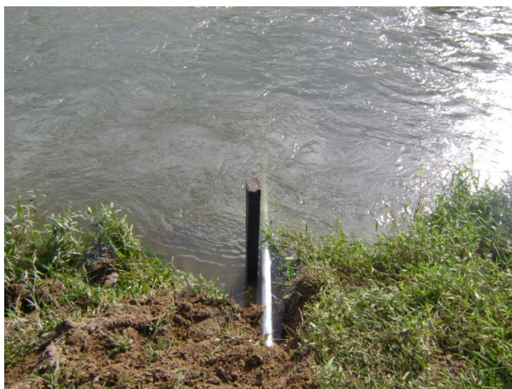
Figura 20- Ancoragem da tubulação em estacas de madeira com cliques de metal
