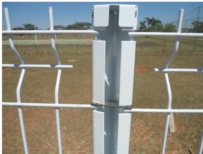
Figura I.5 Instalação das lâminas antifurto com auxílio de alicate apropriado.
