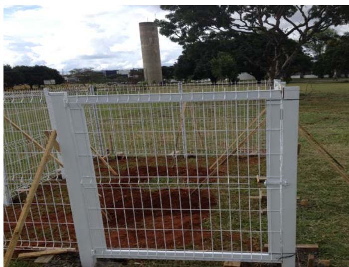
Figura I.10 Instalação do portão.
