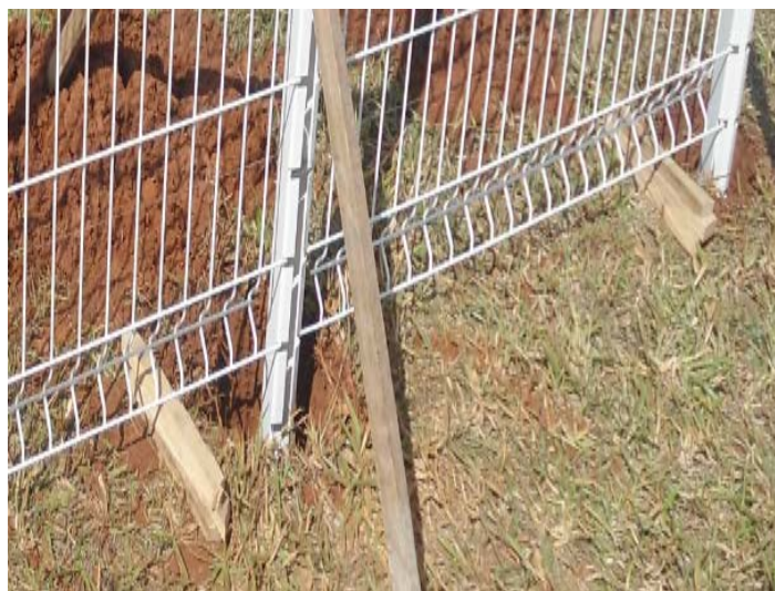
Figura I.6 Calçar os painéis com madeira de modo que fiquem a 10cm a 12cm do solo
