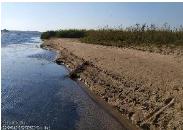
Figura 39: Imagem do barranco ilustrando a redução de cota no Ponto 1, em 07/07/2021. Coordenadas: 22°29'3,69"S, 52°59'52,70"O.
