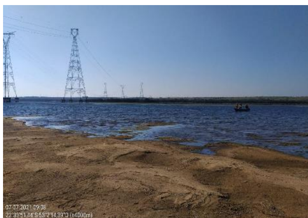
Figura 21 – Vista da região do pedral (margem direita), registro fotográfico de 07/07/2021. Coordenadas: 22°33'51,44"S, 53°02'14,39"O.
