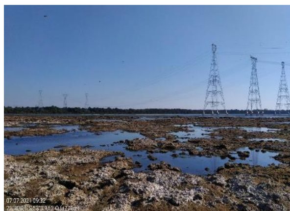
Figura 22 – Vista da região da linha de transmissão, registro fotográfico de 07/07/2021. Coordenadas: 22°30'9,1"S, 53°00'9,62"O.
