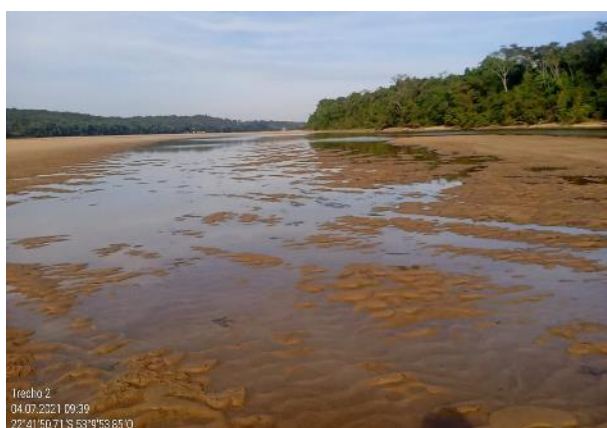
Figura 37 – Área crítica localizada entre o Ponto 5 e a lagoa, em 04/07/2021. Coordenadas: 22°41'50,71"S, 53°9'53,85"O.
