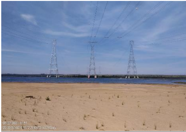
Figura 23 – Vista da região do pedral (margem direita), em 04/07/2021. Coordenadas: 22°33'54,02"S, 53°02'24,06"O.
