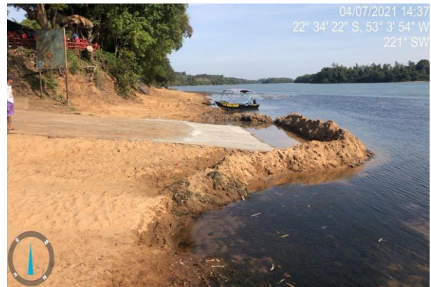
Figura 67 – Rampa do Balneário de Rosana em obras para melhoria, em 04/07/2021. Coordenadas: 22°34'22"S, 53°03'54"O.
