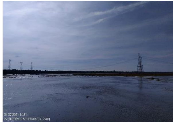
Figura 24 – Vista da região da linha de transmissão, em 04/07/2021. Coordenadas: 22°30'20,24"S, 53°00'23,06"O.
