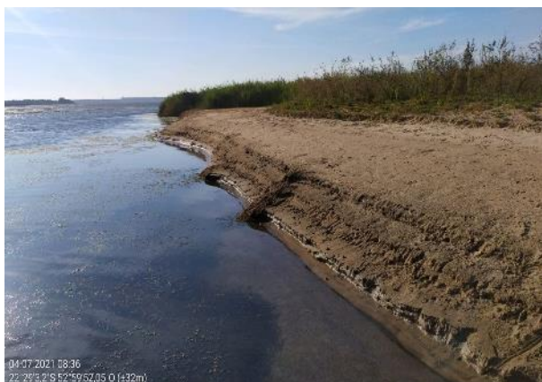
Figura 11 – Imagem do barranco ilustrando a redução de cota no Ponto 1, em 04/07/2021. Coordenadas: 22°29'3,2\"S, 52°59'52,05\"O.
