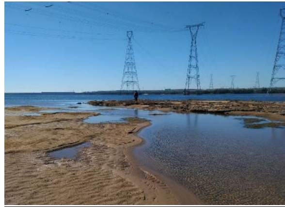
Figura 24 - Vista da região da linha de transmissão, em 03/07/2021. 22°29'53"S; 52°0'25"O
