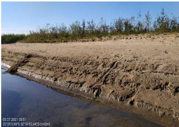
Figura 11 – Imagem do barranco ilustrando a redução de cota no Ponto 1, em 03/07/2021. Coordenadas: 22°29'3,98"S, 52°59'52,44"O.
