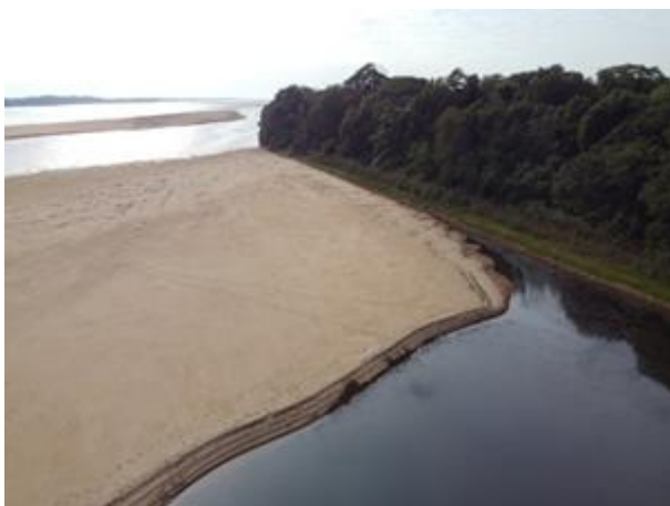
Figura 39 – Vista geral da área a ser desconectada do rio Paraná, em 01/07/2021. Coordenadas: 22°46'47,03"S; 53°21'17,06"O.
