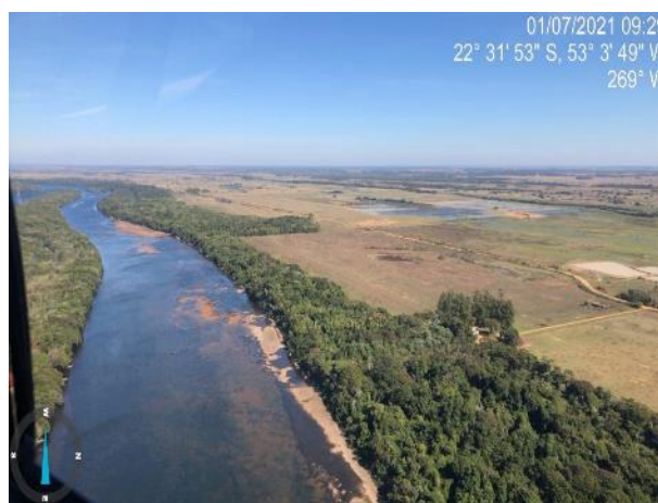
Figura 25 - Vista da região da linha de transmissão em 01/07/2021. Coordenadas: 22°31'53"S, 53°03'49"O.
