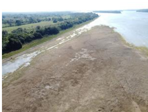
Figura 40 – Vista geral da área a ser desconectada do rio Paraná, em 01/07/2021. Coordenadas: 22°46'47,03"S; 53°21'17,06"O
