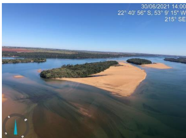
Figura 38 – Vista geral da área a ser totalmente desconectada no Ponto 5, em 30/06/2021. Coordenadas: 22°40'56"S, 53°9'17"O.
