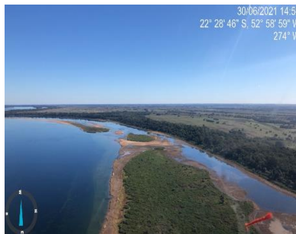
Figura 25 - Vista da região da linha de transmissão em 30/06/2021. Coordenadas: 22°29'8,39"S, 52°59'43,81"O.
