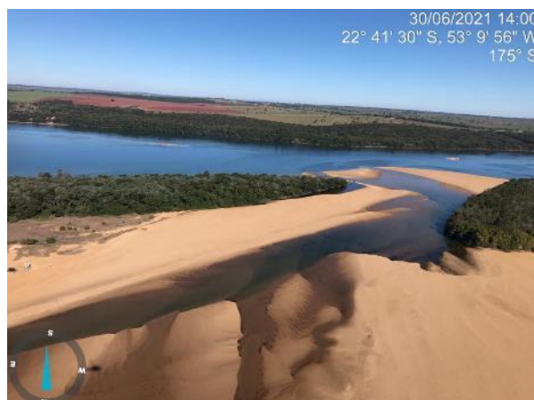
Figura 39 – Vista geral da área a ser totalmente desconectada no Ponto 5, em 30/06/2021. Coordenadas: 22°41'10"S, 53°9'34"O.
