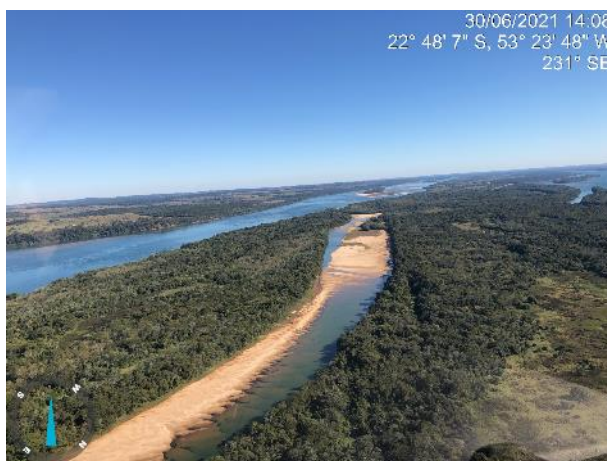
Figura 64 - Vista do trecho a ser totalmente seco, mantido o secamento, em 30/06/2021. Coordenadas: 22°48'5"S, 53°23'33"O.
