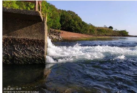
Figura 26 – Detalhe da escada de peixes no Trecho 1, em 26/06/2021.
