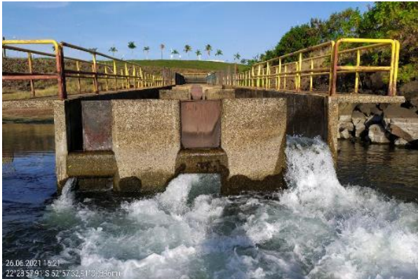
Figura 25 – Detalhe da escada de peixes no Trecho 1, em 26/06/2021.
