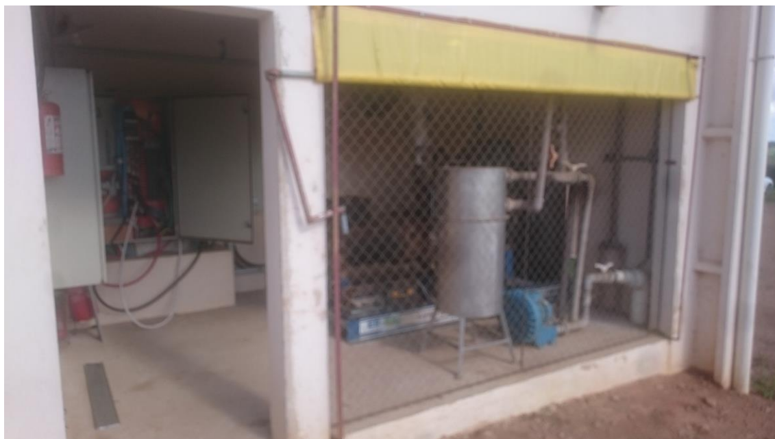
Cerca de 45% da energia consumida nos confinamentos e sala de ordenha vem do biogás, por meio de um gerador de 120 KVA
