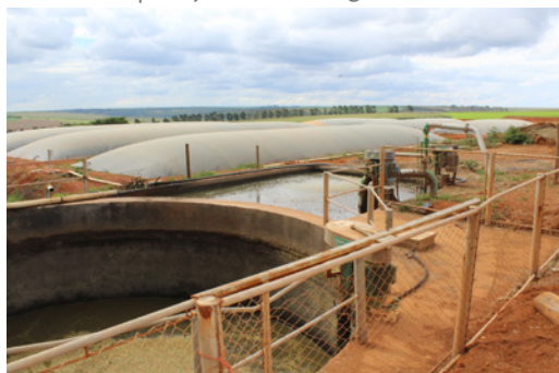
FIGURA 20 | Conjunto de biodigestores.
