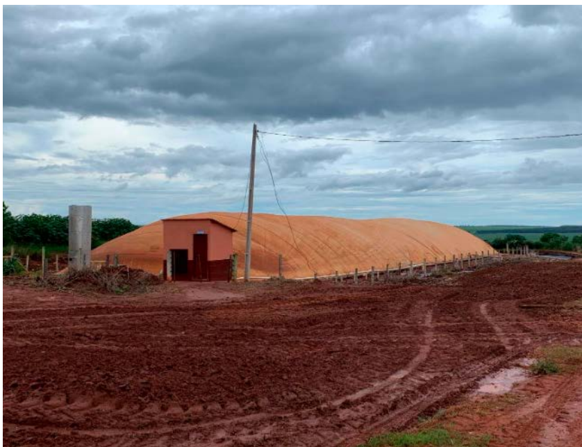
Figura 27 - Biodigestor: Dejetos da produção de suínos. (Créditos: Breno Menezes de Campos)
