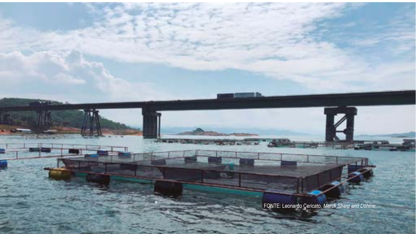
FIGURA 5.14 - Tanques-rede de grande volume em reservatório
