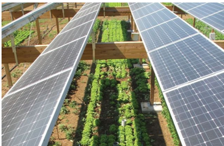
Sistema agrofotovoltaico piloto de 50 kWp da Universidade de Montpellier (Cultivo de alface e outras hortaliças), 2018, França.
