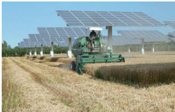
Sistema agrofotovoltaico de 800 kWp em Campo d'Eco (Cultivo de tomate, melancia, frutas da estação e trigo) 2014, Itália.
