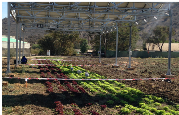
Sistema Agrofotovoltaico piloto de 13 kWp do Instituto Fraunhofer ISE (Cultivo de alface), 2019, Chile.
