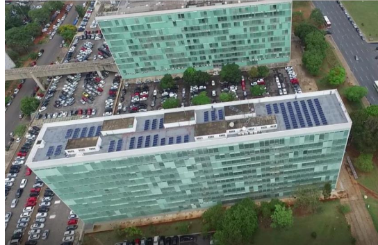
Telhado de edifício público, sede do MME, Brasília (DF).
