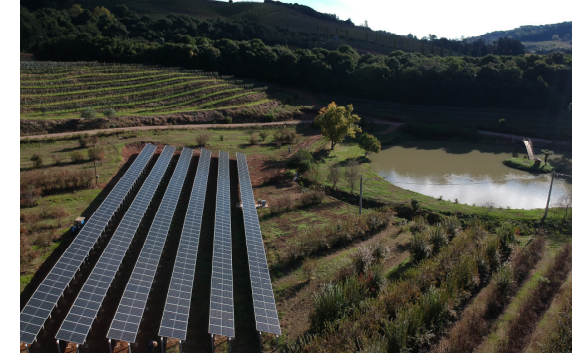
Sistema de solo em propriedade rural vinícola, Pinto Bandeira (RS).
