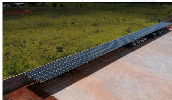
Cobertura de estacionamento de distribuidora de frutas, Santa Cruz do Sul (RS).
