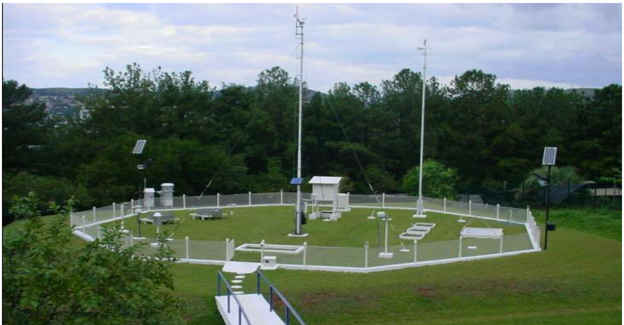
Figura 18: Estação Convencional e Automática em Operação em Porto Alegre - RS
