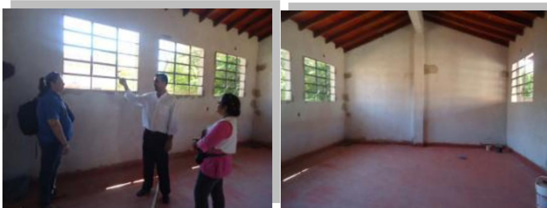
Foto: Cocina comedor de la Escuela Básica N° 28 “PROCERES DE MAYO” en etapa de construcción final, con su director Profesor Fabio Bazán.
